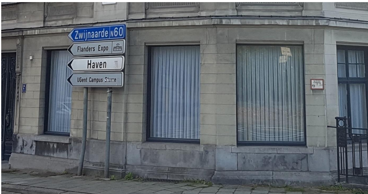
Fig. 27: Aangepaste ramen, waarbij het linkse venster een afwijkende dorpel heeft.
