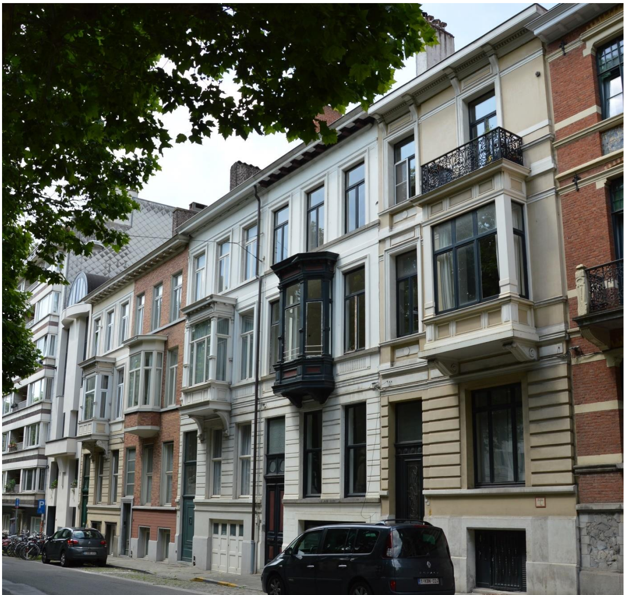
Fig. 87: Overzicht van het gevelensemble, waarbij de vijf huizen door hun bijna identieke gevelafwerking, vormgeving, stijl en verhoudingen een ensemble vormen, maar nummer 20-26 (uiterst rechts) hoort niet bij de oorspronkelijke bouwaanvraag.
