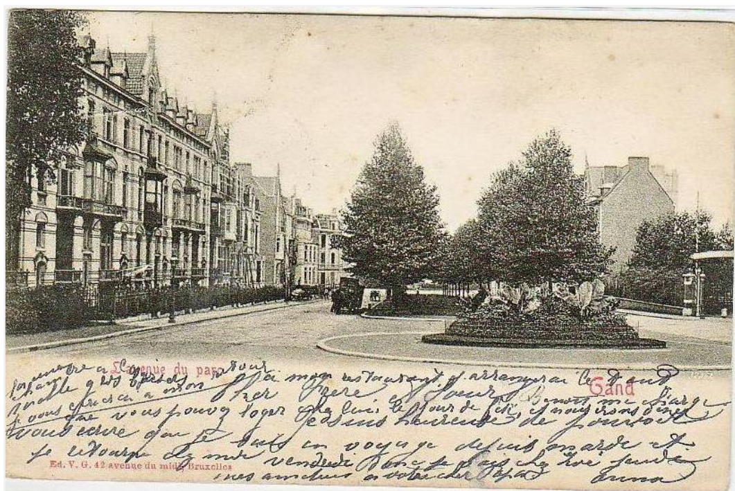
Foto 17: Foto van de Parklaan tijdens de constructie van de laatste huizen (circa 1901).
