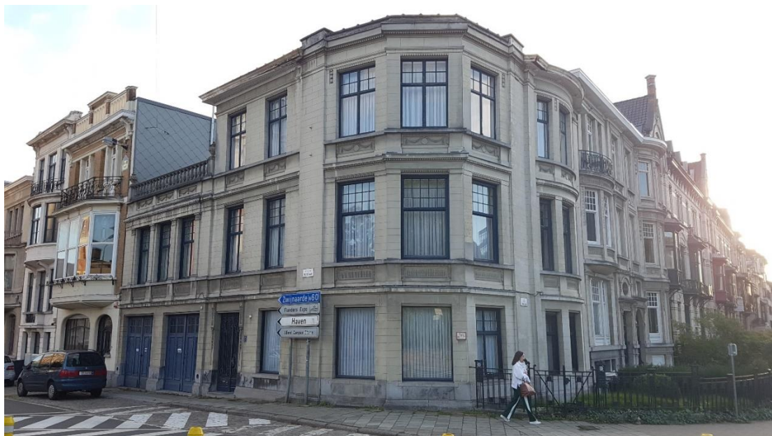
Fig. 17: Overzicht van de gevel op de hoek van de Krijgslaan met de Parklaan.
