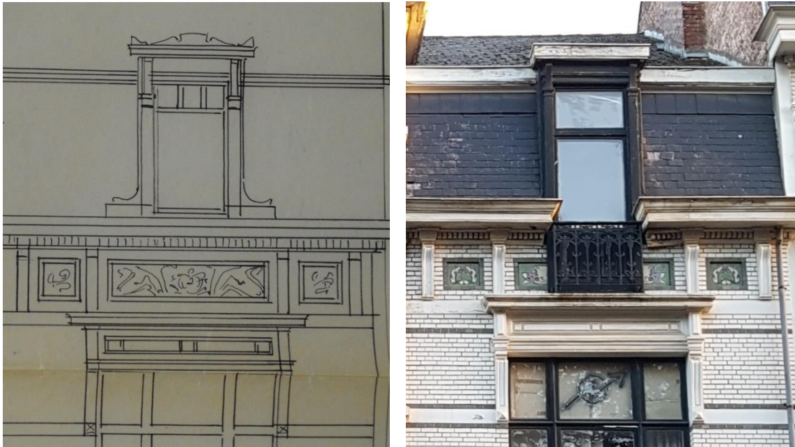
Fig. 54: Links: Originele toestand met doorlopend graffitopaneel en kroonlijst 165 ; Rechts: Toestand na de verbouwing waarbij de borstwering opengemaakt werd en een nieuw raam met smeedijzeren balustrade geplaatst werd. Hierbij werd de bakgoot met recuperatieboordplanken afgewerkt aan de uiteinden.
