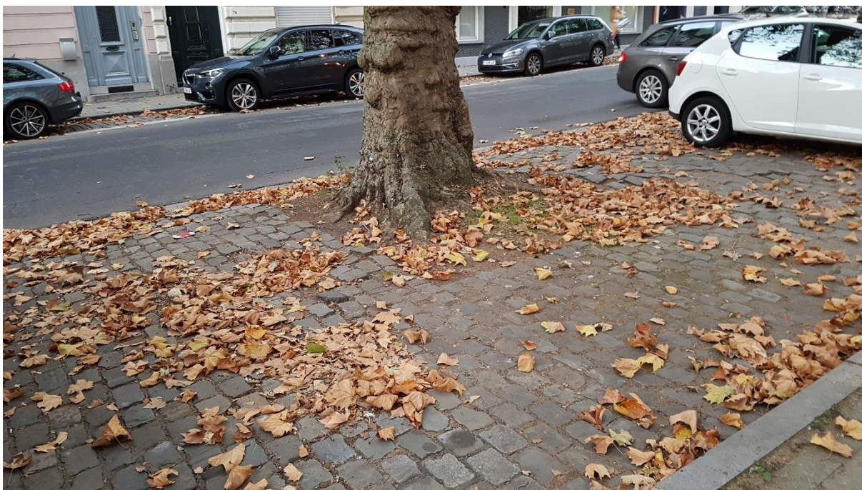
Fig. 8: Geasfalteerde weg met kasseibedekking ter hoogte van de parkeerstrook met uitsparingen voor de bomen.
