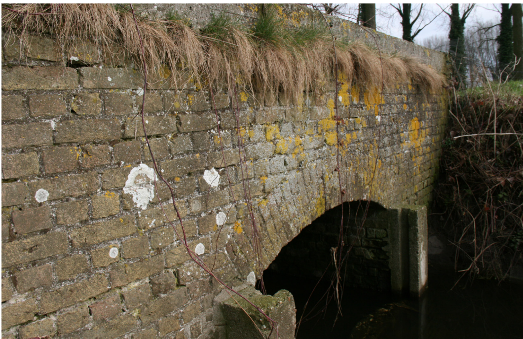
Foto 79: Bij het tweede sluisje is de sluisdeur niet meer aanwezig. Foto Arnout Zwaenepoel, februari 2017.
