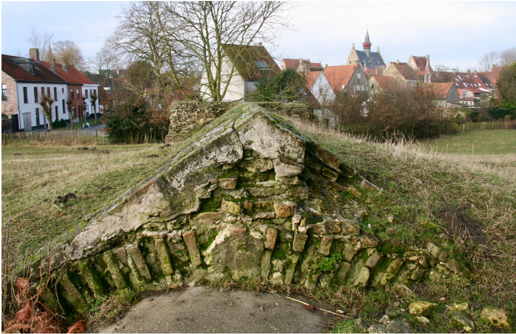
Foto 60: Het 45° hellende dakgedeelte van het buskruitmagazijn is minder bijzonder qua lichenenbegroeiing. Foto Arnout Zwaenepoel, februari 2017.
