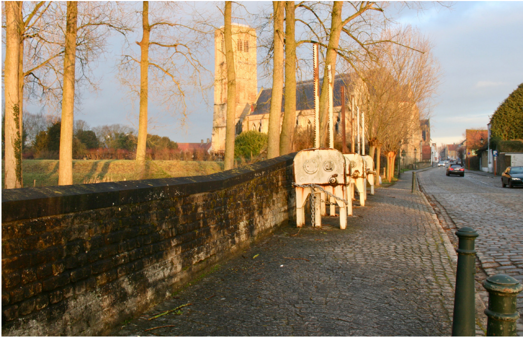
Foto 2: De brug over het Zuidervaartje in de Kerkstraat. Bakstenen metselwerk en arduinen dekstenen. Foto Arnout Zwaenepoel, februari 2017.
