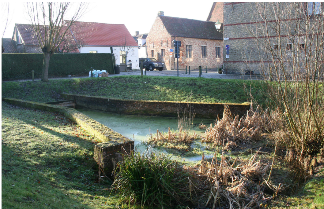
Foto 68: Het in 1984 opgegraven sluisje van de Lieve werd hersteld met grotendeels nieuw gemetste bakstenen muurtjes. Foto Arnout Zwaenepoel, februari 2017.
