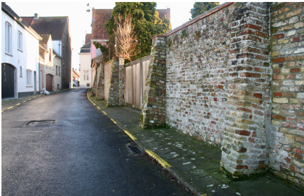
Foto 66: De tuinmuur in de Kattestraat. Foto Arnout Zwaenepoel, februari 2017.
