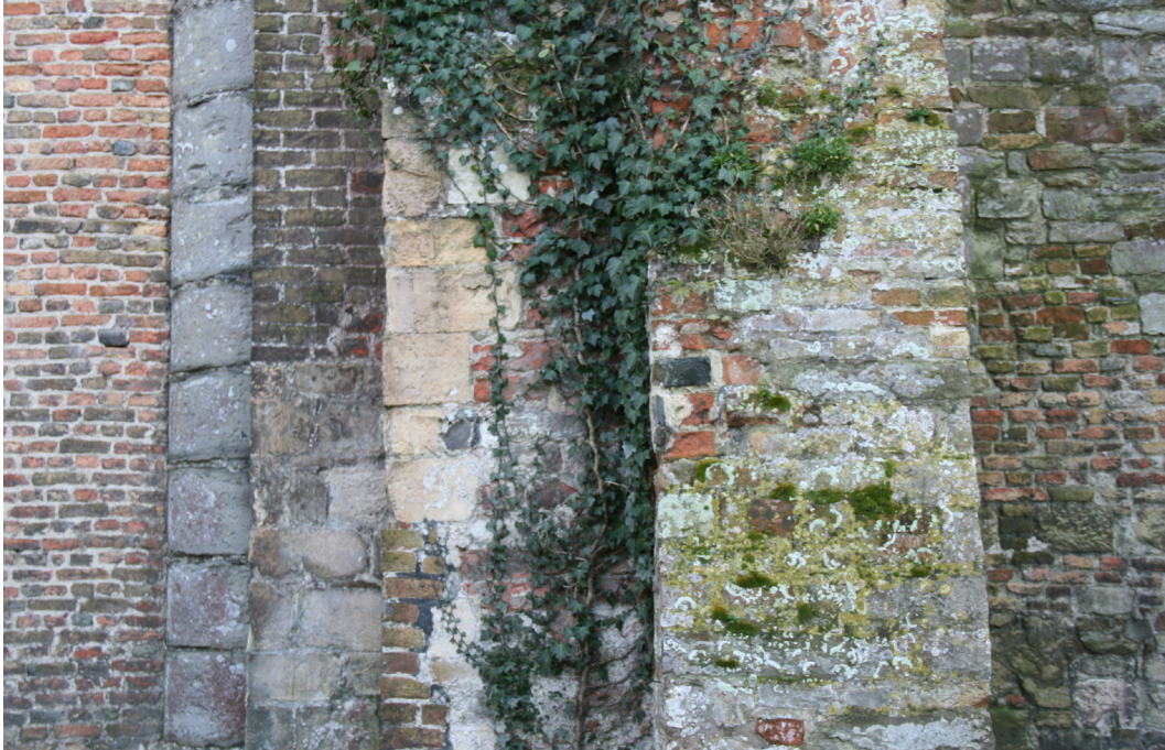
Foto 28: De foto toont heel duidelijk hoe alleen de steunberen gespaard werden van reiniging bij de restauratie. Op de steunberen groeien bovenaan in beeld enkele Muurbloemen ( Erysimum cheiri ) en wat Plat beemdgras ( Poa compressa ). Beneden bepalen Gelobde citroenkorst ( Caloplaca flavescens ; geel) en Kauwgommos ( Diploicia canescens ; blauwwit) het aspect. Foto Arnout Zwaenepoel, februari 2017.
