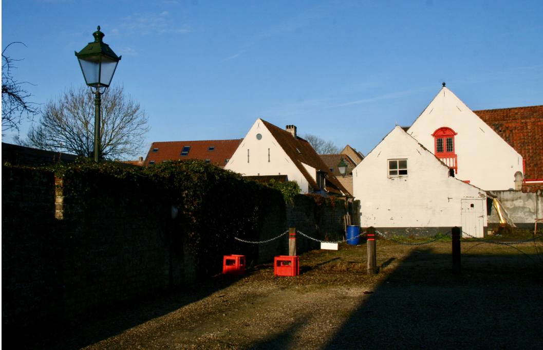
Foto 35: De muur naast de parking in de Sint-Jansstraat. Foto Arnout Zwaenepoel, februari 2017.
