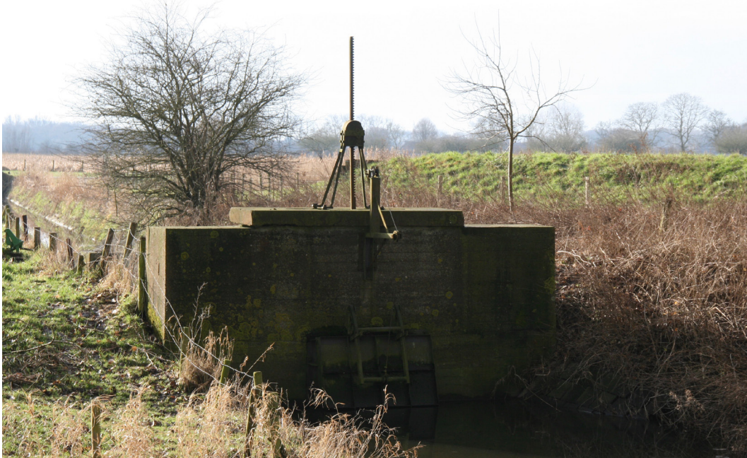
Foto 77: De belangrijkste sluis van de drie sluisjes. Foto Arnout Zwaenepoel, februari 2017.
