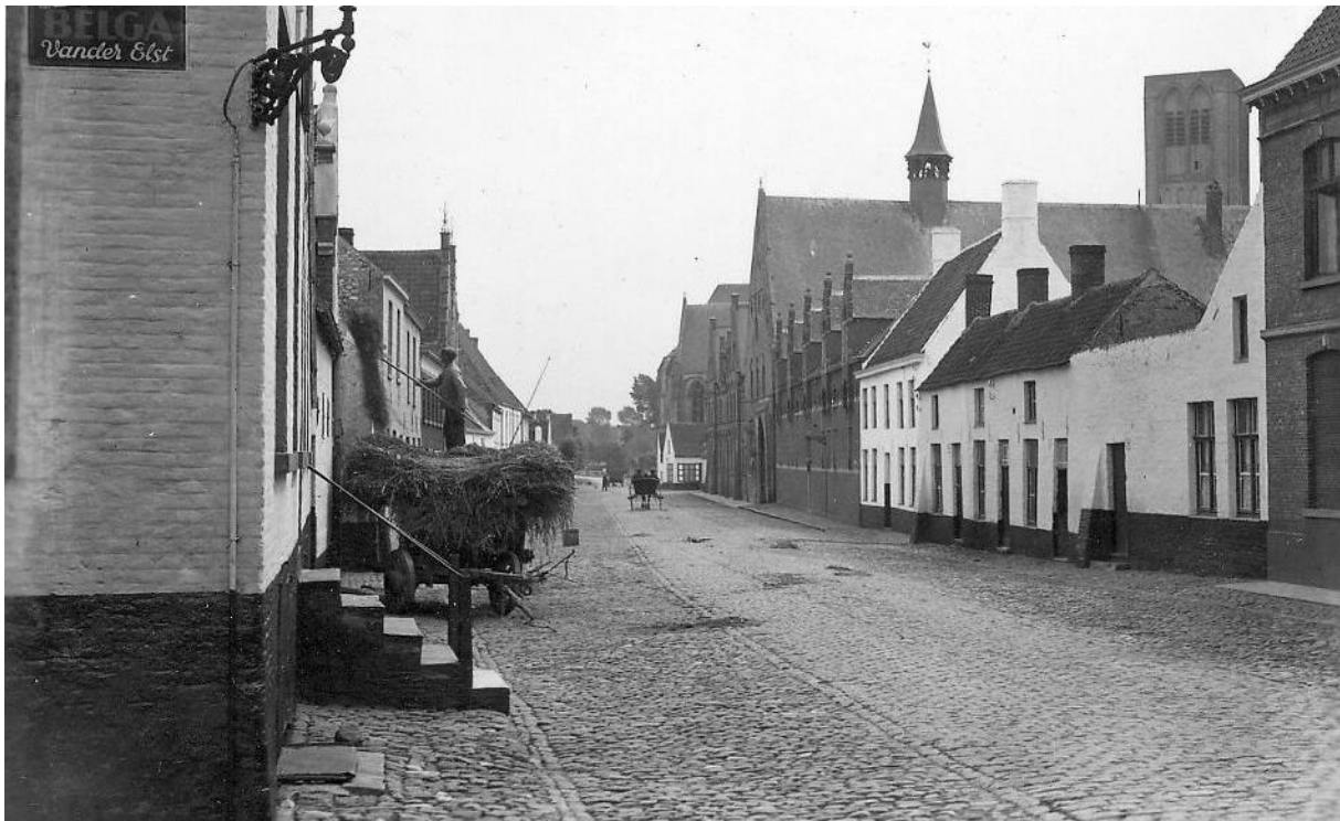
De bestrating van de Kerkstraat in 1943 (foto KIK e024096). Bij de heraanleg van de middenstrook, werden de oude kasseien op de zijstroken aangewend. Enkel voor de openbare gebouwen – hospitaal – en de herenhuizen zijn voetpaden aangebracht.
