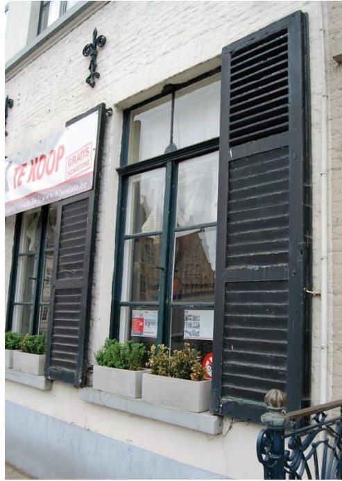
Origineel 19 de eeuwse schrijnwerk. Links: Kerkstraat 37, houten kruisraam voorzien van schuiframen en drieledige luiken op duimen in het metselwerk. Rechts: Kerkstraat 11, T-raam met schuiframen uitgerust met panelen voorzien van persiënnes in het bovenste vak.
