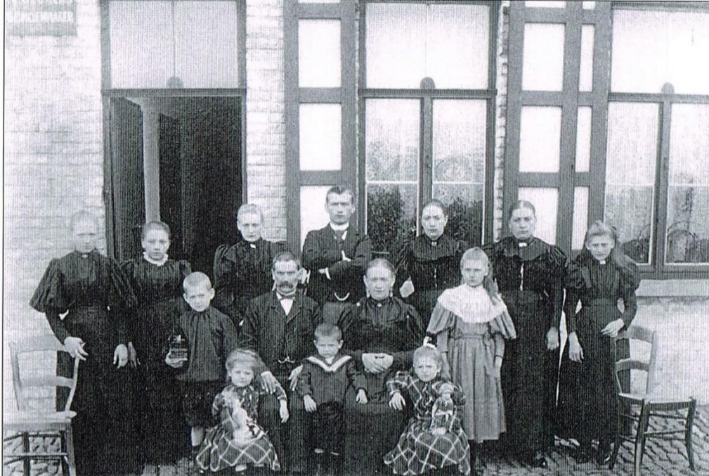
Damme, Burgstraat 14, 19 de eeuwse T-ramen met drieledige luiken. Dit schrijnwerk is intussen vervangen door goede kopieën met een dubbele beglazing.
