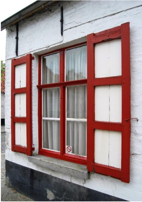
Origineel 19 de eeuwse schrijnwerk. Links: Kerkstraat 37, houten kruisraam voorzien van schuiframen en drieledige luiken op duimen in het metselwerk. Rechts: Kerkstraat 11, T-raam met schuiframen uitgerust met panelen voorzien van persiënnes in het bovenste vak.
