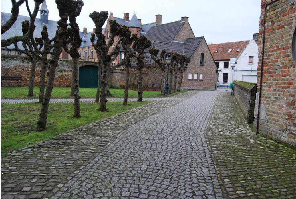
Toegangsweg, toestand in 2016. De middenstrook werd herlegd met waaivormig gelegde platte kasseien. De oude kasseien zijn herbruikt in de randbekleding.
