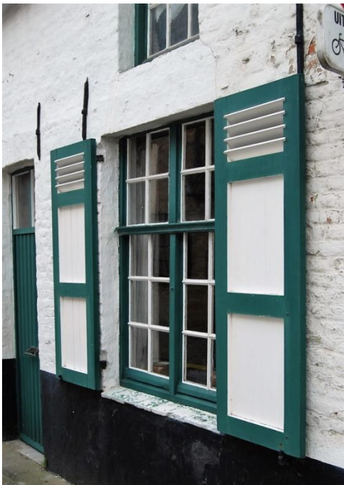
Origineel 19 de eeuwse schrijnwerk. Links: Ketelstraat 1, houten kruisraam oorspronkelijk voorzien van schuiframen en nieuwe luiken op duimen in het metselwerk. Hun verhouding klopt niet.
