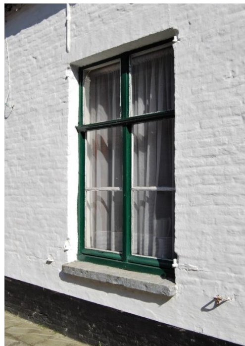
Origineel 19 de eeuwse schrijnwerk. Links: Ketelstraat 1, houten kruisraam oorspronkelijk voorzien van schuiframen en nieuwe luiken op duimen in het metselwerk. Hun verhouding klopt niet.
