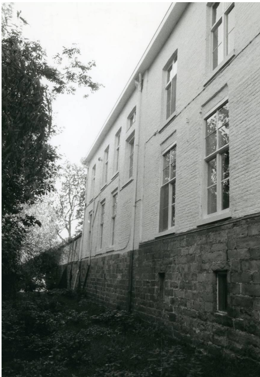
Figuur 78: Achtergevel (noord) van de herenwoning – foto-opname uit 1981 (inventarisatie Onroerend Erfgoed).
