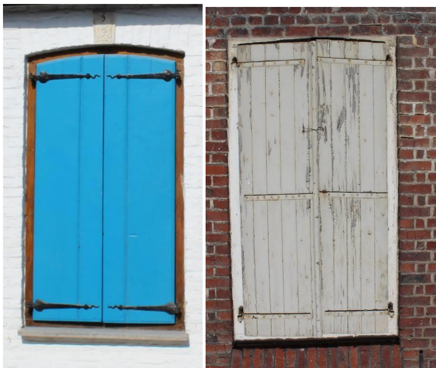
Figuur 147 - 148: Twee maal luikduimen in het kozijn in de Vijfhoekstraat. Links nr. 18 met sierlijk uitgesmede gehengen, rechts met een eenvoudiger model rechthoekige sectie. Rechts (nr. 2) zijn de gehengen ook de elementen die de geëmbreeverde planken samen houden, met nog een extra metalen lat in het midden.
