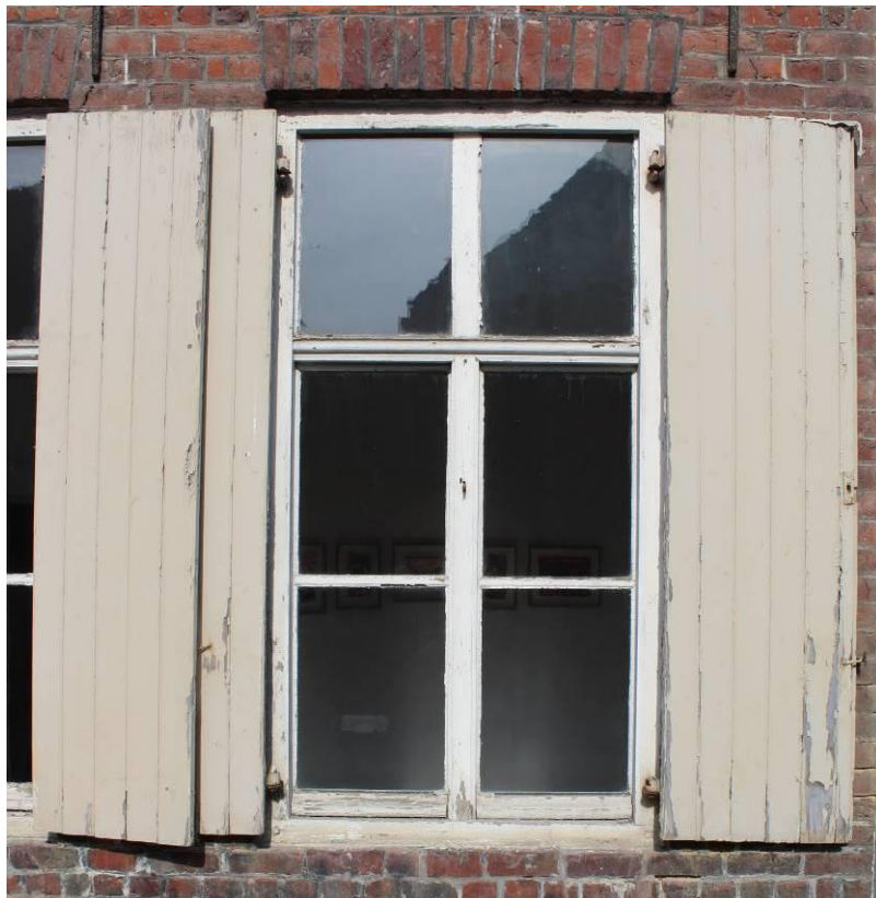
Figuur 129: Vijfhoekstraat 2 – luiken van het type geëmbreveerde planken (toestand gesloten luiken zie Figuur 147).
