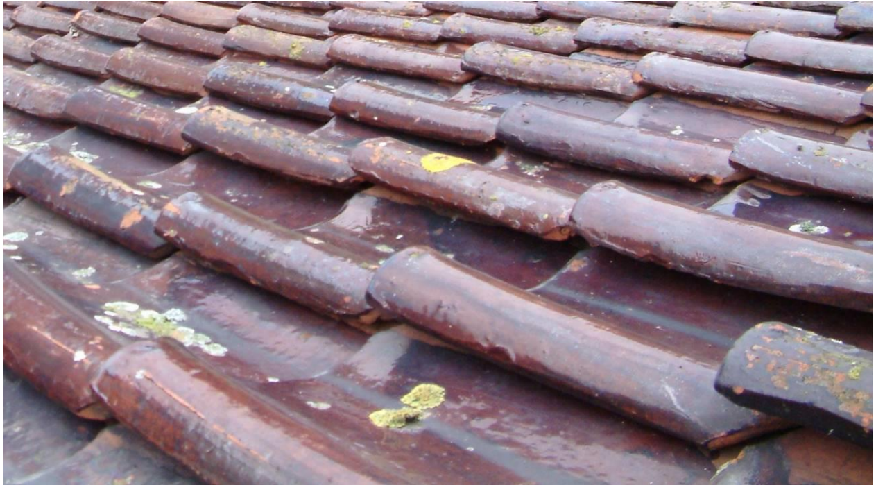
Figuur 169: Aspect liggend in een dakvlak van de pan 'Roy-Coevoet à Poperinge' van de vorige figuur. Typevoorbeelden Poperingse productie.
