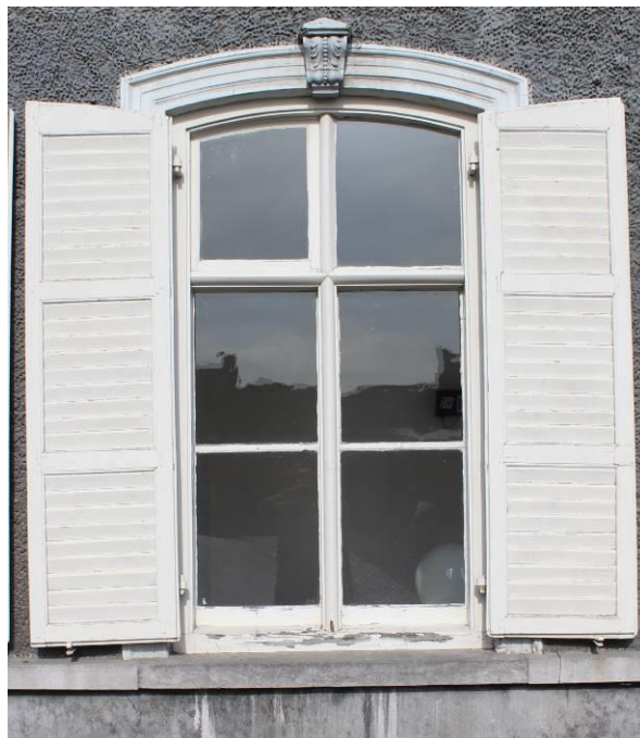
Figuur 83: Herenhuis Watouplein 12 – kruiskozijnraam met amandelprofiel op de middenstijl en wisseldorpel.
