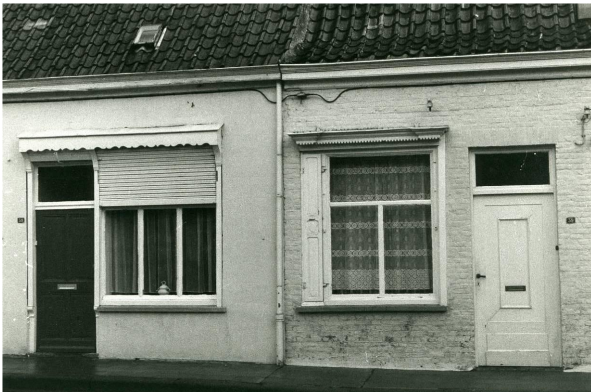
Figuur 115: Twee winkelpuien ter hoogte van huidige adressen Kleine Markt 38 en 39. Links ontstaan uit een gekoppelde winkelkozijn en deurkozijn (zie inventaris) en verbouwd vermoedelijk omstreeks 1940, rechts een later 19 de eeuwse type, mogelijk ook ontstaan uit een kozijn, ook hier al met recentere invullingen (foto inventaris Onroerend Erfgoed - 1981) – verdwenen erfgoedelementen .
