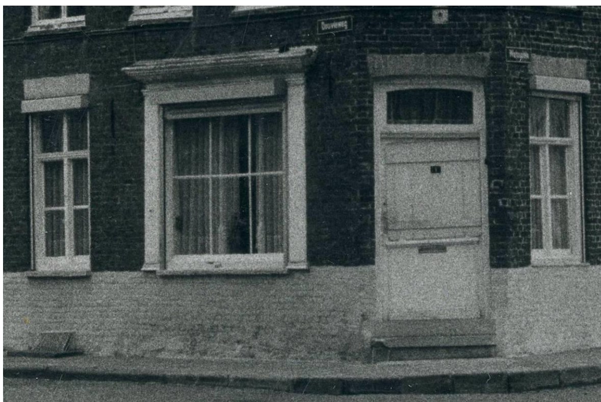
Figuur 114: Uitbektelede winkelpui voorheen in Watouplein 1 (Ovenhuis) – afgaande op de aanwezige blokkozijnramen op de gelijkvloerse verdieping ontstaan uit het oudere type winkelkozijn. Reeds verbouwde indeling, volgens de beschrijving in 1989 binnenin ondersteund door ijzeren zuiltjes (foto inventaris Onroerend Erfgoed - 1981) – verdwenen erfgoedelement .
