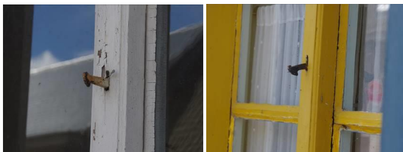
Figuur 154 en 155 : twee luiksluiters (opklikkend veersysteem?) in de Vijfhoekstraat
