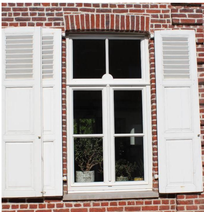
Figuur 122: Vijfhoekstraat 16 – laat 19 de eeuwse schrijnwerken met dubbel opendraaiende vleugels (hier evenwel al in vertaling naar dubbele beglazing).
