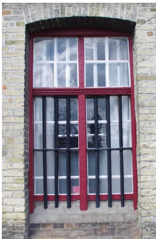
Figuur 87: Getande wisseldorpel in de sacristie van 1804 tegen het zuidkoor van de Sint-Bavokerk.
