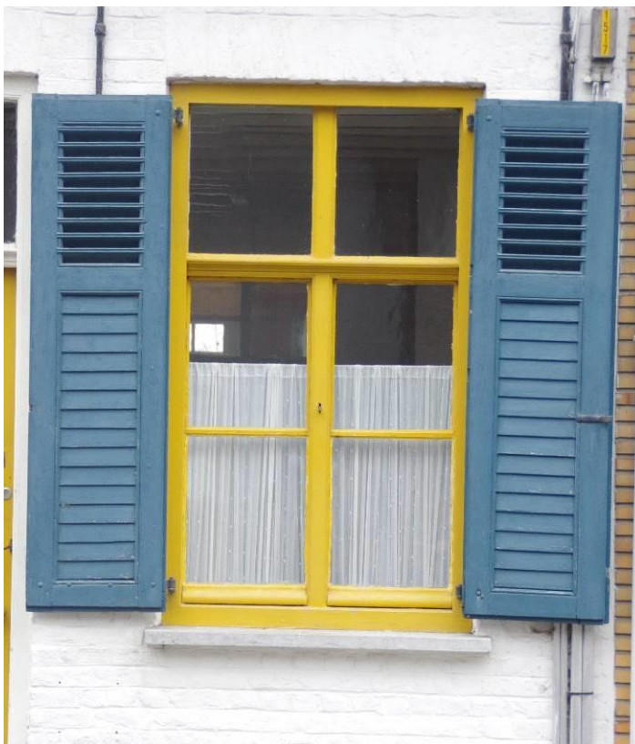
Figuur 132: Vijfhoekstraat 8 – het laat 19 de -eeuwse type paneelluiken met persiennes in het bovenste paneelvak.
