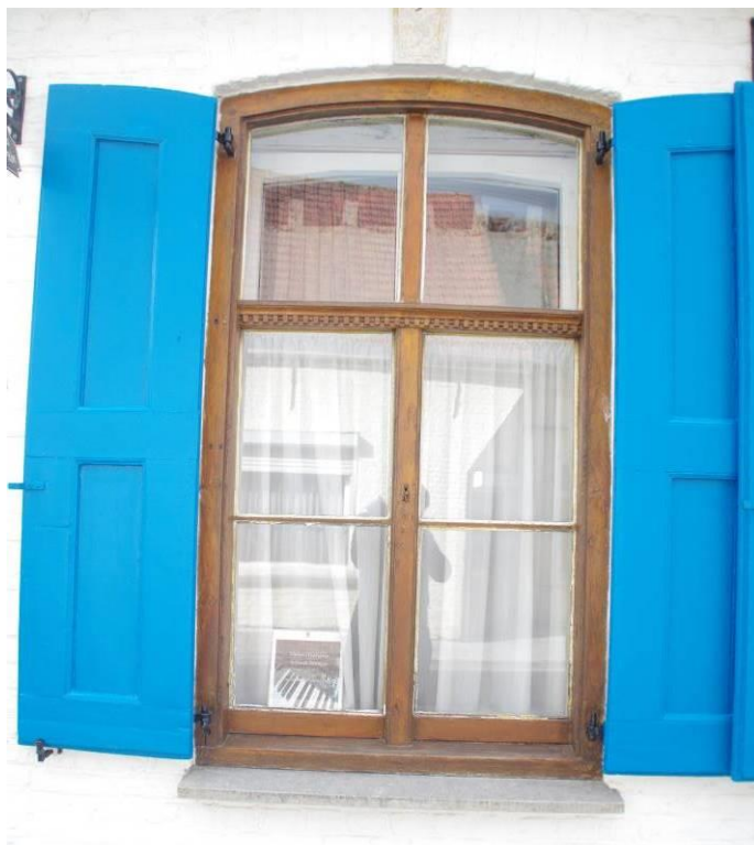
Figuur 130: Vijfhoekstraat 18 – luiken van het opgeklampte type (gesloten toestand: zie Figuur 147).
