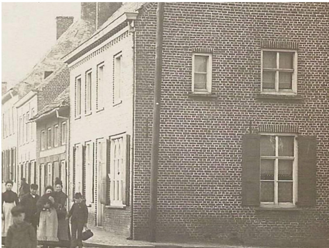
Figuur 104: Proven begin 20 ste eeuw. Ook hier treffen we het type vierkante kozijn met tussencolonettes aan (© Westhoek Verbeeldt, privécollectie, HEU004500586) – Typologisch gelijkaardig voorbeeld uit Proven.
