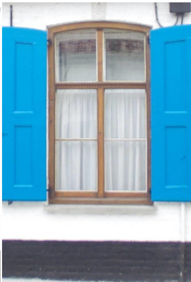
Figuur 85 en 86: Vijfhoekstraat 18 – getande wisseldorpel van blokkoszijnen van deur en vensters.
