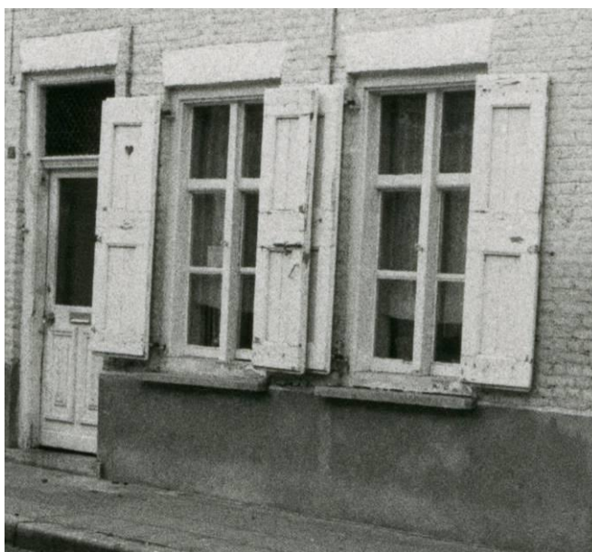
Figuur 88: Vijfhoekstraat 10 in 1981 – afwijkend type met doorlopende middenstijl en ongeprofileerde wisseldorpels (inventarisfoto Onroerend Erfgoed) – verdwenen erfgoedelement .
