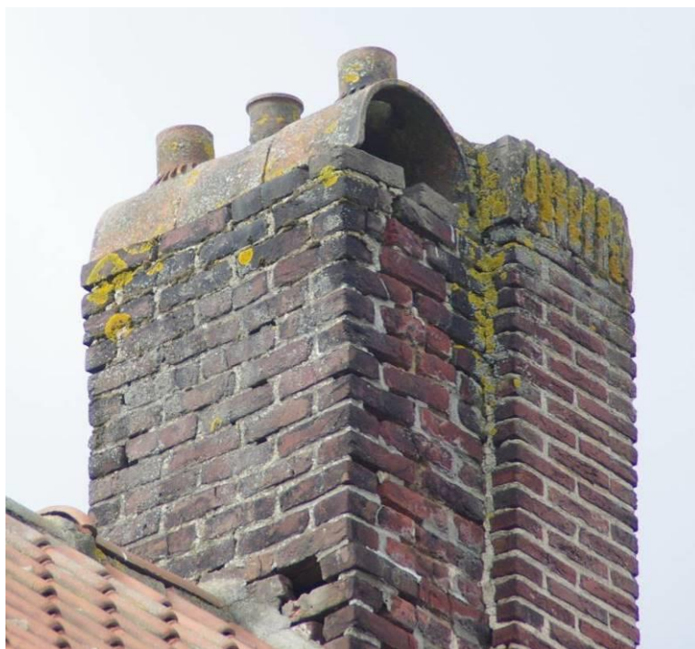
Figuur 173: Poperingse 'schouwveursten' in de Vijfhoekstraat te Watou – de twee buitenste zijn van de laatste productie Ver Elst - Dupont Poperinge, de middelste is een iets ouder type.
