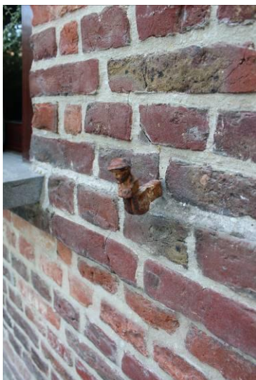
Figuur 149 - 150: Luikvasthouders van het type 'herdertje', links de laat 19 de -eeuwse variant, rechts een recent type (beide Vijfhoekstraat Watou).
