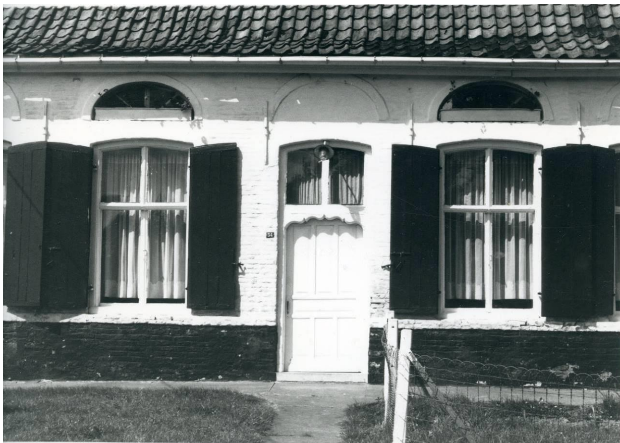
Figuur 84: Steenvoordestraat 34 – voormalige kasteelhoeve. Opname uit 1981 met blokkozijnramen met wisseldorpel en middenstijl met amandelform. De schuifvleugels hier evenwel al verbouwd tot dubbel opendraaiende vleugels, waarbij de vaste middenstijl onderaan werd weggenomen. Bij de vervanging door nieuw schrijnwerk werd de historische vorm van het schrijnwerk niet herkend en in deze vorm gereconstrueerd (foto Inventaris Onroerend Erfgoed).
