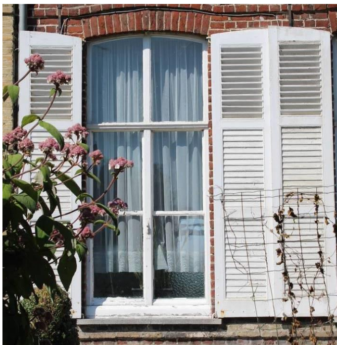
Figuur 133: Kerkhofstraat 1 – pastorie - paneelluiken met persiennes in het bovenste paneelvak – hier opgehangen op ingemetselde duimen.
