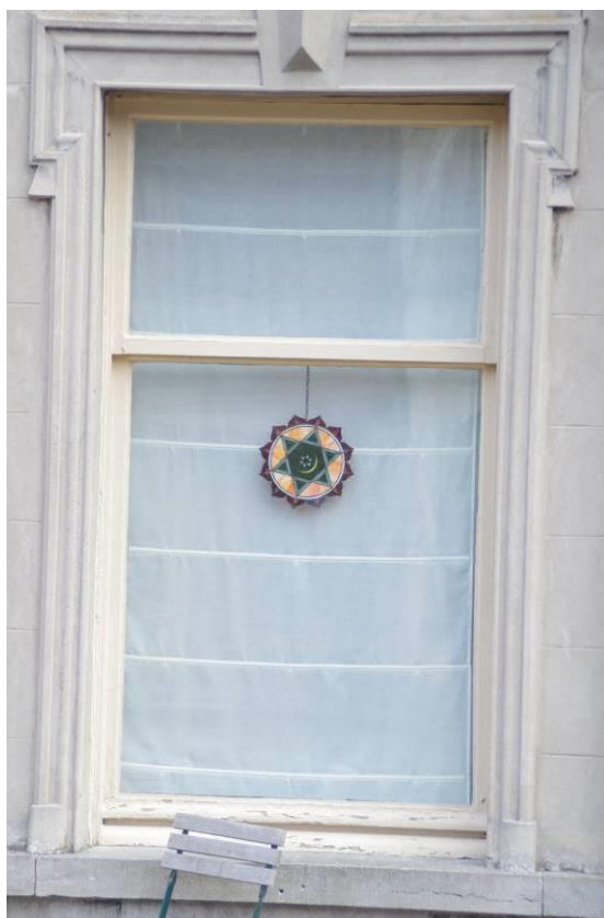
Figuur 125: Kleine Markt 42 – guillotinaam uit de late jaren 1930 of vroege jaren 1940.
