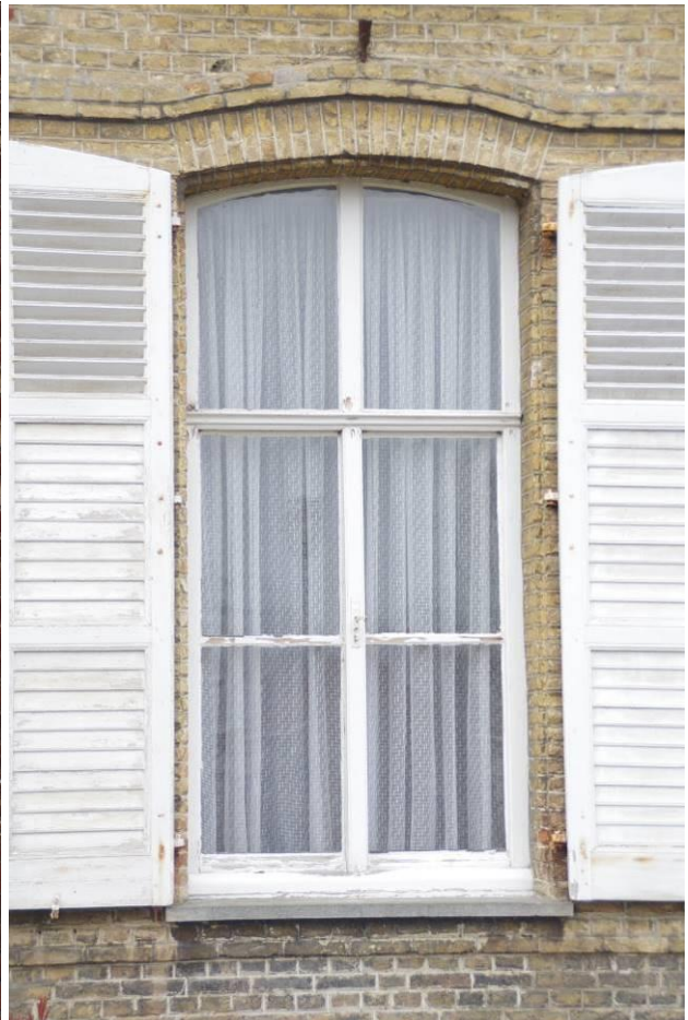
Figuur 145 (links): Vroeg 20 ste -eeuws luijtype in combinatie met schrijnwerk achter slag – luijgehangten op speun / taats (Kleine Markt 7).
