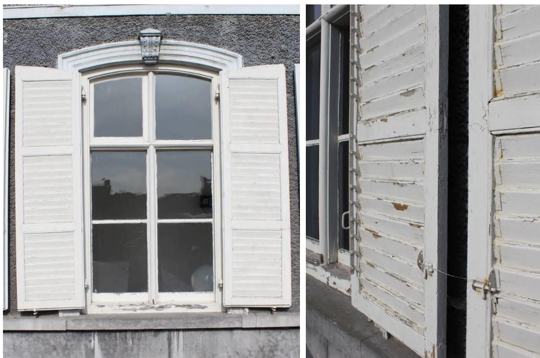
Figuur 134 en 135: Watouplein 12 – luiken paneeltype met dichte persiennes. Detail rechts: openklapbare persiennes in de onderste twee panelen.
