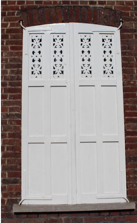
Figuur 145 (links): Vroeg 20 ste -eeuws luijtype in combinatie met schrijnwerk achter slag – luijgehangten op speun / taats (Kleine Markt 7).
