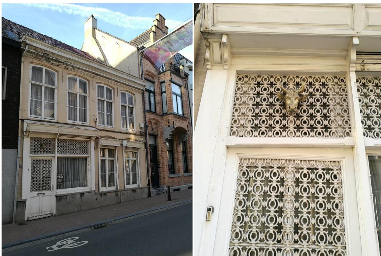
Figuur 117 - 118: Variant type pui en invulling met gietijzeren rooster Guido Gezellestraat 14 te Poperinge (opname maart 2019) 84 – gelijkaardig typologisch voorbeeld uit Poperinge.
