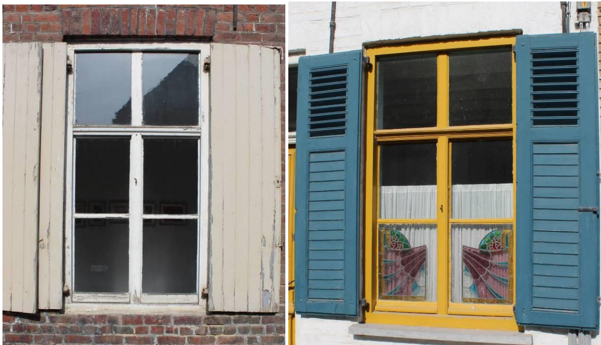
Figuur 92 (links): Vijfhoekstraat 2 – blokkozijn omstreeks 1918 geplaatst (secundair herplaatst?).
