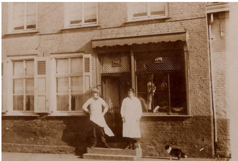
Figuur 116: Deze aangeklede gekoppelde deur en winkelpui in de Moenaardestraat 4 betreft een vroeg 20 ste -eeuwse aankleding van een kozijnpuui, inclusief rolluikbak. Typisch zijn de gietijzeren rooster met gietijzeren rund en varken in profiel - foto 1922 (© Westhoek Verbeeldt, privécollectie, HEU004508552) – deels verdwenen erfgoedelementen (i.c. grillies).
