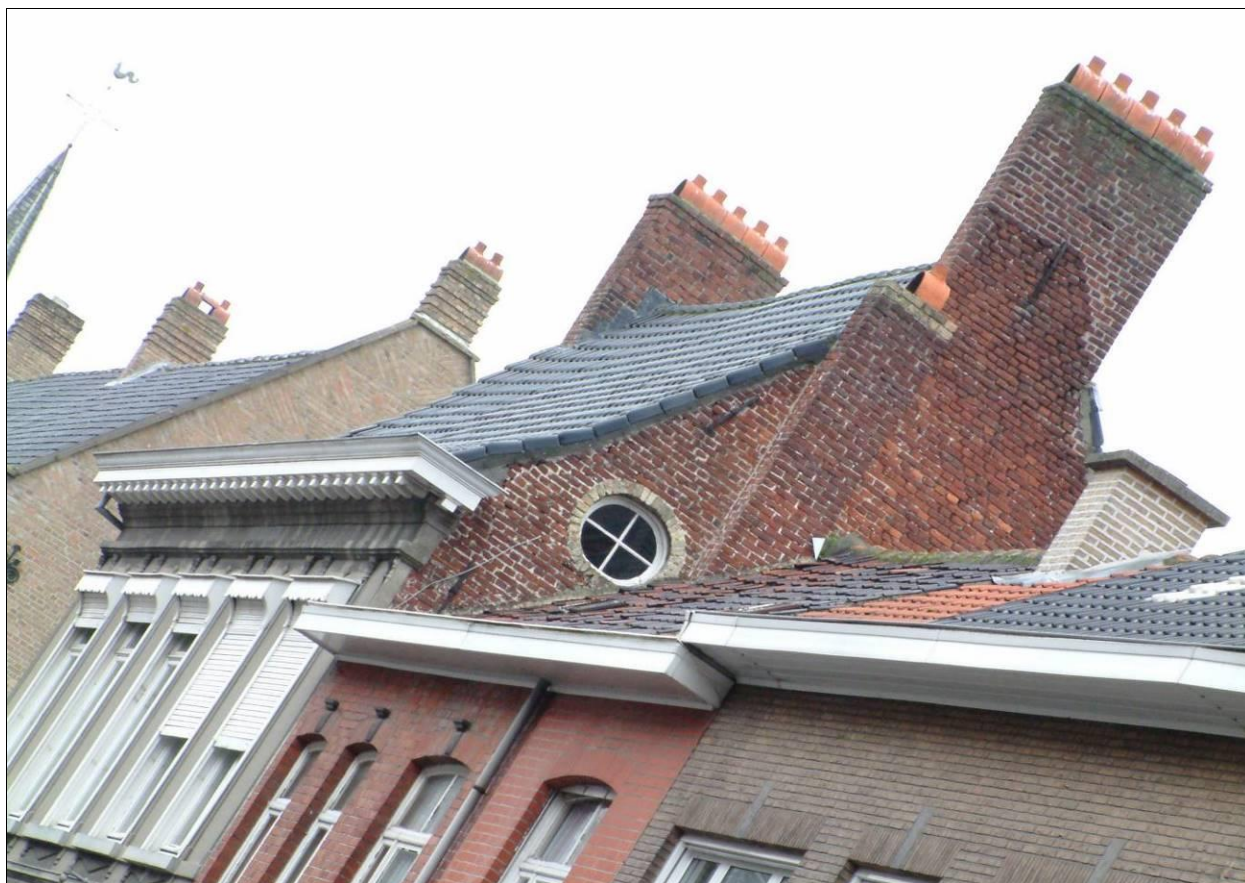
Figuur 174: 'Skyline' van de Boeschepestraat te Poperinge – opname in 2005 – Typevoorbeeld typologie schouwveusten in Poperinge.
