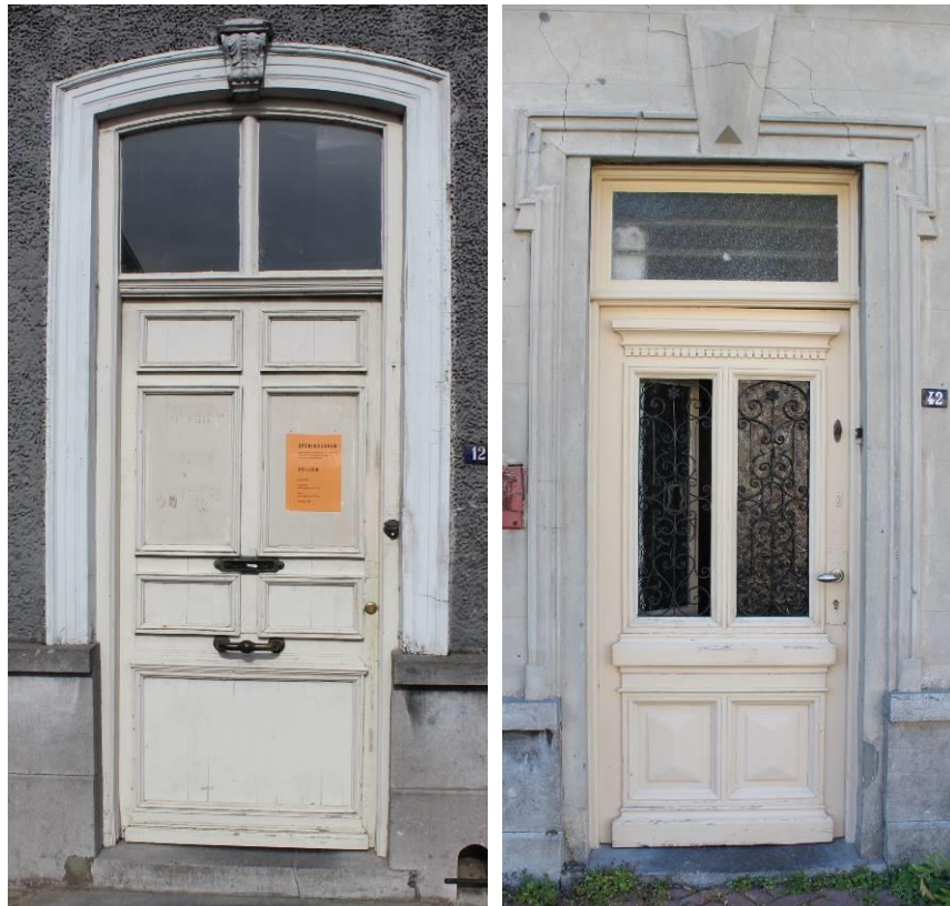
Figuur 97 en 98: 19 de -eeuwse paneeldeuren in kozijn met geprofileerde wisseldorpel - Watouplein 12 (links) en Kleine Markt 42 (rechts).
