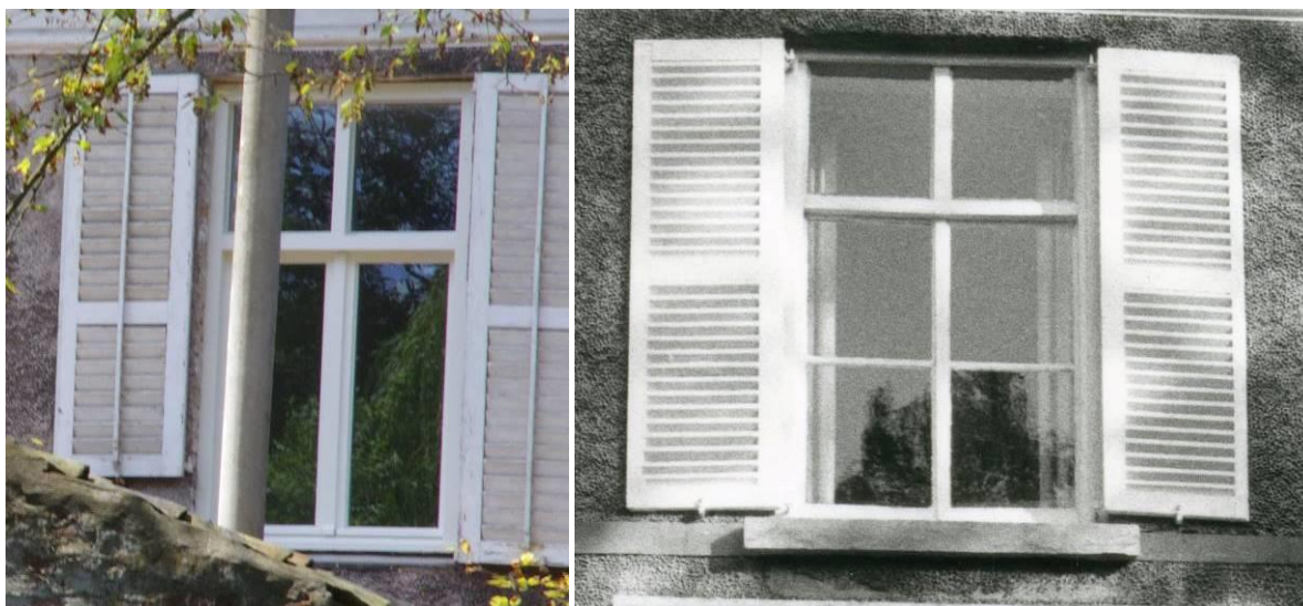
Figuur 136: Kasteelstraat 1 – luiken van het type volledige persienne (links met systeem bediening open en buiten – rechts foto voorgevel opname 1981 inventariscampagne Onroerend Erfgoed).
