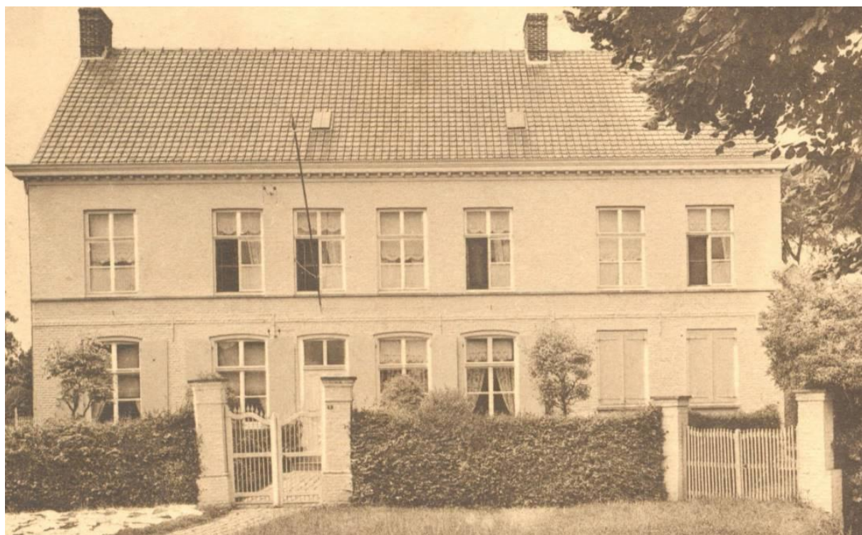
Figuur 81: Zuidelijke gevelrij van Watouplein, voor WOI – types blokkozijnen van het rechte en getoogde type (© Westhoek Verbeeldt, privécollectie, HEU004501311) – verdwenen erfgoedelementen .
