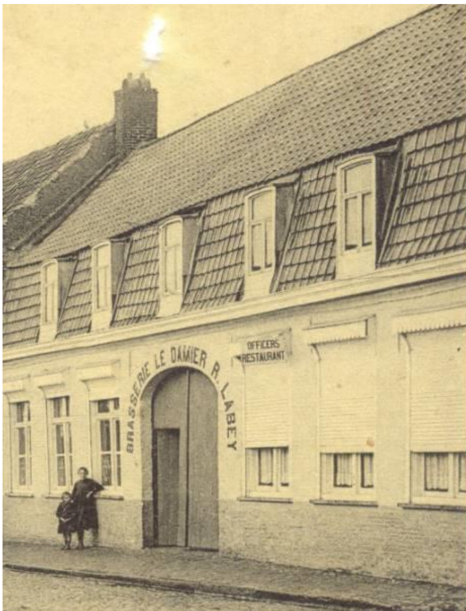
Figuur 55: Moenaardestraat 2, zogenaamd Douvieuhs tijdens WO I – nieuw geplaatste vroeg 20 ste -eeuwse dakkapellen. De dakkapellen zouden opnieuw worden vervangen begin jaren 1930 in een restyling in 18 de -eeuwse trant (Westhoek Verbeeldt, privécollectie, HEU004502233).
