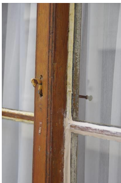
Figuur 156 : klassieke luiksluiter met duwsysteem zelfsluitend vanaf de buitenzijde (Vijfhoekstraat)
