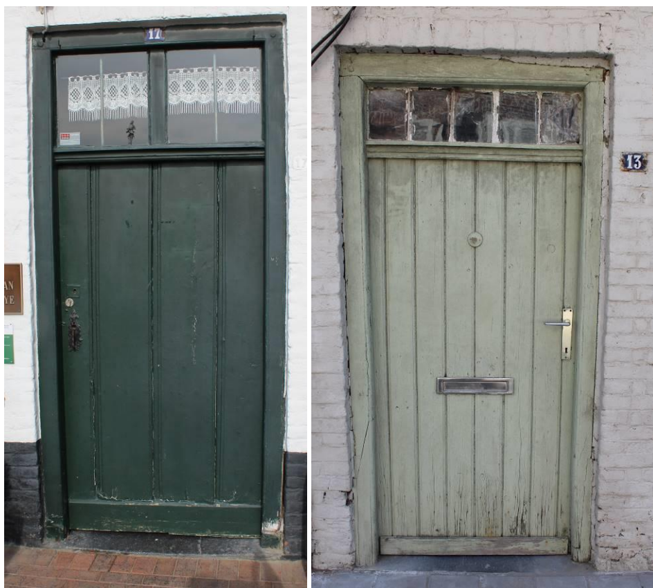
Figuur 95 en 96: Opgeklampte plankendeur in kozijn met geprofileerde wisseldorpel - Watouplein 17 (links) en Vijfhoekstraat 13 (rechts).
