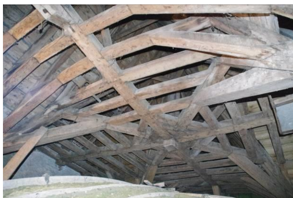
Figuur 58 (links): Spanttype met gewelfnokribbe als hanenbalkflieering en ondernokbalken tussen makelaars; andreaskruisen tussen hanenbalkflieering en ondernokbalk – Sint-Bavokerk te Watou – noordtransept.
