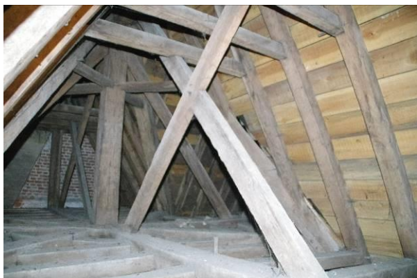
Figuur 58 (links): Spanttype met gewelfnokribbe als hanenbalkflieering en ondernokbalken tussen makelaars; andreaskruisen tussen hanenbalkflieering en ondernokbalk – Sint-Bavokerk te Watou – noordtransept.
