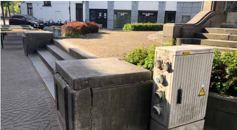
Afbeelding 16. De zijpanelen van de penanten zijn weggedrukt. (© Erfgoed en Visie)
