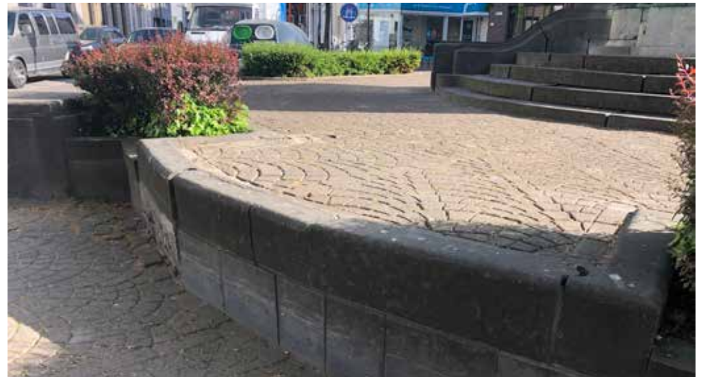
Afbeelding 17. De dekstenen van het platform worden plaatselijk weggedrukt. Onderaan zijn recentere afdekplaten geplaatst. (© Erfgoed en Visie)
