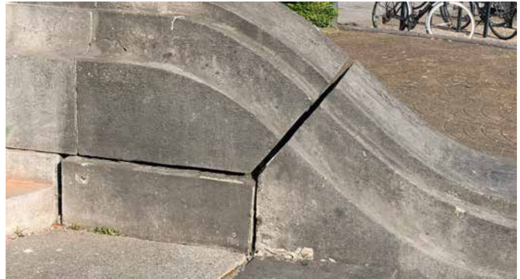
Afbeelding 21. De onderste blok is verschoven tov de rest van de penant. (© Erfgoed en Visie)
