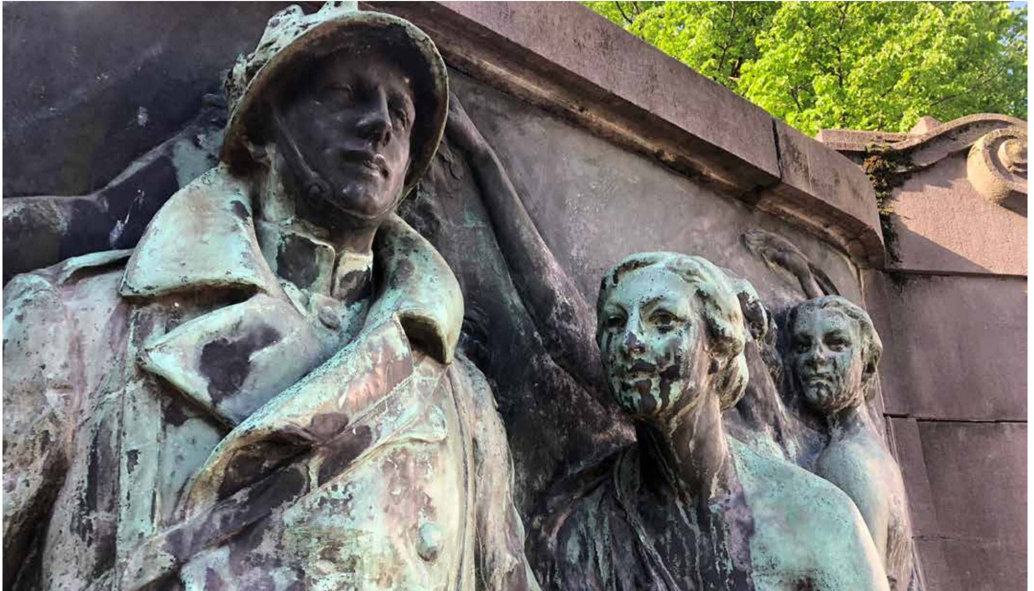
Afbeelding 23. Detail bronzen reliëf. Er is een duidelijk verschil in vervuiling merkbaar bij de beschermde en niet-beschermde delen. (© Erfgoed en Visie)
