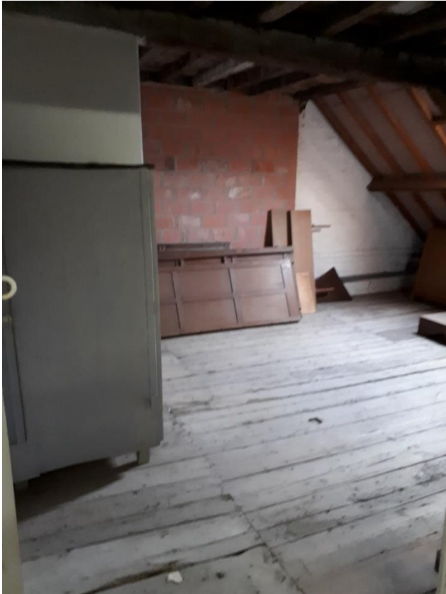
Foto A.20. Beperkt afgewerkte ruimte op het 2de verdiep
