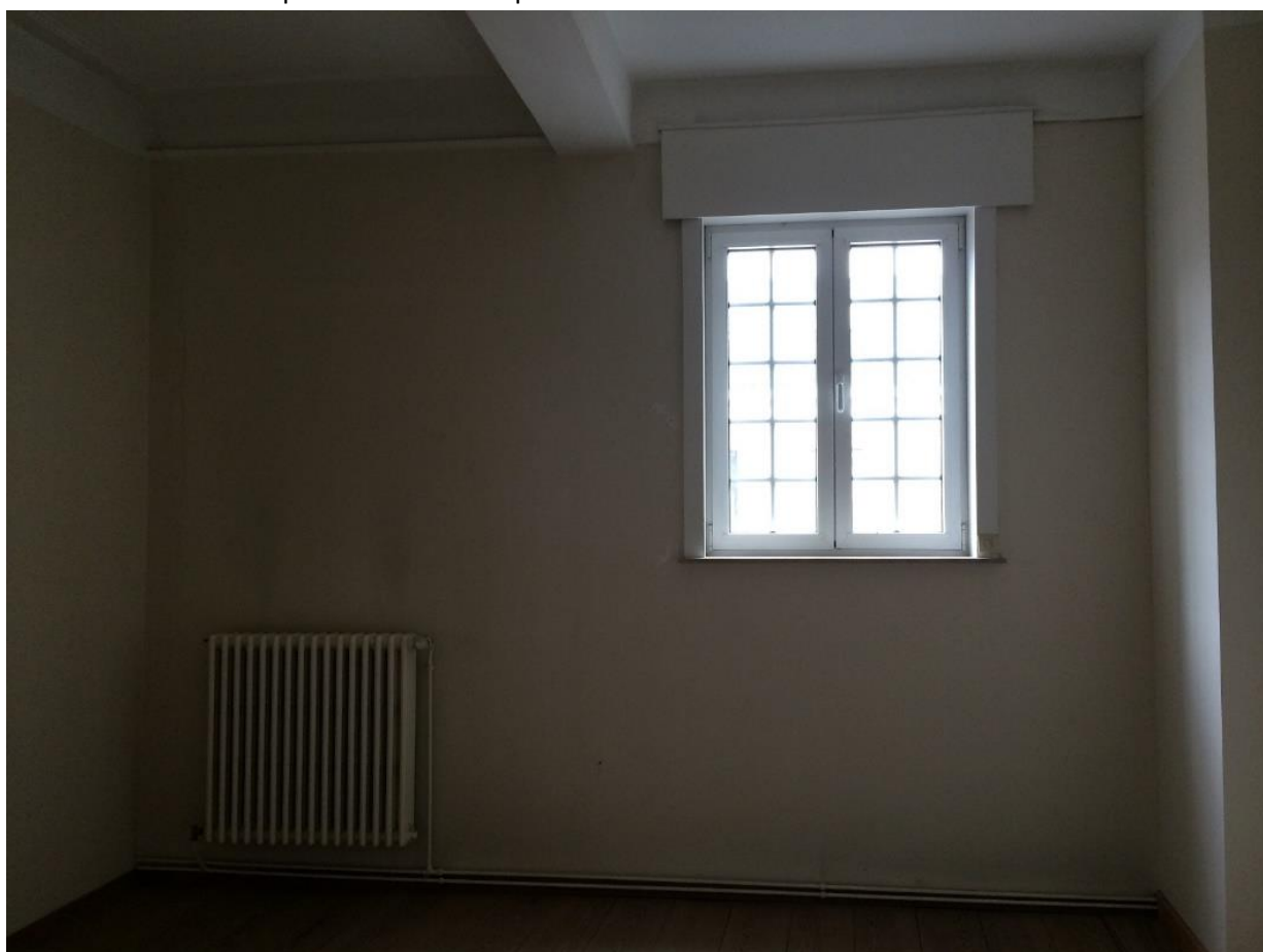
Foto A.96. PVC raam op het eerste verdiep
