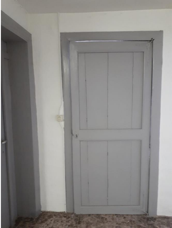
Foto A.77. Deur op tweede verdiep met erfgoedwaarde
