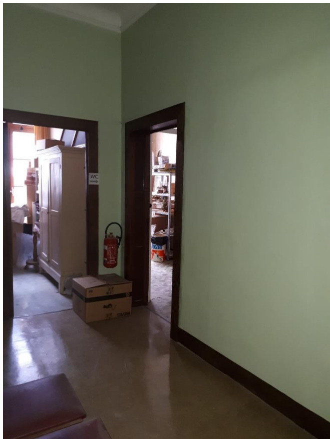
Foto A.26. Lineoleum op 1ste verdieping
