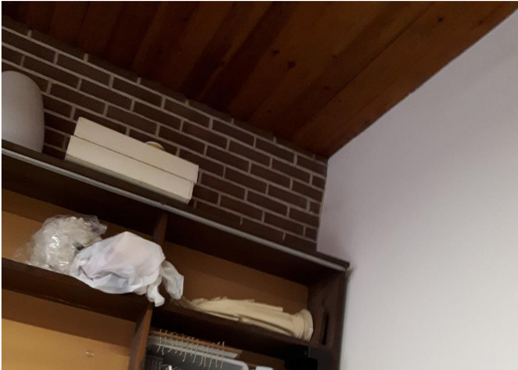
Foto A.10. Afwerking van muur bepleistering (bovenaan) en asbestplaten (onderaan)
