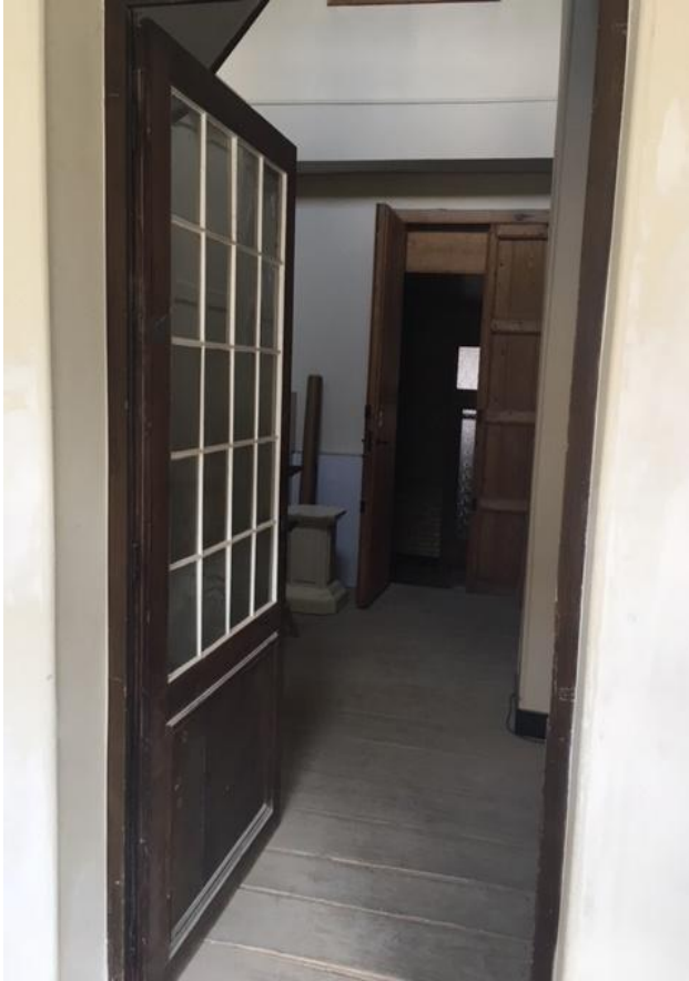
Foto A.68. WC-Deur met asbestplaat.
