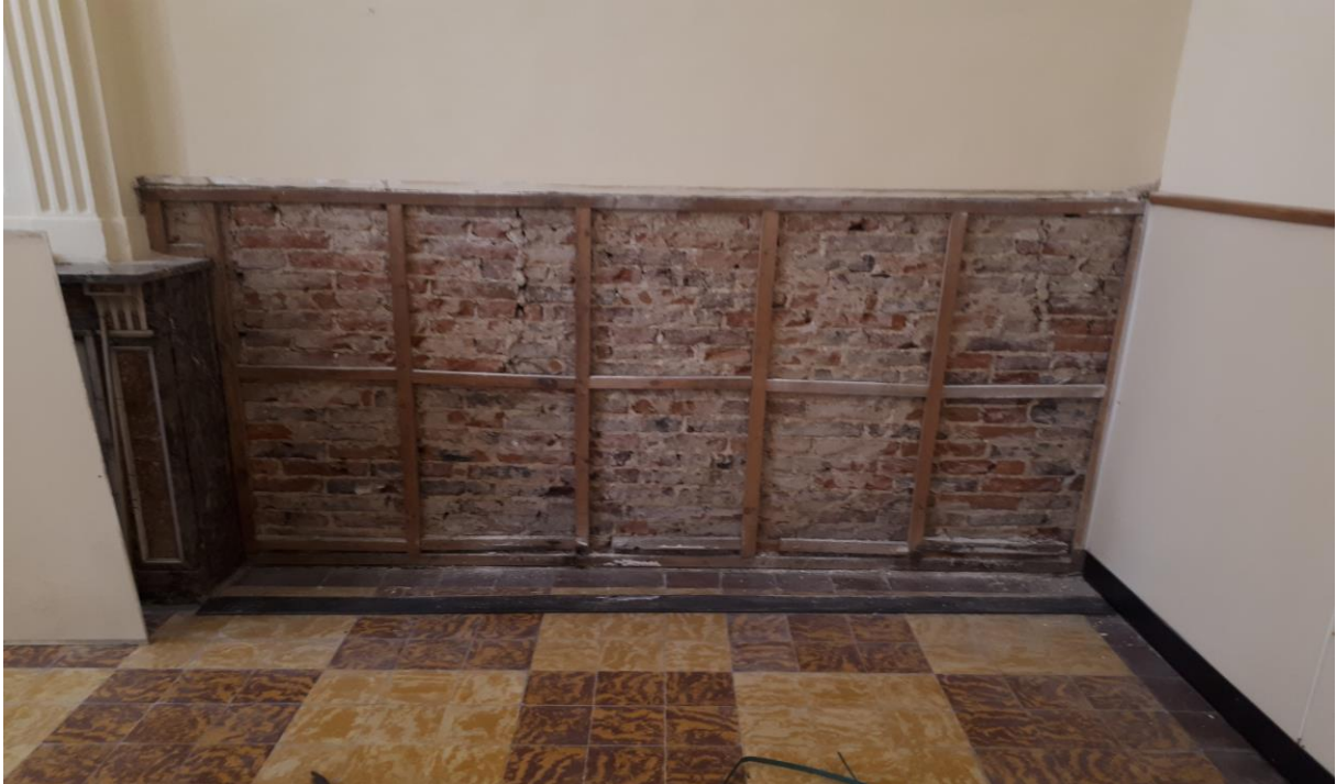
Foto A.11. Ondersteunende structuur voor afwerking van muur
