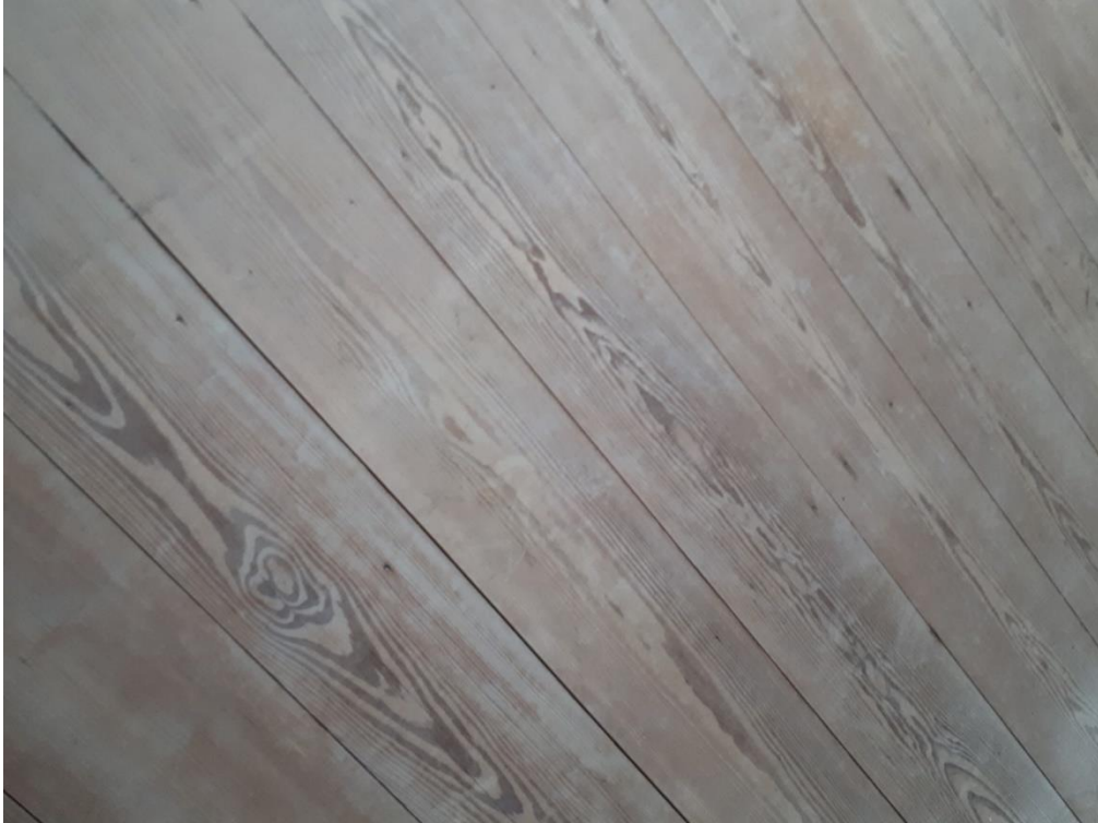
Foto A.25. Plankenvloer op 1ste verdieping in goede en in minder goede staat
