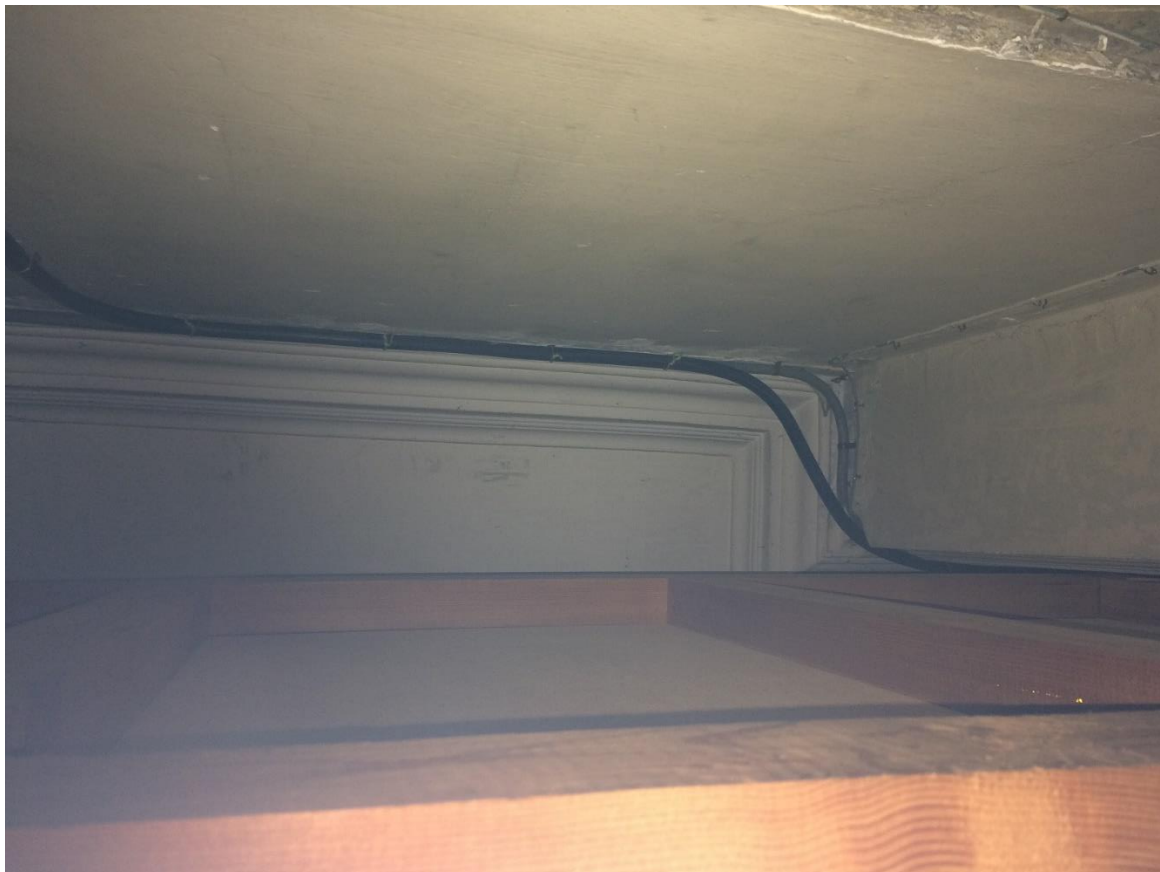
Foto A.38. Stuk plafond zichtbaar achter inbouwkast in kamer rechts van de inkom op gelijkvloers
