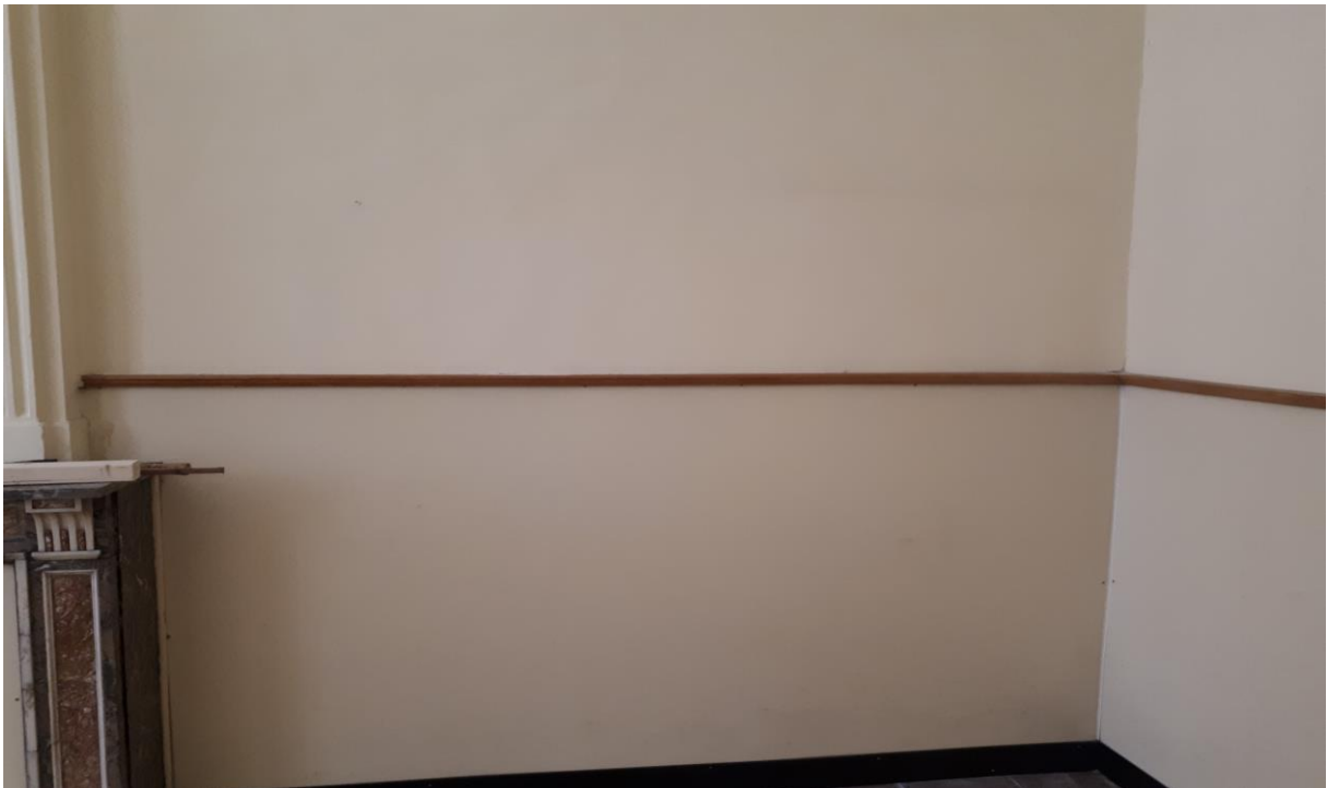
Foto A.10. Afwerking van muur bepleistering (bovenaan) en asbestplaten (onderaan)
