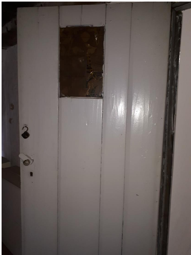
Foto A.79. Deur op tweede verdiep met erfgoedwaarde
