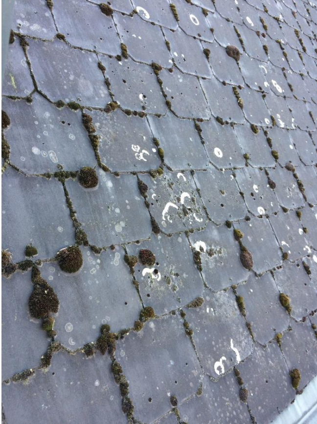
Foto A.99. Dakbedekking in kunstleien (asbest)
