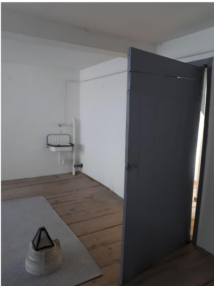
Foto A.78. Deur op tweede verdiep met erfgoedwaarde
