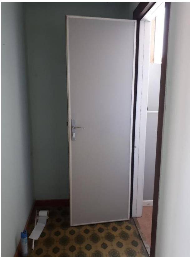
Foto A.68. WC-Deur met asbestplaat.
