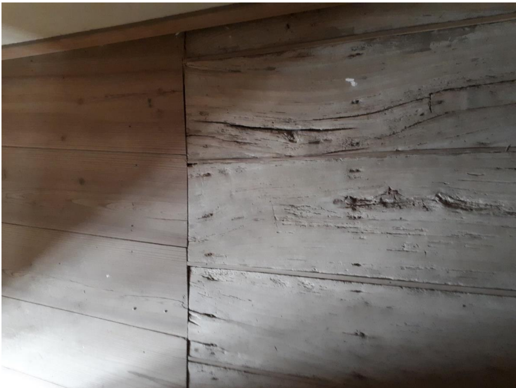
Foto A.25. Plankenvloer op 1ste verdieping in goede en in minder goede staat
