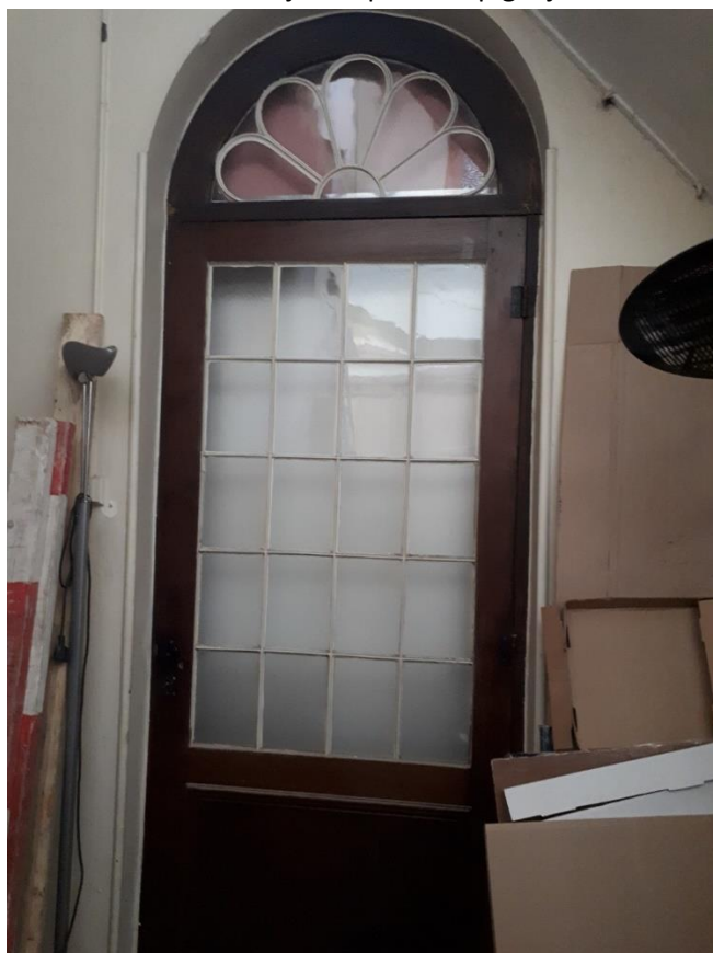
Foto A.66. Deur met ijzerenprofiel op gelijkvloers
