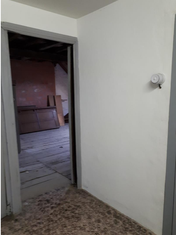
Foto A.32. Plankenvloer op 2de verdieping met en zonder versiering
