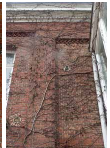
afb. 128: Detail spaarvelden en tandlijsten.
