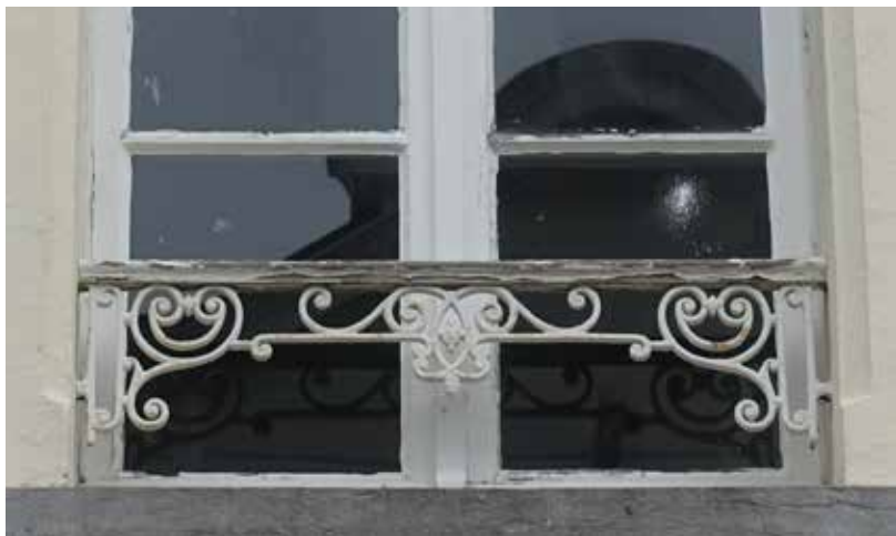
afb. 87: Detail borstwering op verdiep hoekvleugel uit eerste bouwphase van Taeymans (1974).
