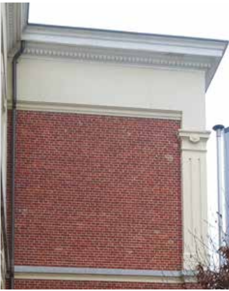
afb. 301: Kroonlijst met regenpijp, zuidelijke zijvleugel.
