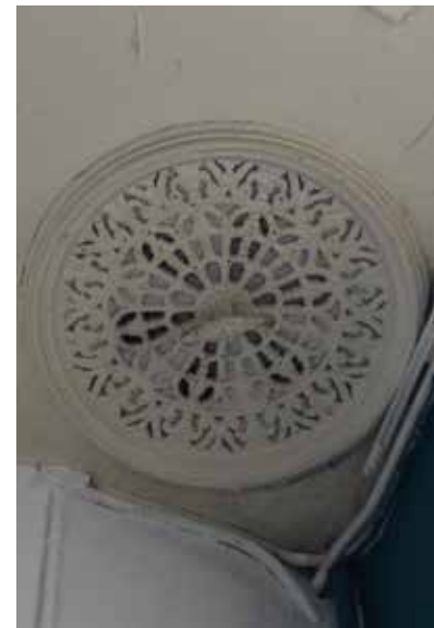
afb. 176: Gietijzeren verluchttingsrooster.
