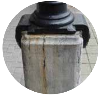
afb. 280: Kolom aan de gaanderij, achtergevel.
