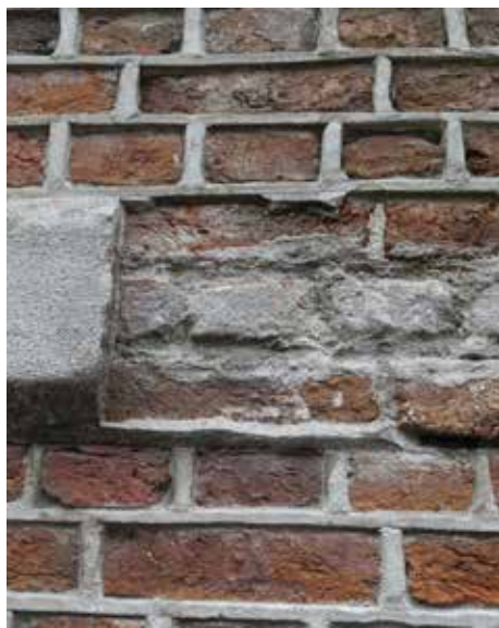
afb. 286: Detail beschadiging aan de simililagen in blauwe hardsteen aan poort-kolom.
