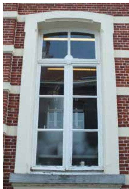
afb. 95: Venster, beneden verdiep
