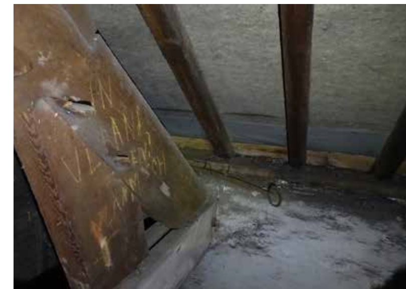
afb. 221: Gebruik van houten pennen bij bevestigen van de spanten.
