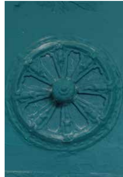
afb. 180: Gietijzeren verluchttingsrooster.
