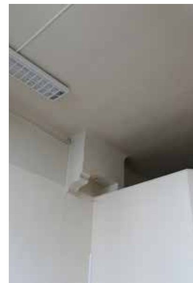
afb. 157: Restanten van de schouw.
