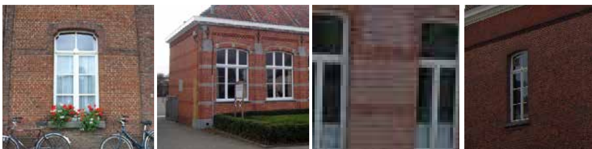
afb. 73: Details gekleurd voegwerk in andere gebouwen van Taeymans (v.l.n.r. Herentals, Westerlo, Ravels, Turnhout)
