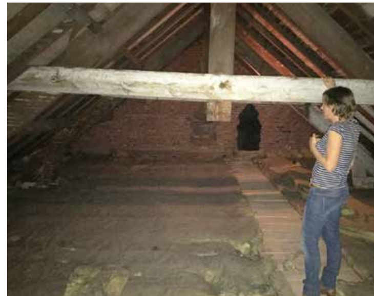
afb. 224: Kagebint, rechtse deel centrale vleugel © HEEM en B architecten.
