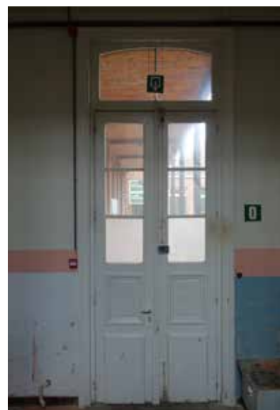
afb. 186: Deur naar binnenkoer.
