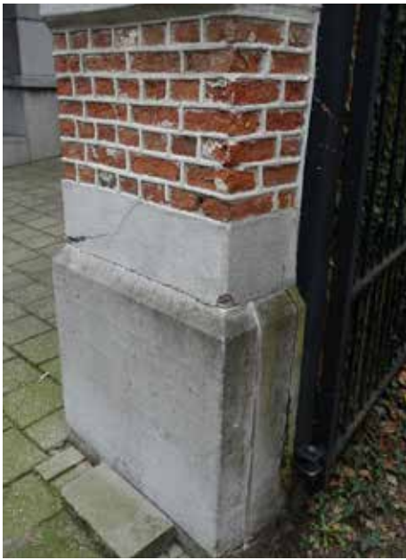
afb. 264: Foto's van enkele (zettings)scheuren aan de voorgevel, plafond van de gaanderij, blauwe hardsteen aan de kolommen van de poorten, die gemonitord moeten worden, situatie februari 2019.
