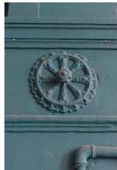
afb. 167: Versierd verluchttingsrooster.
