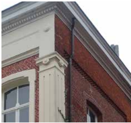
afb. 303: Kroonlijst met regenpijp, zuidelijke zijvleugel.
