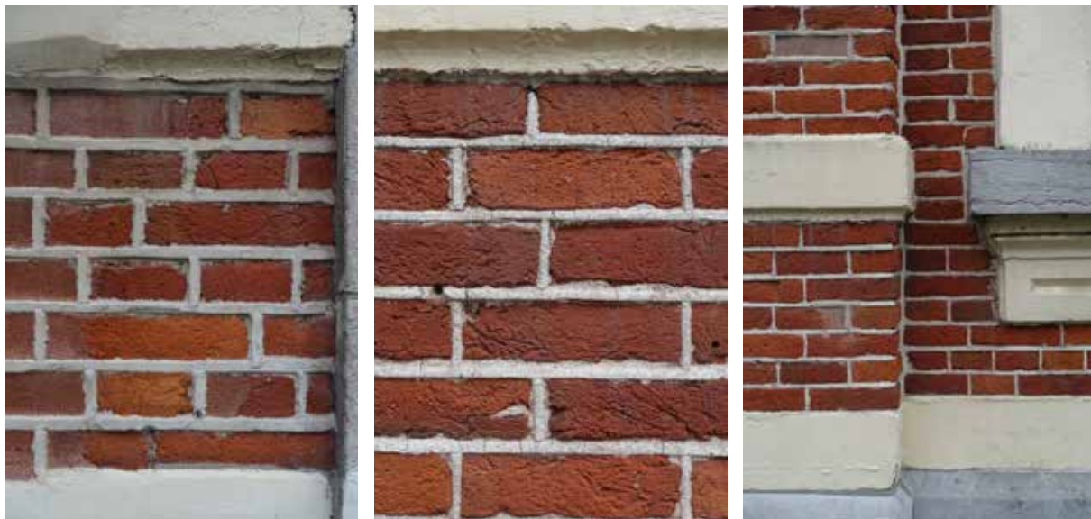
afb. 91: Detail metselwerk: knipvoegen.
