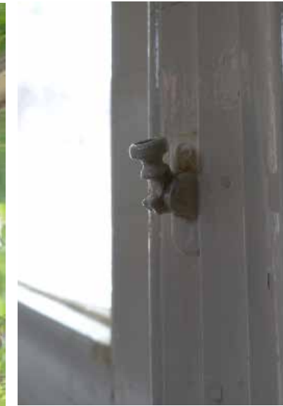
afb. 183: raambeslag voor zonwering.
