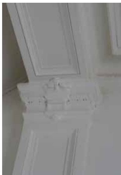
afb. 185: Detail kapiteel trappenhal
