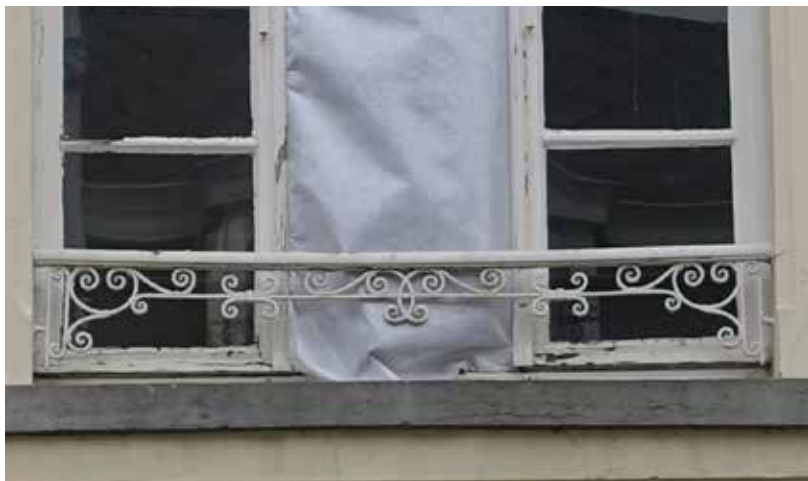
afb. 89: Detail borstwering op verdiep centrale vleugel, boven inkomdeur, uit bouwphase Ravestyn (1928).
