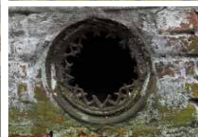
afb. 139: Detail verluchtingsroosters.
