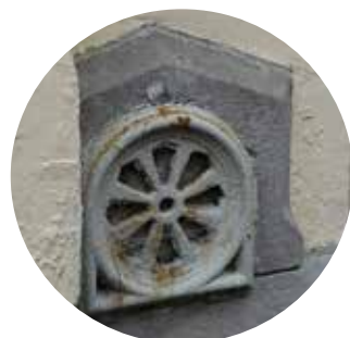
afb. 289: Verluuchtingsrooster met roest.
