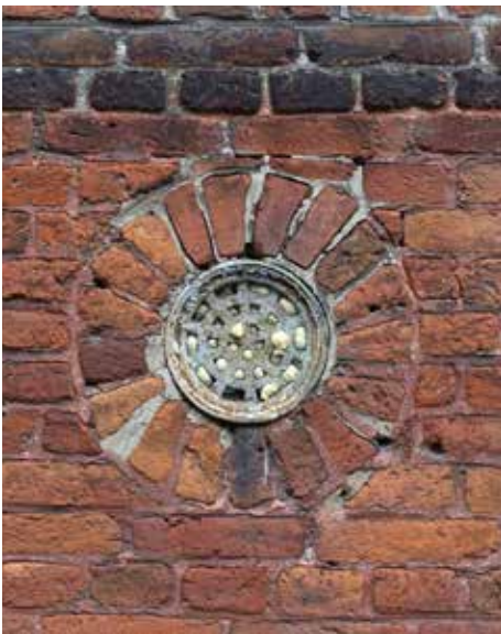
afb. 266: Verschil tussen het ongekleurde en het rood gekleurde voegwerk, erg beeldbepalend voor de gevel.
