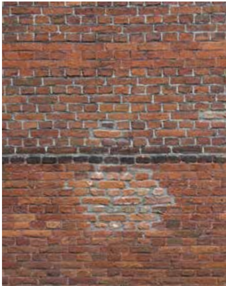
afb. 265: Foto's van beschadigingen en verstoringen aan het metselwerk aan zuidelijke zijgevel.
