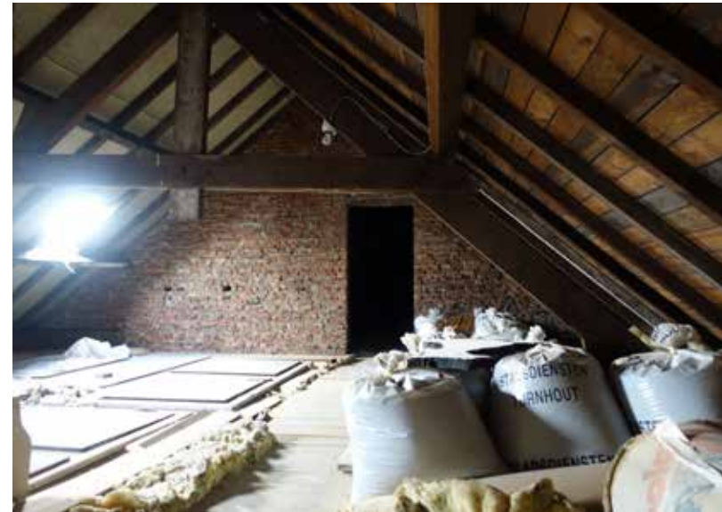
afb. 223: Kagebint, linkse deel centrale vleugel.
