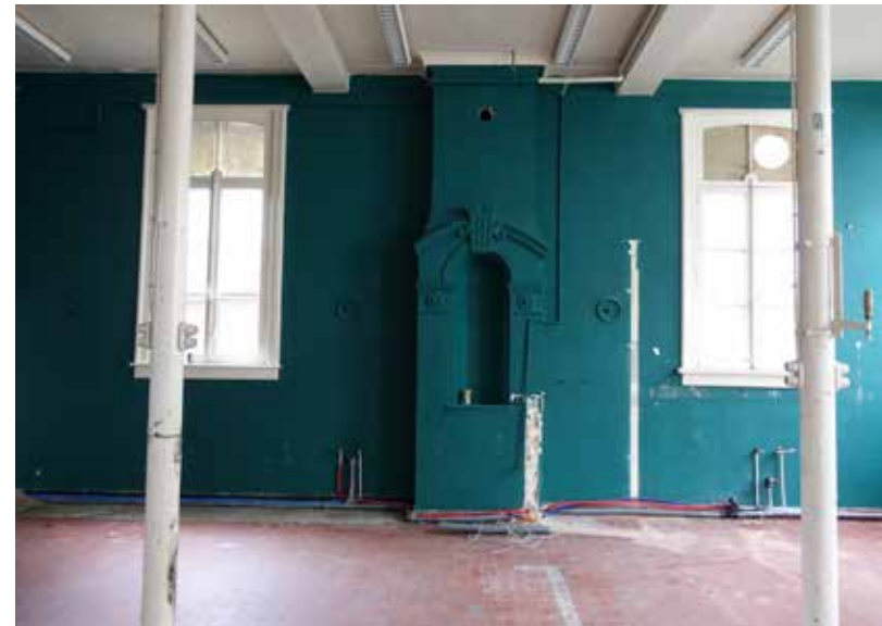
afb. 168: Zicht naar zuidelijke muur met schouw.
