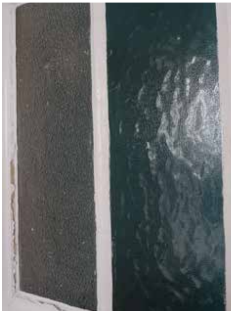
afb. 257: Binnendeur (klas 0.4): figuurglas (links) en gehamerd glas (rechts)
