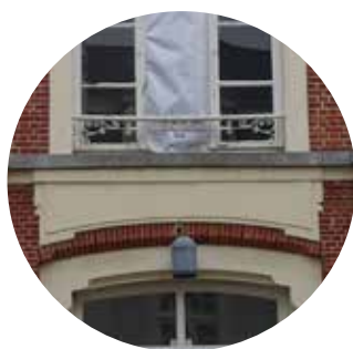
afb. 271: Lege gedenkplaat, voorgevel
