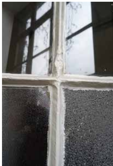
afb. 175: Beglazing binnendeur met ijzeren glasroedes.
