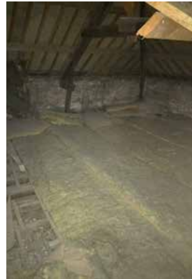
afb. 226: Kagebint, linkse deel centrale vleugel © HEEM en B architecten.
