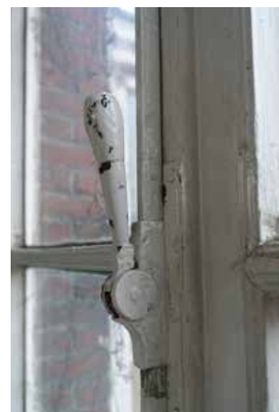
afb. 197: Originele espanjoetsluiting.
