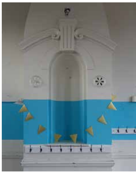
afb. 311: Schouwmantel met dicht geschilderde, maar goed bewaarde verluchtingsroosters. Verflagen kunnen verwijderd worden.
