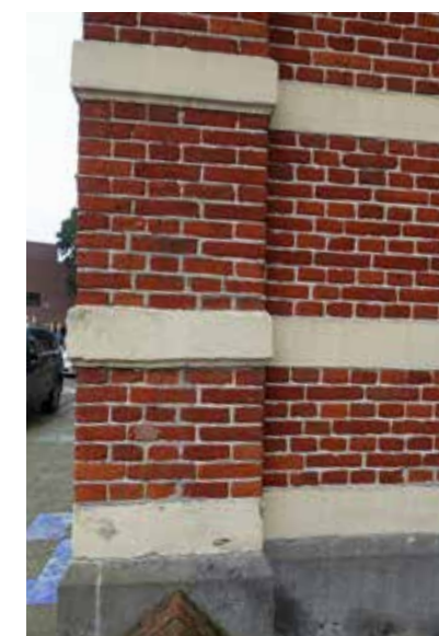
afb. 84: Simililagen met schuine kant afgewerkt aan pilasters.
