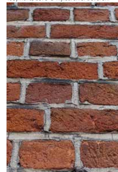
afb. 143: Detail knipvoeg in korte zijde.
