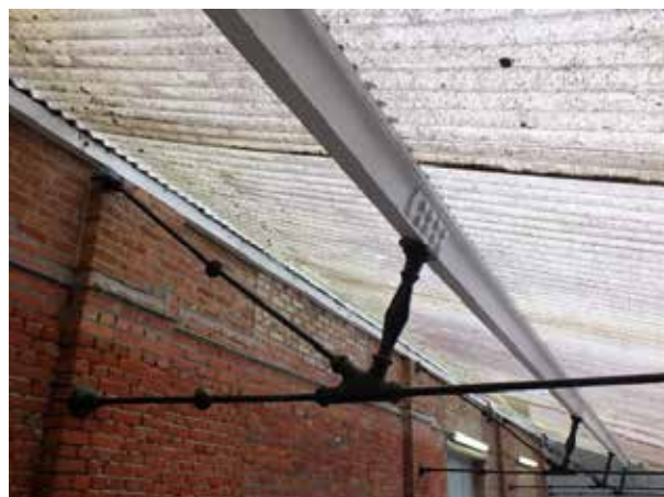
afb. 105: Muziekacademie Herentals, knooppunt van het spant
