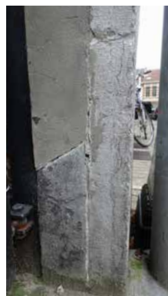
afb. 277: Cementherstellingen in plint van poort-kolom.
