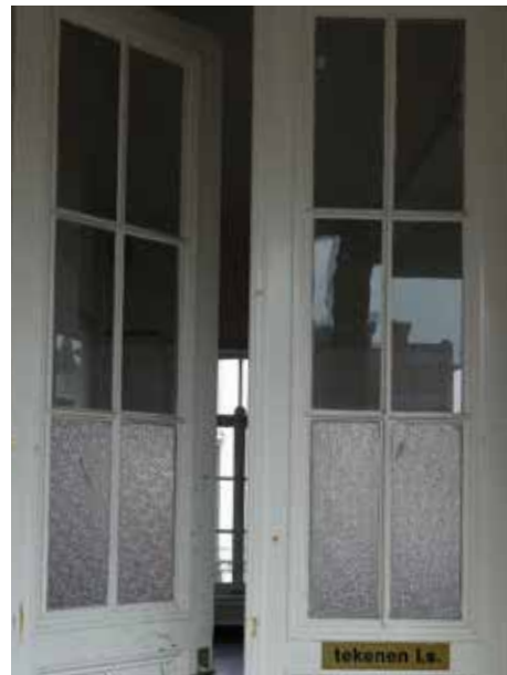
afb. 258: Binnendeur: figuurglas (onderaan) en oud cilinderglas (midden ruiten) (Klas 1.3)
