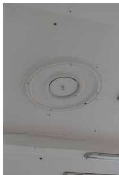
afb. 196: Detail verluchttingsrooster met cirkelvormige handgetrokken stucwerk.
