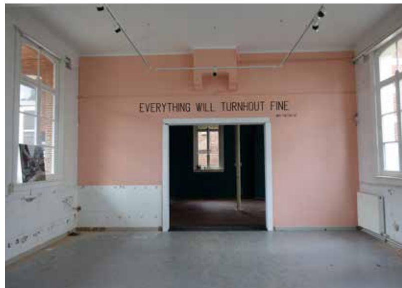
afb. 159: Recente opening met bovenaan schouwelement.
