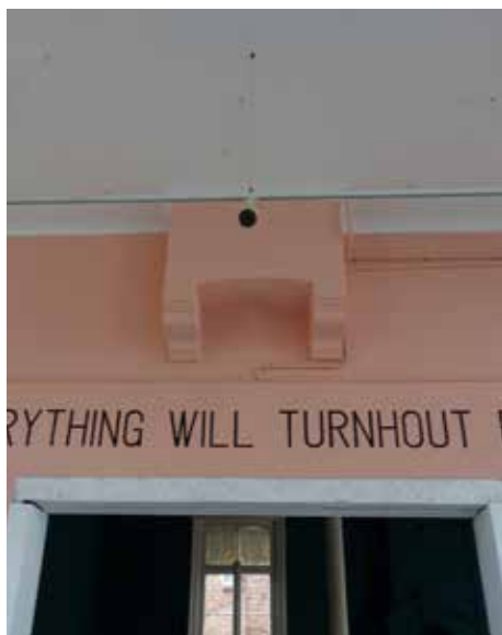
afb. 310: Bouwspoor van schouw.
