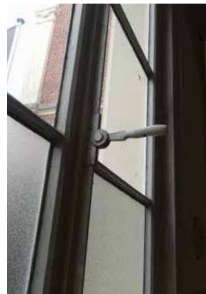
afb. 151: Pompespagolet slot.
