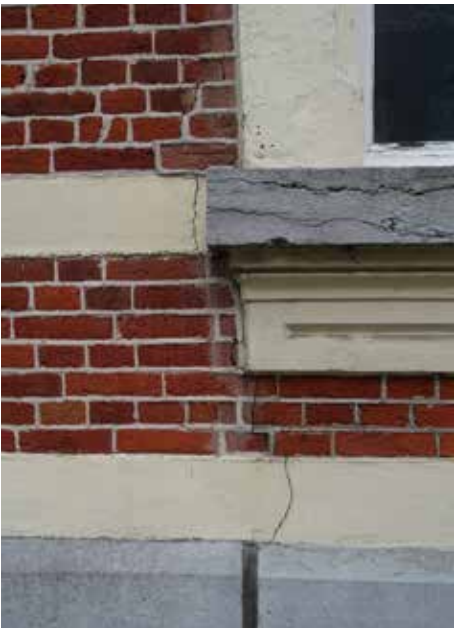
afb. 264: Foto's van enkele (zettings)scheuren aan de voorgevel, plafond van de gaanderij, blauwe hardsteen aan de kolommen van de poorten, die gemonitord moeten worden, situatie februari 2019.
