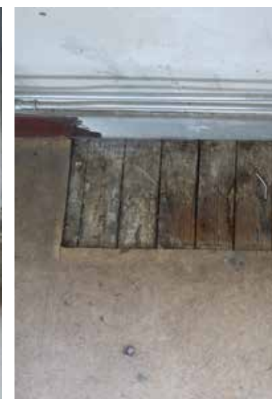
afb. 198: Houten grenen planken vloer onder linoleum / vinyl.
