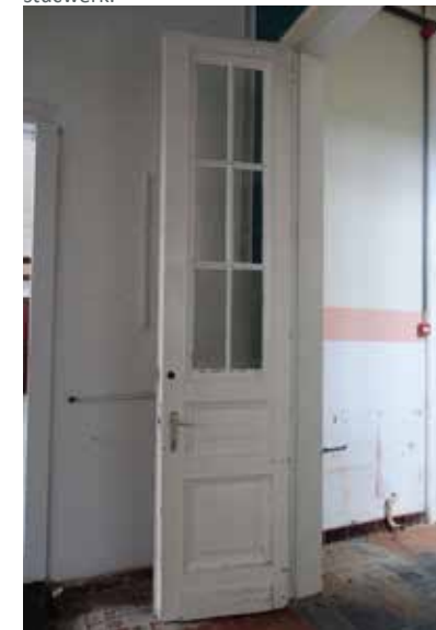
afb. 171: Detail, dubbele deur.
