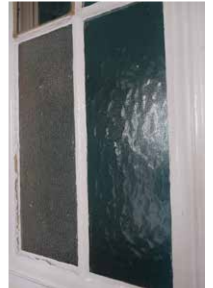
afb. 173: Detail oude beglazing, dubbele deur.
