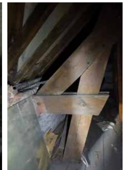
afb. 222: Detail spant: gebruik van bouten.
