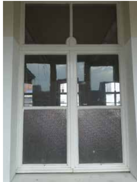
afb. 256: Figuurglas (onderaan) en oud cilinderglas (midden ruiten) (Klas 1.3)
