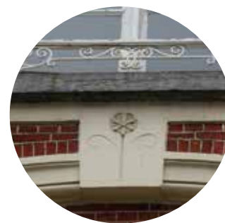
afb. 275: Bepleisterde sluitsteen, voorgevel
