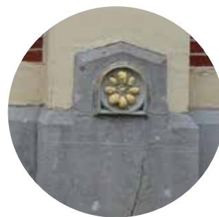
afb. 273: Afgedicht luchtrooster in arduinen plint, voorgevel.
