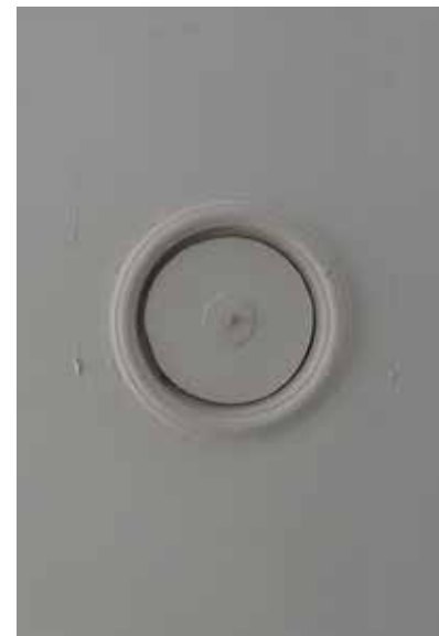
afb. 181: Verluchttingsrooster met cirkelvormige handgetrokken stucwerk.
