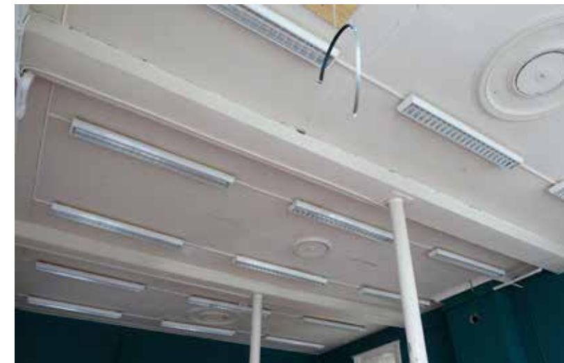
afb. 172: Zicht op verluchttingsroosters, afgewerkt met cirkelvormige handgetrokken stucwerk.
