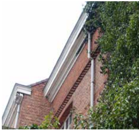
afb. 305: Begroeide kroonlijst met regenpijp, achtergevel, woonhuis.
