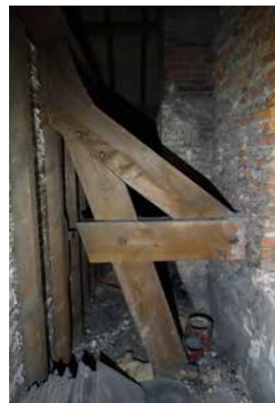
afb. 215: Detail spant: gebruik van bouten.
