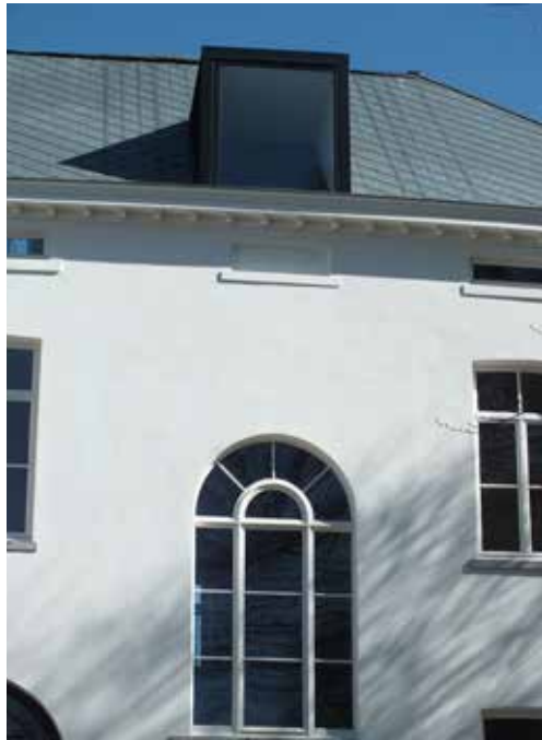
afb. 299: Voorbeeld van een dakkapel, geplaatst boven de kroonlijst. Diest, Schaffensestraat, herenhuis, achtergevel.
