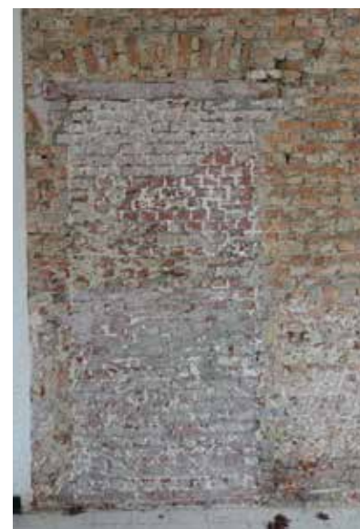
afb. 230: Dichtgemetselde muur in de vestiaire, uitbreiding noordvleugel (1928).
