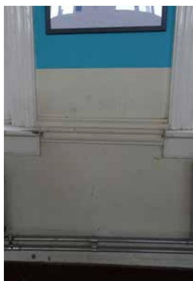
afb. 195: Detail originele stootlijst.
