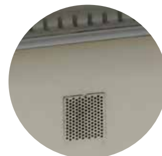
afb. 293: Verluuchtingsrooster in fries aan voorgevel.
