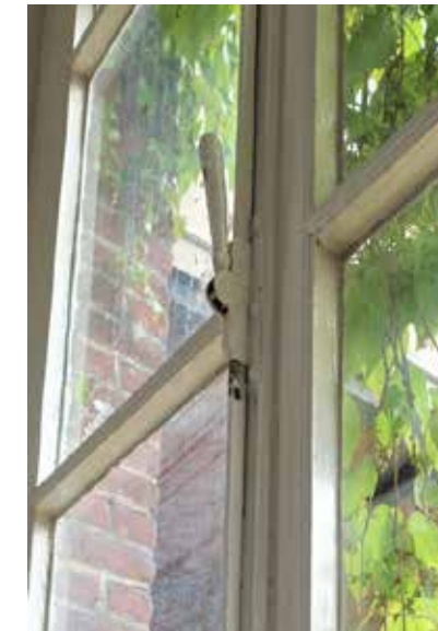
afb. 182: Originele espanjoetsluiting.
