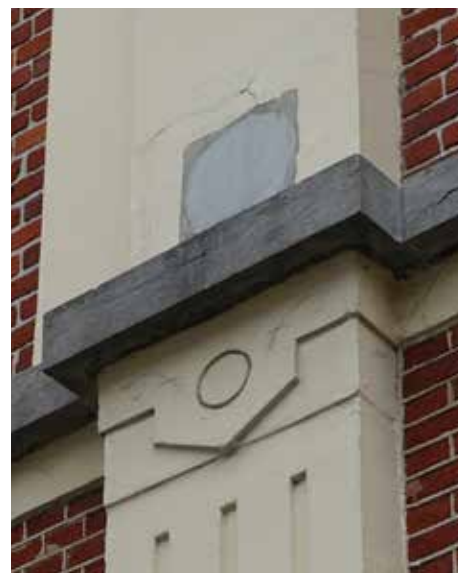
afb. 288: Gedicht luchtrooster.
