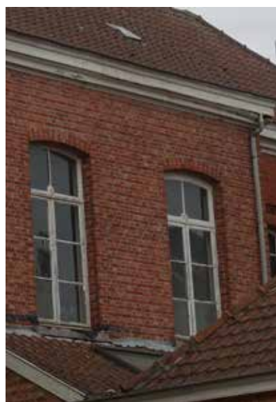
afb. 133: Detail ramen rechts van achtergevel centrale vleugel.
