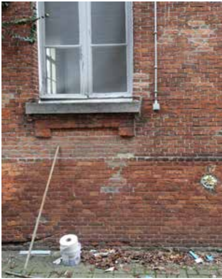
afb. 265: Foto's van beschadigingen en verstoringen aan het metselwerk aan zuidelijke zijgevel.
