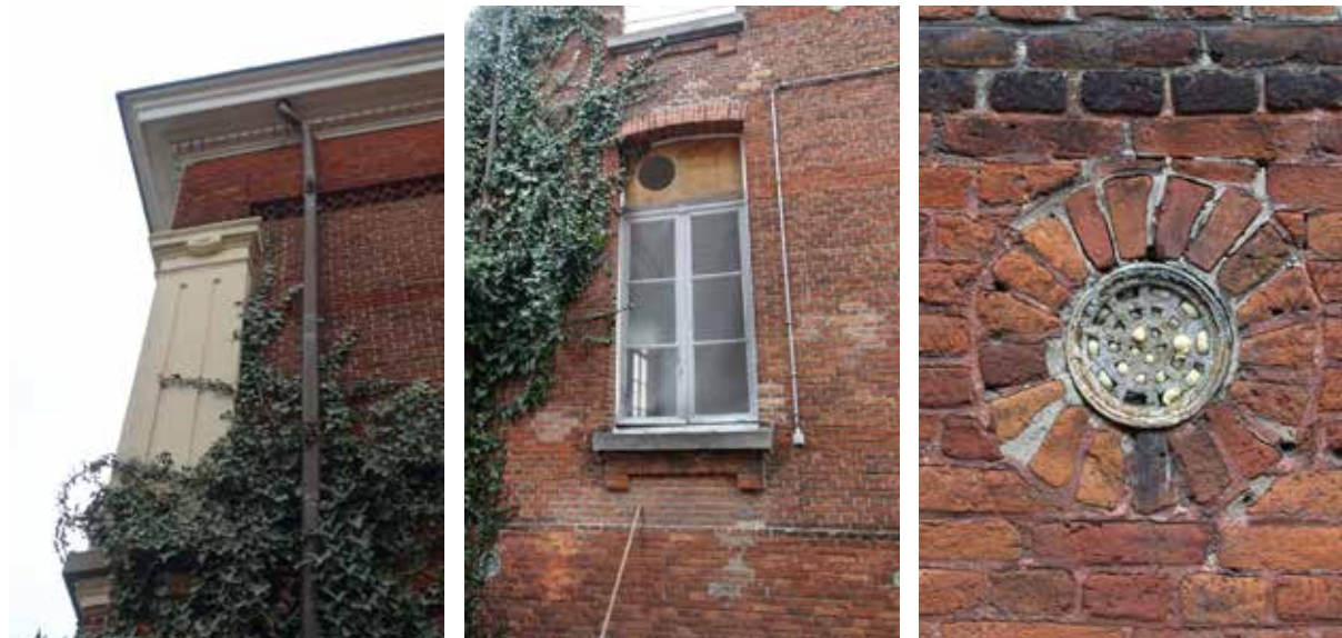
afb. 113: Detail van metselwerk onder de vensterbank.
