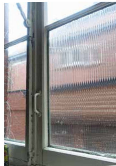
afb. 170: Pompespagnolet slot en mogelijk oorspronkelijk figuurglas uit 19de eeuw.
