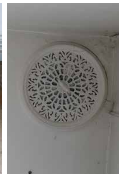
afb. 199: Gietijzeren verluchttingsrooster.
