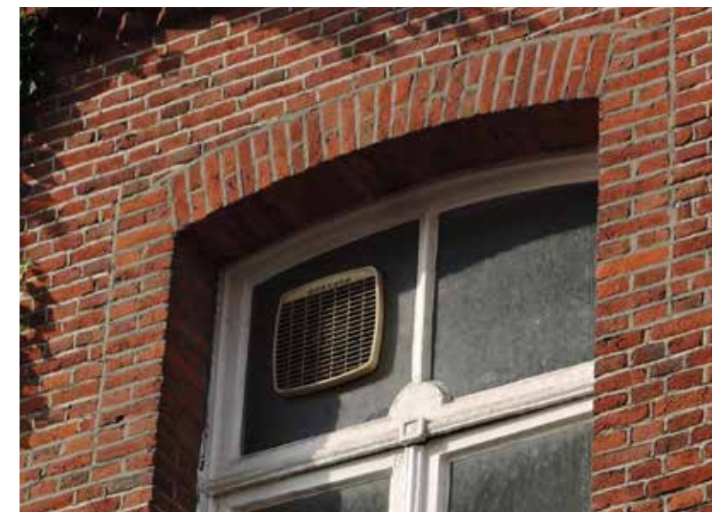
afb. 142: Detail venster met authentiek schrijnwerk en bakstenenomlijsting waarbij de gekleurde rode trasmortel werd vervangen door cementmortel.
