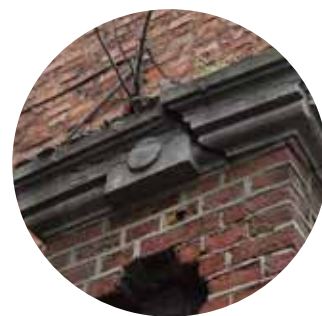
afb. 274: Scheur in arduinen deksteen poort.
