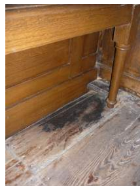
Afbeelding 190: Vochtschade naast biechtstoel aan noordzijde van het schip, tevens insectenschade (eigen foto, maart 2017)
