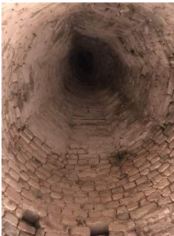
Afbeelding 162: binnenzicht dakbekroning traptoren
