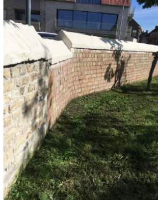
Afbeelding 244 Verschillende bakstenen, afgeschuinde hoek, hoogteverschillen (eigen foto, 2018).
