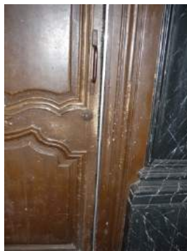
Afbeelding 180: insectenschade en slijtage van de verflaag (eigen foto, maart 2017)
