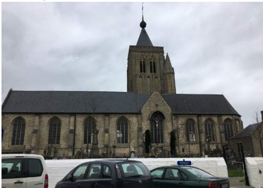
Afbeelding 109: Zicht op zuidgevel (eigen foto, 2017)
