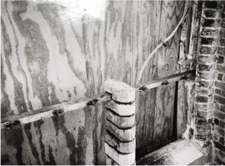
Afbeelding 16: restauratie maaswerk ramen (Archief kerkfabriek, 1977)
