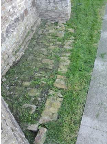
Afbeelding 252 Druiprand (eigen foto, 2018)
