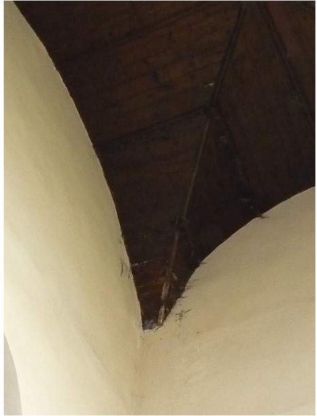
Afbeelding 147: Aangetast tongewelf (eigen foto, maart 2017)
