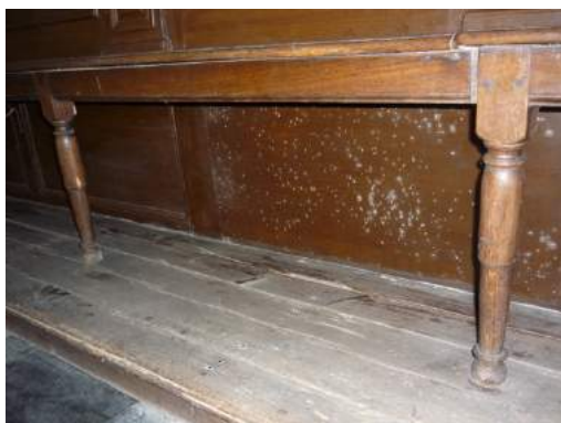
Afbeelding 188: Aantasting insecten op later geplaatste meubelplaat, zuidzijde schip (eigen foto, maart 2017)
