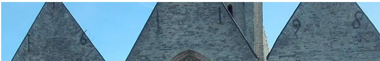
Afbeelding 126 Muurankers westgevel (eigen foto, 2018)
