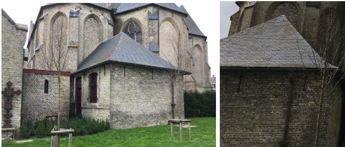
Afbeelding 133: Zicht op oude sacristie zuid-oostgevel en noord-oostgevel (eigen foto, 2017)
