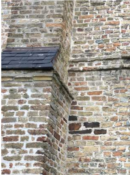
Afbeelding 101 Voorbeeld van gemengd gebruik van verschillende steensoorten.
