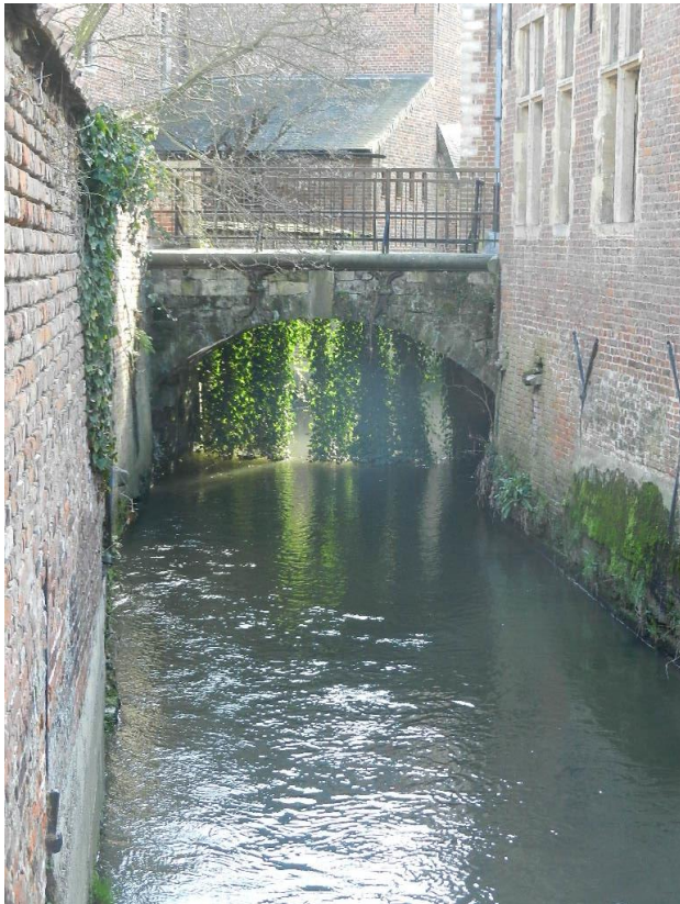
2 – Foto brug over de Kleinde Dijle in de Rechtestraat, Technische Diensten KU Leuven.
