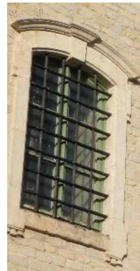
Diefijzers zuidelijke zijgevel, 2018.
