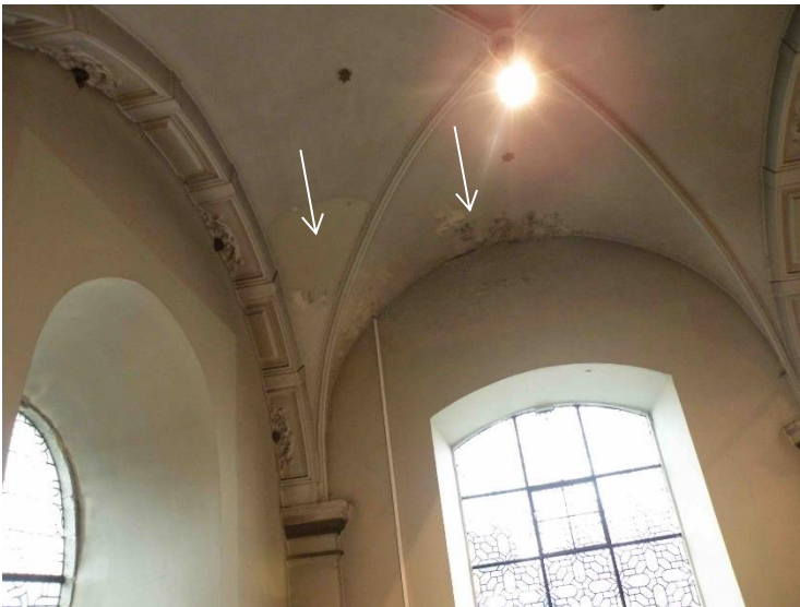
Binnenpleisterwerken en -schilderwerken, westelijke hoek noordbeuk, 2017.
