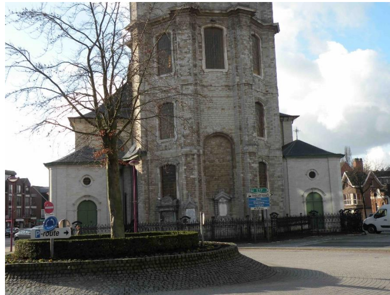
Achtergevel / oostelijke gevel, 2018.
