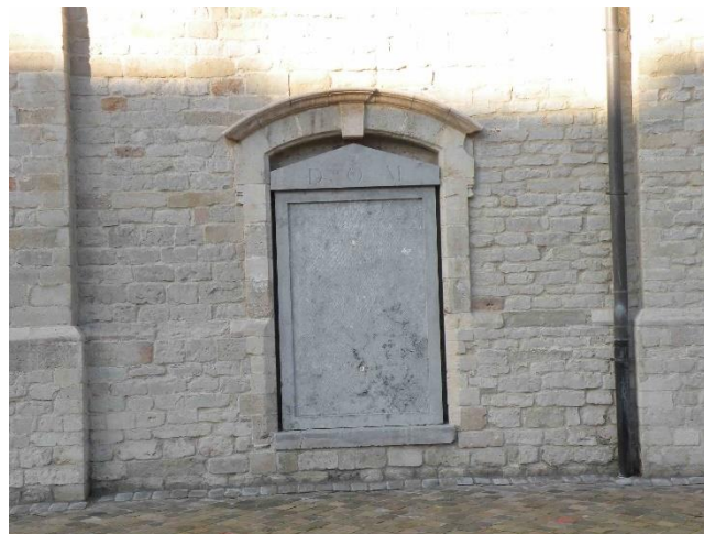
Buitenmetselwerk en blinde deur, zuidelijke zijgevel, 2018.
