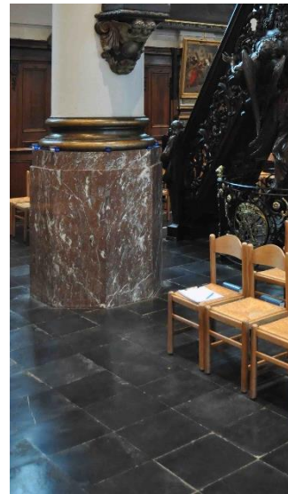
Stenen bekleding, kolom, 2017.
