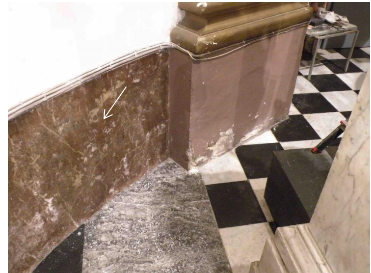
Stenen bekleding, achter hoogaltaar, 2017.
