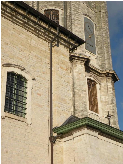
Goten en afvoeren koor en nieuwe sacristie, 2018.
