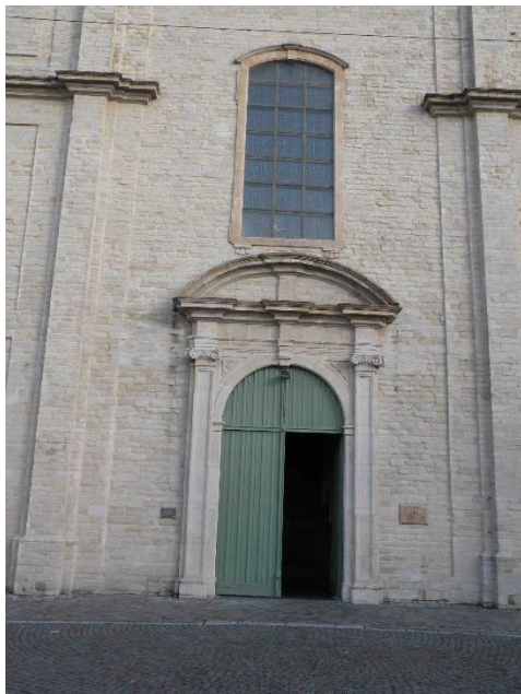
Buitenmetselwerk met omlijstingen, voorgevel, 2018.
