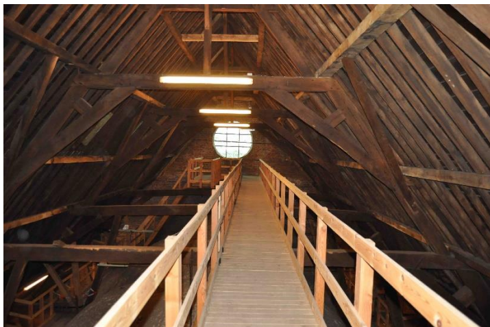
Kapconstructie benedenkerk, loopbruggen, 2017.
