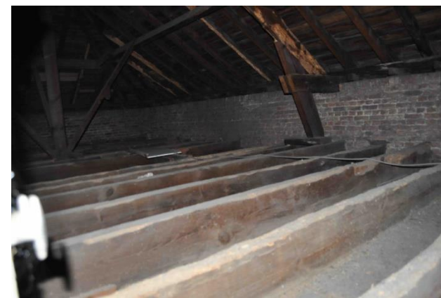
Kapconstructie nieuwe sacristie (zuidelijke), 2017.
