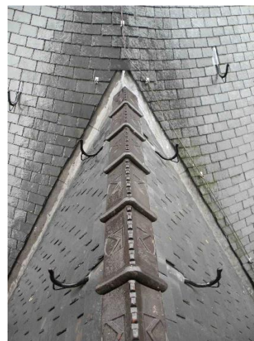
Nok aansluiting koor-toren, ladderhaken, 2017.
