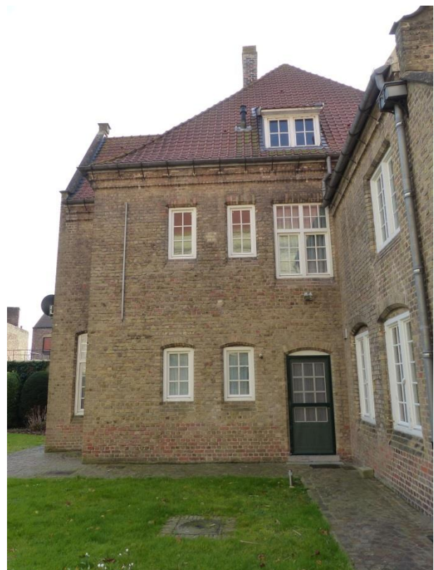
Figuur 35 noordgevel linkerzijsaliet (AS, 13.02.2019)
