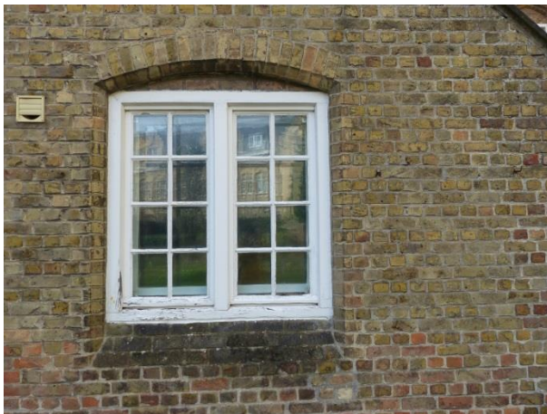
Figuur 83 Oostgevel: staat schrijnwerk. Achterzetramen zichtbaar van buitenuit (AS, 13.02.2019)
