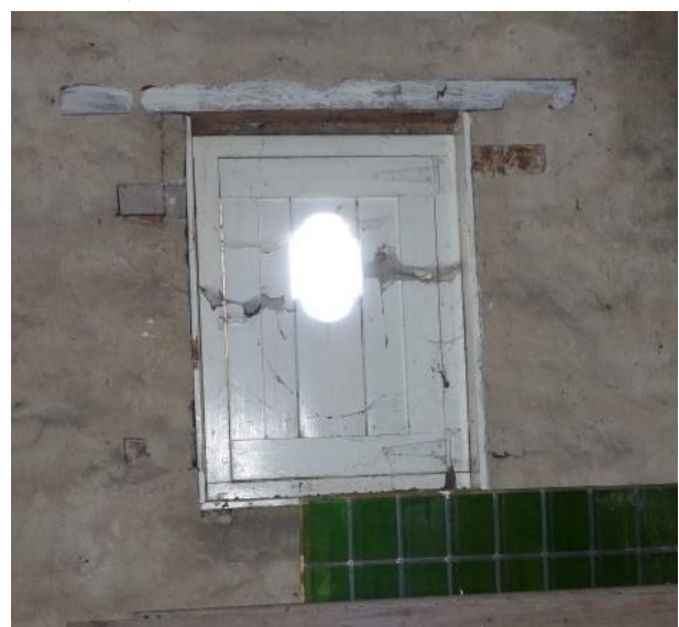
Figuur 97 Zolderluik oostgevel (AS, 13.02.2019)
