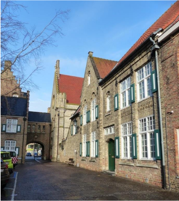
Figuur 26 Voorgevel gezien vanaf het zuiden (AS, 23.01.2019)
