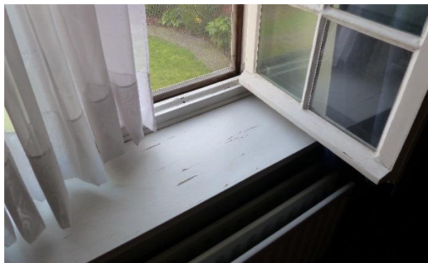
Figuur 130 Verf bladdert af (AS, 13.02.2019)
