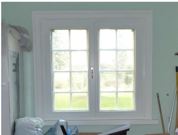
Figuur 65 Houten voorzetraam (AS, 13.02.2019)
