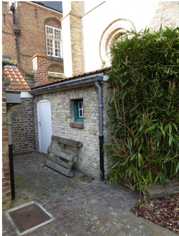
Figuur 101 Recenter buitenschrijnwerk (AS, 13.02.2019)
