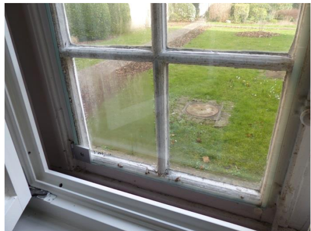
Figuur 66 Combinatie van twee types voorzetramen. Vuilophoping en oppervlakteschimmel in de spouw (AS, 13.02.2019)
