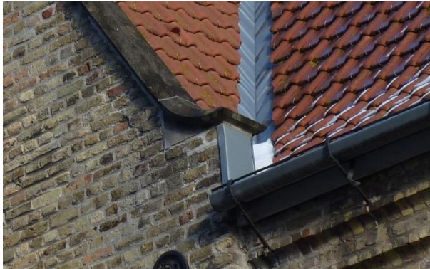
Figuur 48 Voorgevel: Dakaansluitingen in zink. Zinken goot in smeedijzeren goothaken. (AS, 23.01.2019)
