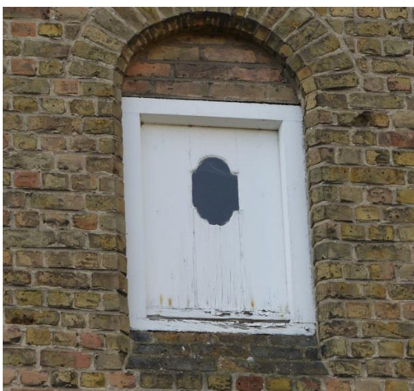
Figuur 96 Zolderluik oostgevel (AS, 13.02.2019)
