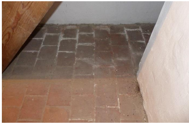
Figuur 128 Rode boomse tegels, zoutuitbloeiingen (AS, 13.02.2019)
