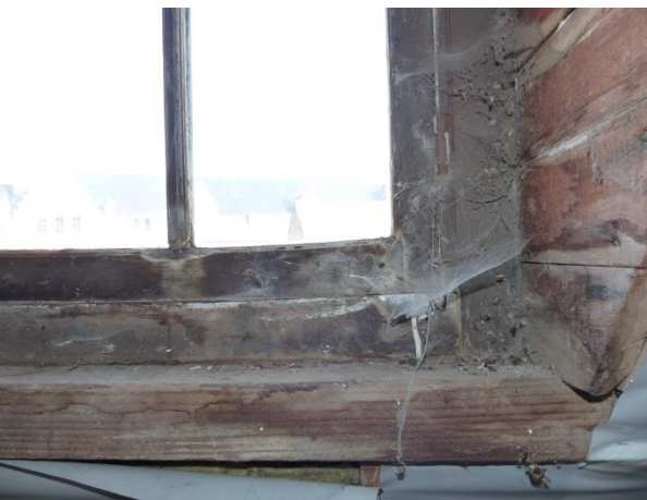
Figuur 60 (links) Detail dakkapel 1 (AS, 13.02.2019)
