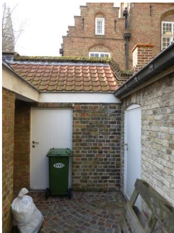
Figuur 41 Oostgevel volume B (AS, 13.02.2019)
