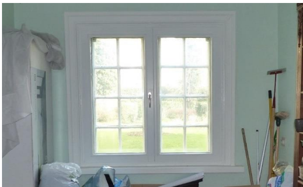
Figuur 129 Geprofileerde houten uitbekleding raam (AS, 13.02.2019)
