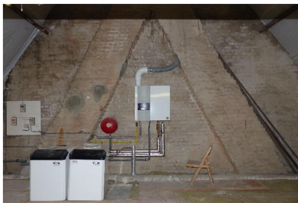
Figuur 118 Sporen van vochtinfiltratie en stof langsheen wanden (2V02) (AS, 13.02.2019)
