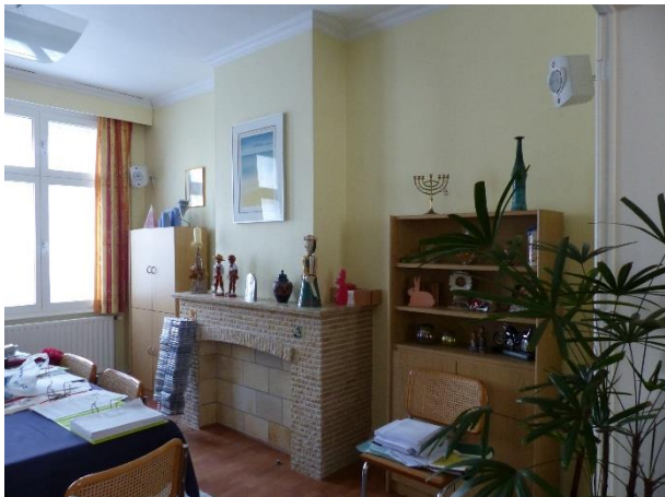
Figuur 144 Gemetste schouwmantel in leefruimte (G02) (AS, 13.02.2019)
