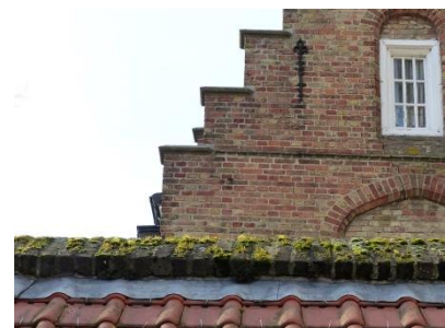
Figuur 106 Mosvorming op ezelsrug (AS, 13.02.2019)
