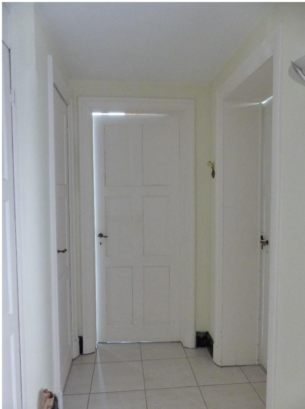
Figuur 131 Houten zespaneeldeuren met geprofileerde deurlijst (G07) (AS, 13.02.2019)
