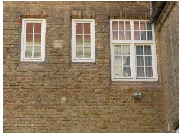
Figuur 82 Noordgevel: ramen verdieping (AS, 13.02.2019)
