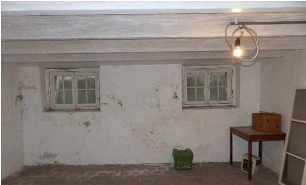
Figuur 115 Doorsijpelend grondvocht (K01) (AS, 13.02.2019)
