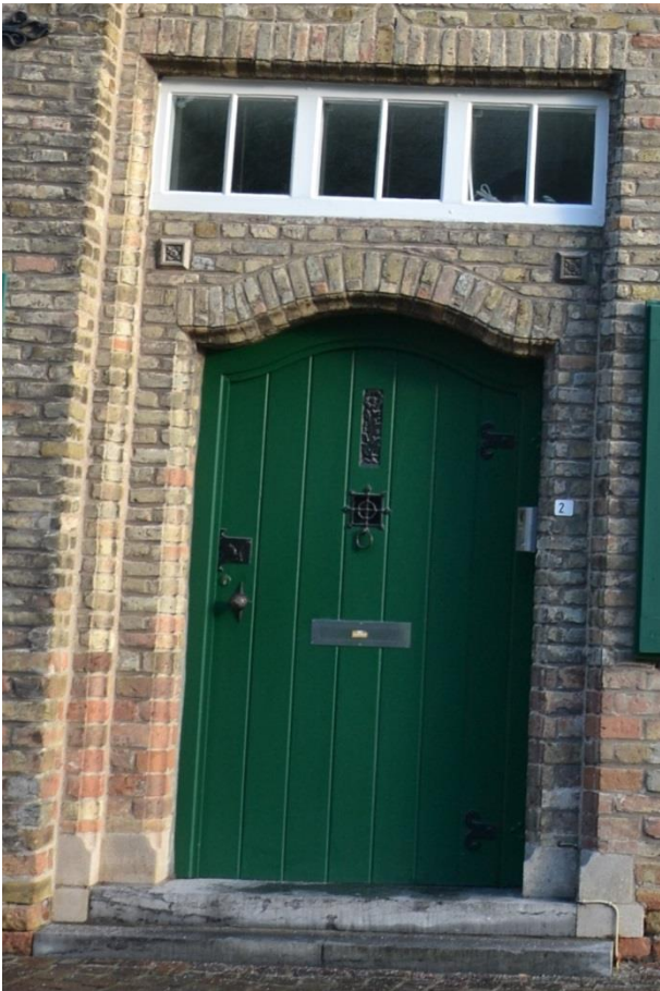
Figuur 67 Voordeur buitenzijde (AS, 13.02.2019)
