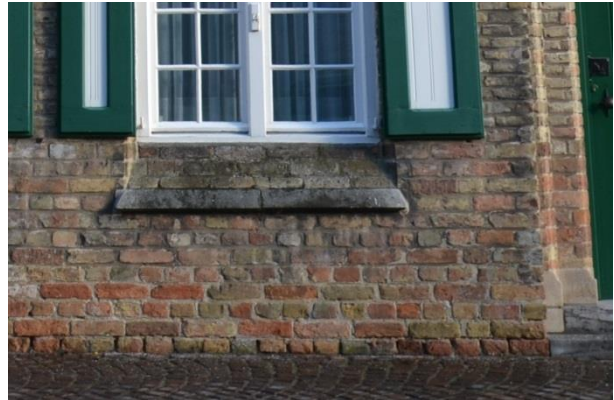
Figuur 29 Detail plint in ander type baksteen. Voegen uitgesleten door vocht. (AS, 23.01.2019)
