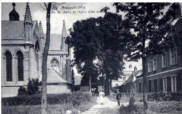
Figuur 17 Kerkstraat met rechts vooraan de voorgevel van de pastorie (Bron: S.N., Nieuport-Ville. Partie de l'église (côté Sud), UGent: BRKZ.TOPO.)
