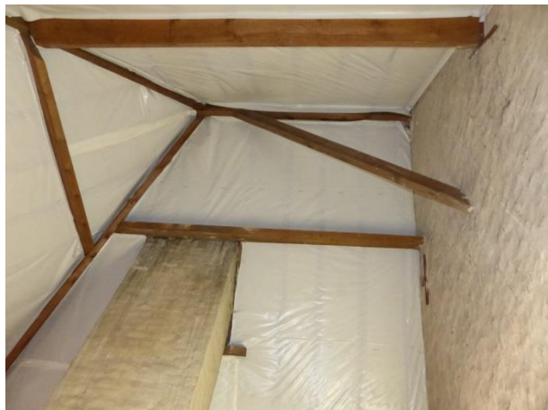
Figuur 55 Timmerwerk wolfsdak (AS, 13.02.2019)
