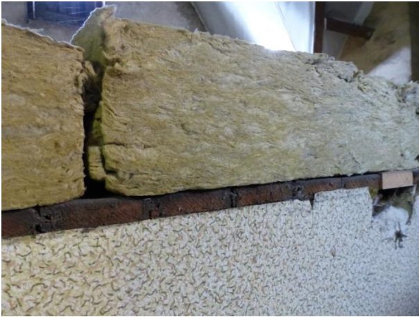
Figuur 62 Isolatie op zoldervloer (AS, 13.02.2019)
