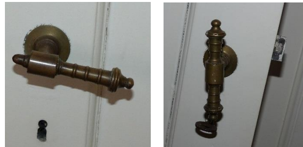
Figuur 133 Detail sluitwerk (AS, 13.02.2019)
