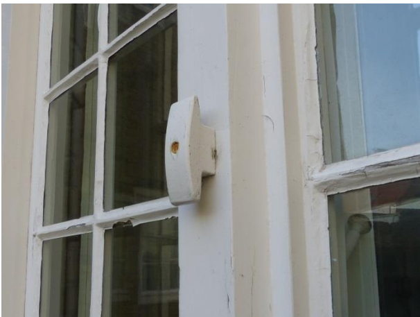
Figuur 91 Noordgevel: sluitwerk luiken (AS, 13.02.2019)
