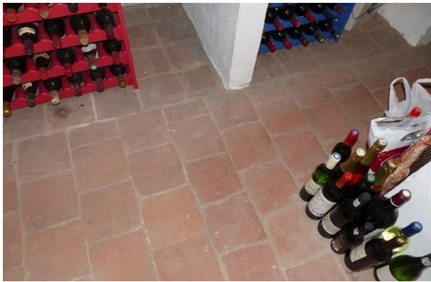
Figuur 127 Rode boomse tegels, zoutuitbloeiingen (AS, 13.02.2019)
