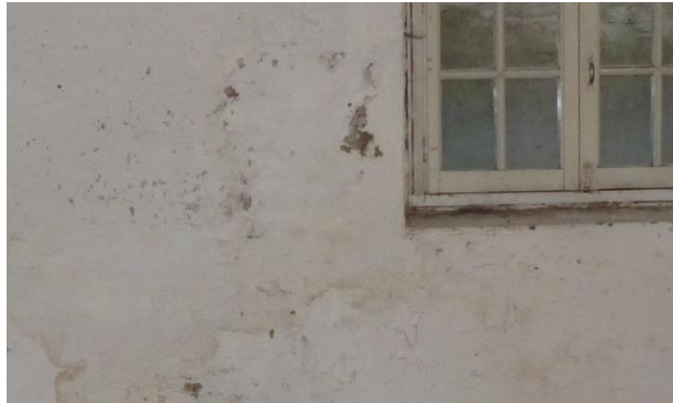
Figuur 116 Detail doorsijpelend grondvocht (K01) (AS, 13.02.2019)
