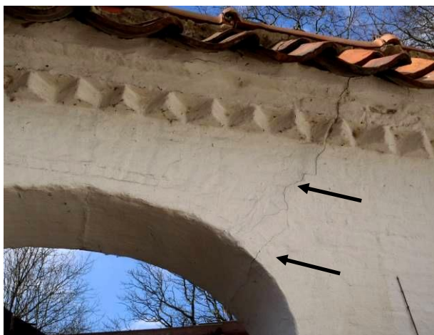
Diagonale scheurvorming boven poortje
