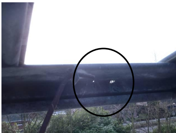
Doorgecorrodeerde onderregel
