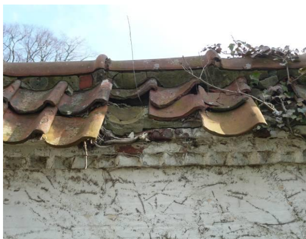
Beschadigde muurafdekking
