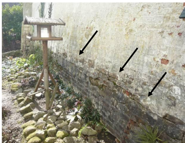
Horizontale scheurvorming
