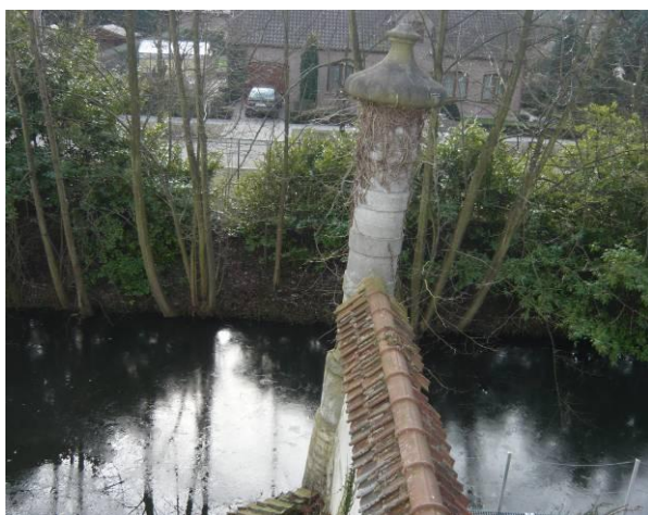
Overhellen muurafsluiting en kolom
