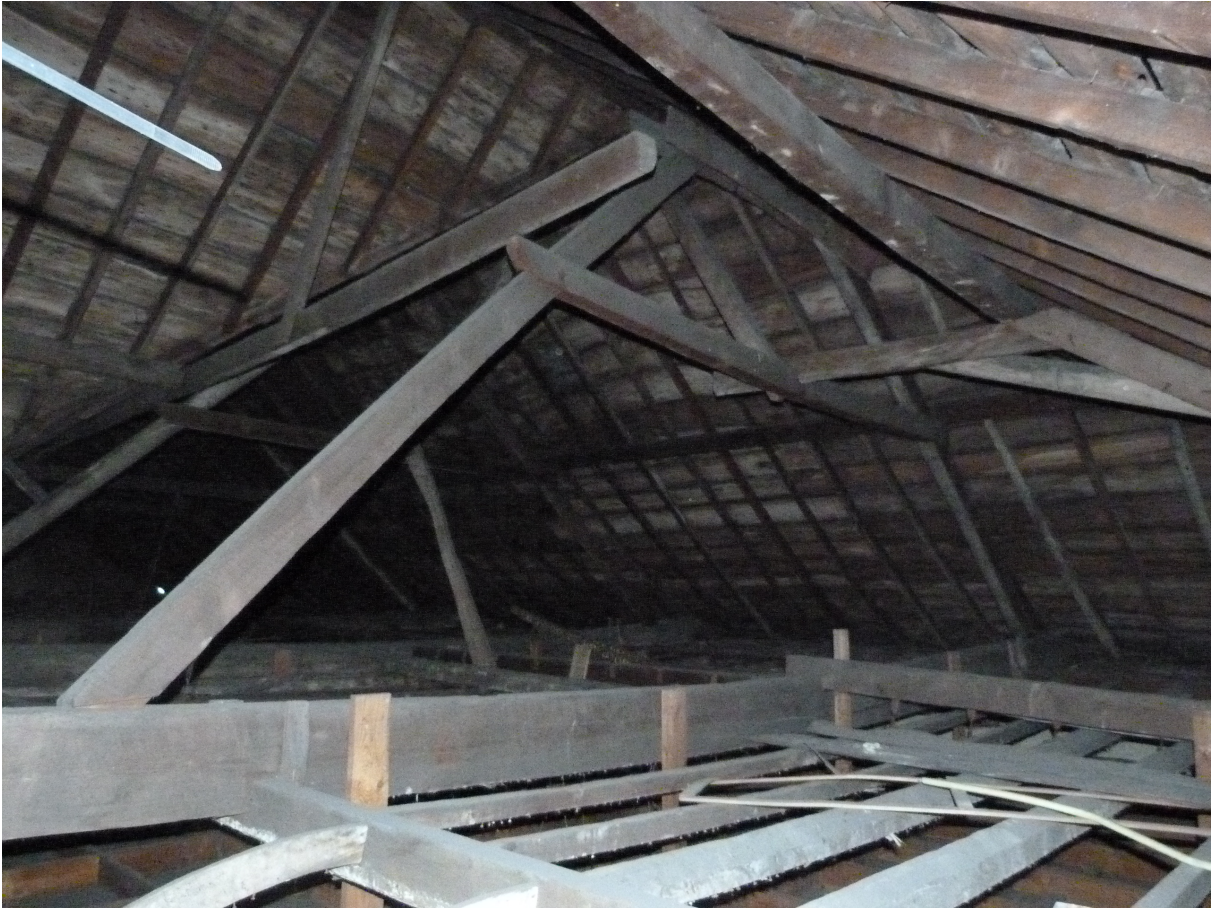
Foto R – Dakstructuur aan uiteinde kopse gevel van oostelijke vleugel U-vormig inkomgebouw
