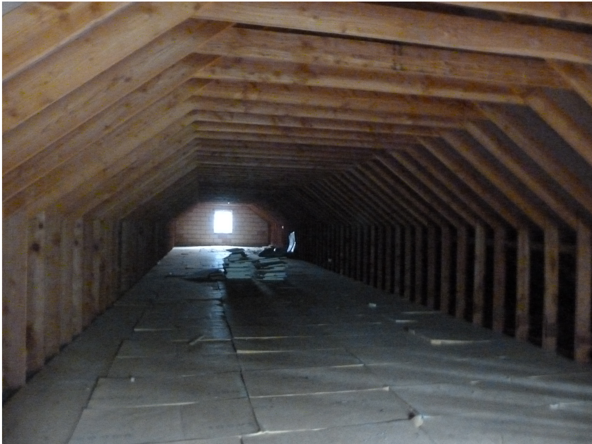
Foto L – Zolderverdieping L-vormig schoolgebouw anno 1988, lange arm
