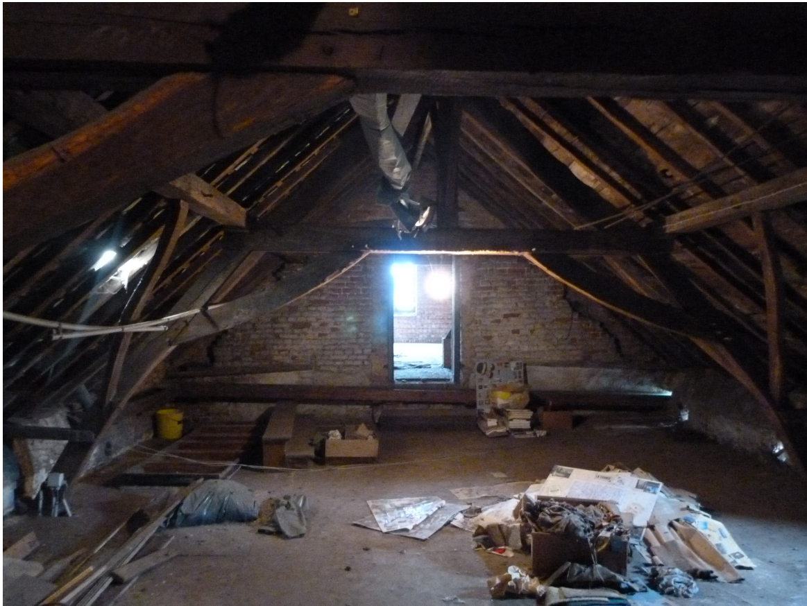
Foto P - Zolder boven schoolgebouw anno 1833
