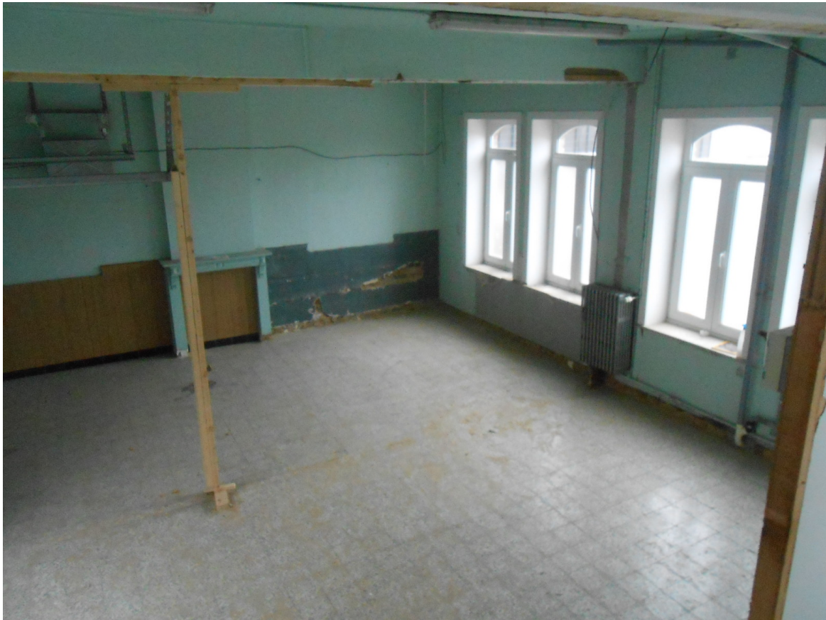
Foto H - Interieur straatvleugel gelijkvloers, gezien van 1 e verdiep
