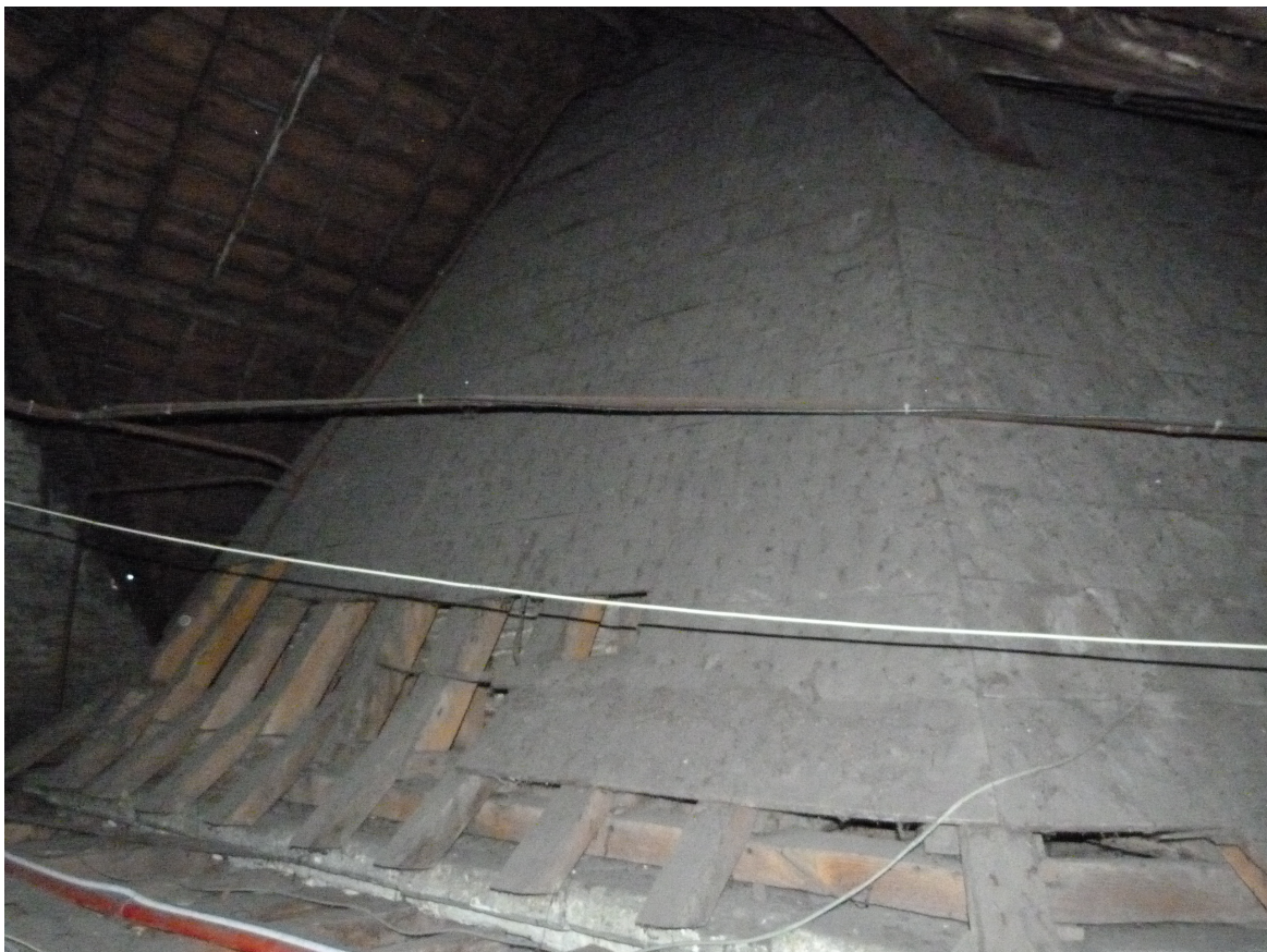
Foto Q - Aansluiting dak U-vormig inkomgebouw met dak OLV-kerk
