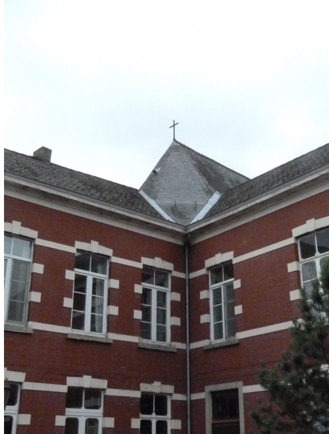
Foto 7 – Aansluiting U-vormig inkomgebouw met OLV-kerk
