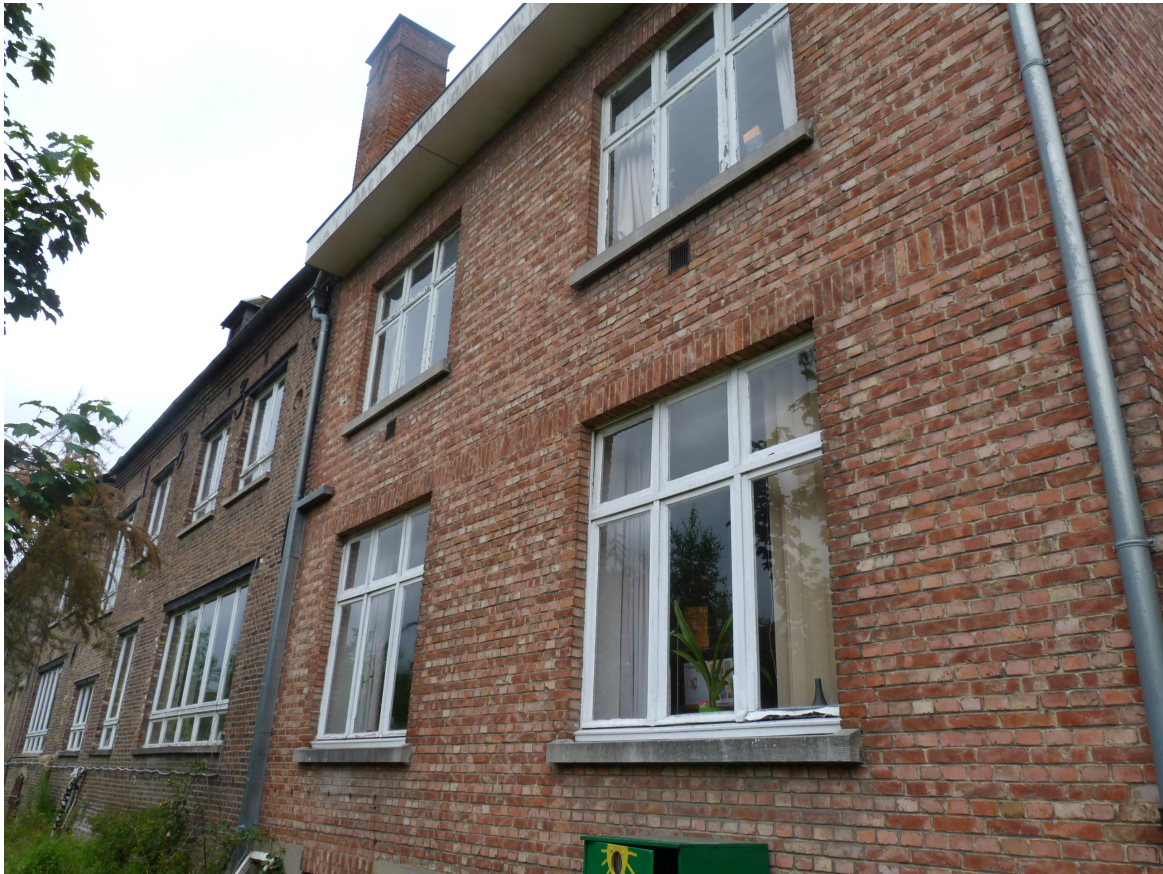
Foto 23 – Gevel uitbreiding anno 1947 langs zijde kloostertuin
