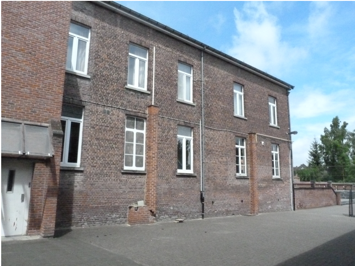
Foto 13 – Achtergevel centrale vleugel U-vormige inkomgebouw
