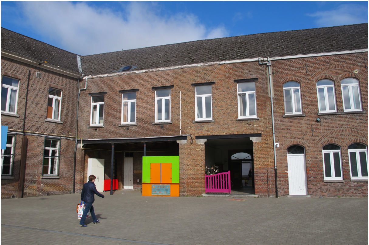
Foto 9 – Achtergevel straatvleugel vanaf speelplaats
