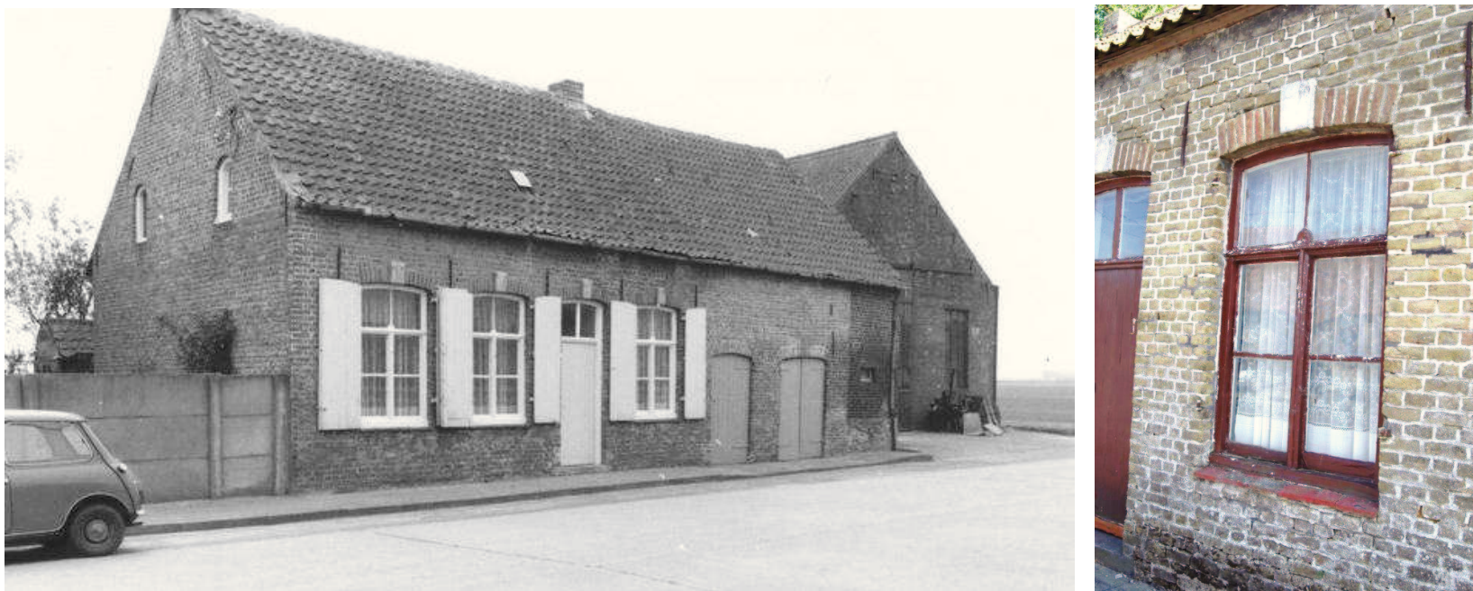
Fig. 6 . Leisele, Clachoire, Lostraat 10. T-kozijn met volle luiken. Toestand 1977 en 2010. Het schrijnwerk is bewaard maar bruin geschilderd. Het originele luikwerk is verdwenen.
