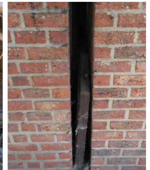
afb. 201: Restant van vuurvaste plaat tussen paapoven en laadruimte 2 © foto 22-08-2019.
