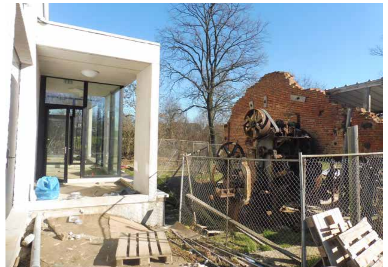
afb. 171: Huidige situatie (2018), kamer 1, zicht op de ruïne van tussenmuur (noord-west), voorbereidingsgebouw.
