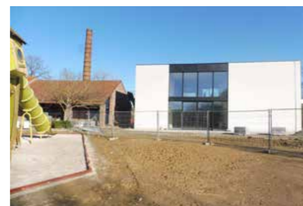
afb. 58: Inplanting centrumgebouw naast panoven (links).
