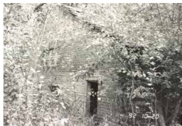
afb. 167: voorbereidingsgebouw, voorgevel (noord-west), 1992 © Agentschap Onroerend Erfgoed.
