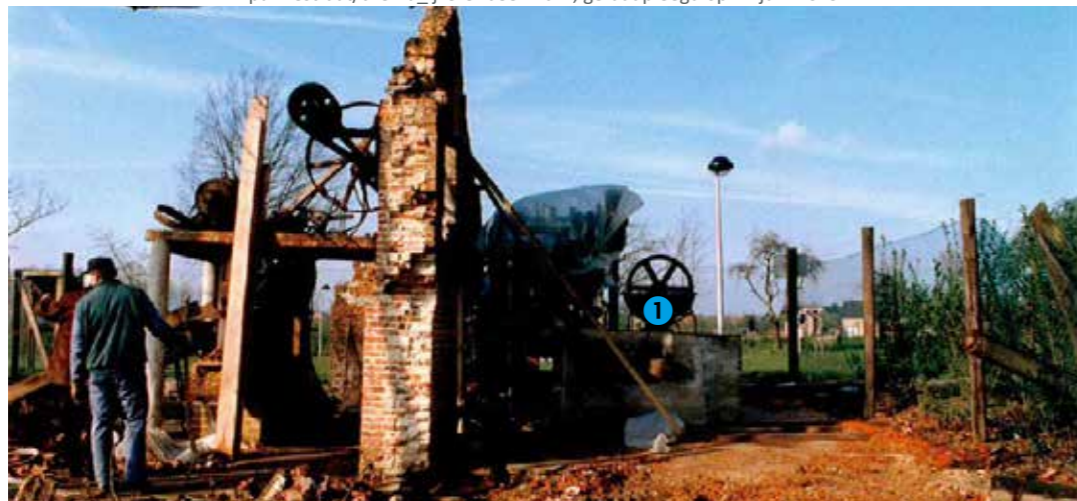
afb. 256: Rechts: nokpers (nr. 1) © J. Martens, "Rehabilitatie van de site Panoven Loksbergen", FOTODOSSIER, 1998, Provincie Limburg, Stad Halen, Beschermingsdossier De Panoven, Archief Onroerend Erfgoed, Provincie Limburg.
