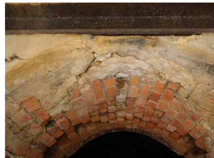
afb. 204: Laadingang van de paapoven, ovengebouw © foto 22-08-2019.
