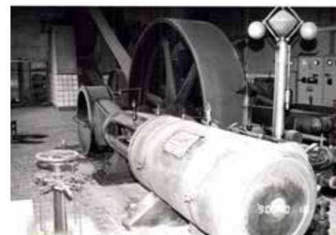
afb. 153: Machinekamer 1: stoommachine van Copenolle, Dakpannenfabriek De Pottelberg, Kortrijk © Agentschap Onroerend Erfgoed.
