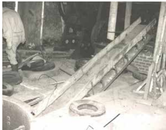
afb. 107: Transportband menger-strengpers (voorbewerking), Pannenfabriek Jorissen in Loksbergen, voormalig voorbereidingsgebouw © Agentschap Onroerend Erfgoed.
