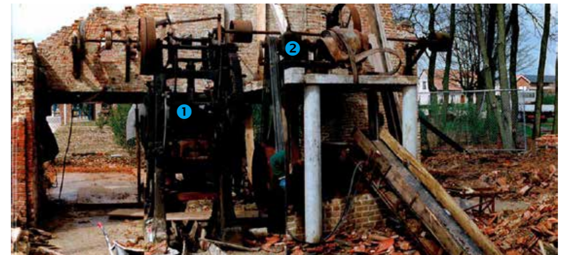
afb. 258: Links: vormpers (nr. 1) met bovenaan elektromotor (nr. 2) © J. Martens, "Rehabilitatie van de site Panoven Loksbergen", FOTODOSSIER, 1998, Provincie Limburg, Stad Halen, Beschermingsdossier De Panoven, Archief Onroerend Erfgoed, Provincie Limburg.
