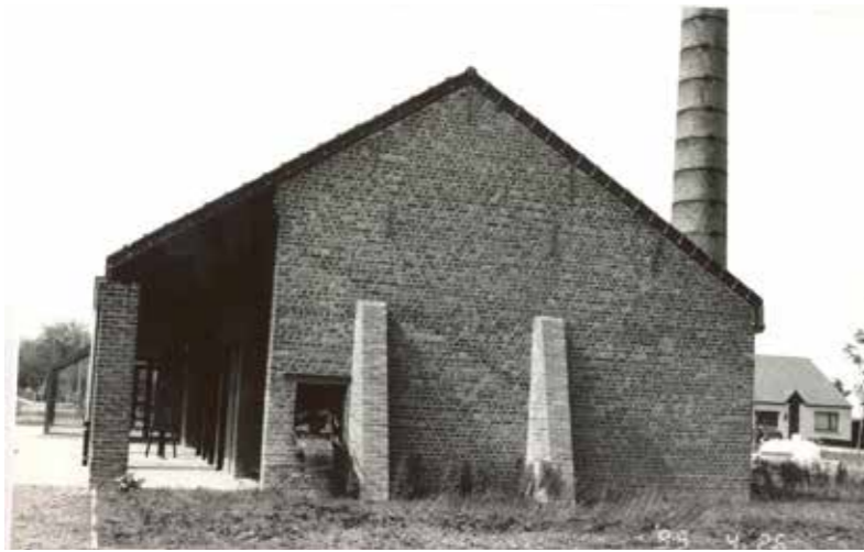
afb. 130: Pannenfabriek Jorissen in Loksbergen, gebouw met de ovens © Agentschap Onroerend Erfgoed.
