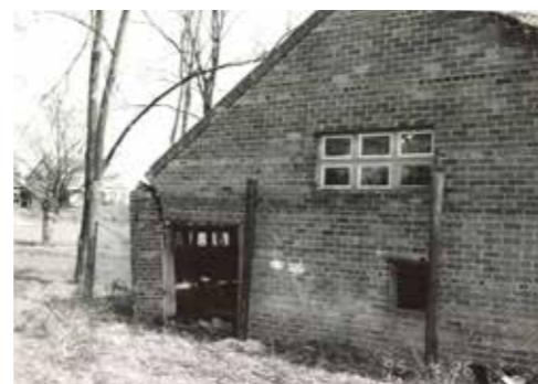
afb. 96: Pannenfabriek Jorissen in Loksbergen, voormalig voorbereidingsgebouw © Agentschap Onroerend Erfgoed.
