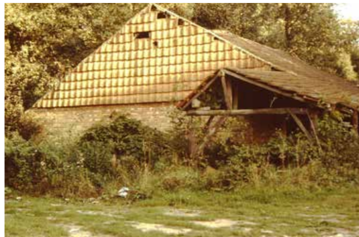
afb. 117: Voormalige droogloods, Loksbergen, De Panoven.
