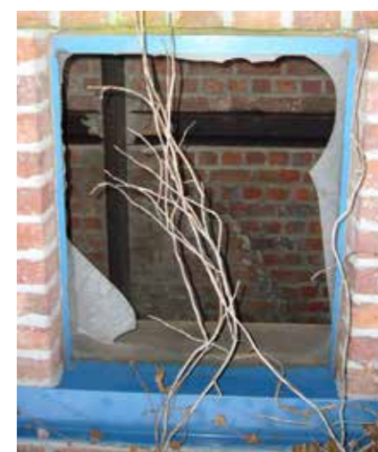
afb. 185: Huidige situatie (2017), achterzijde ovengebouw, detail.
