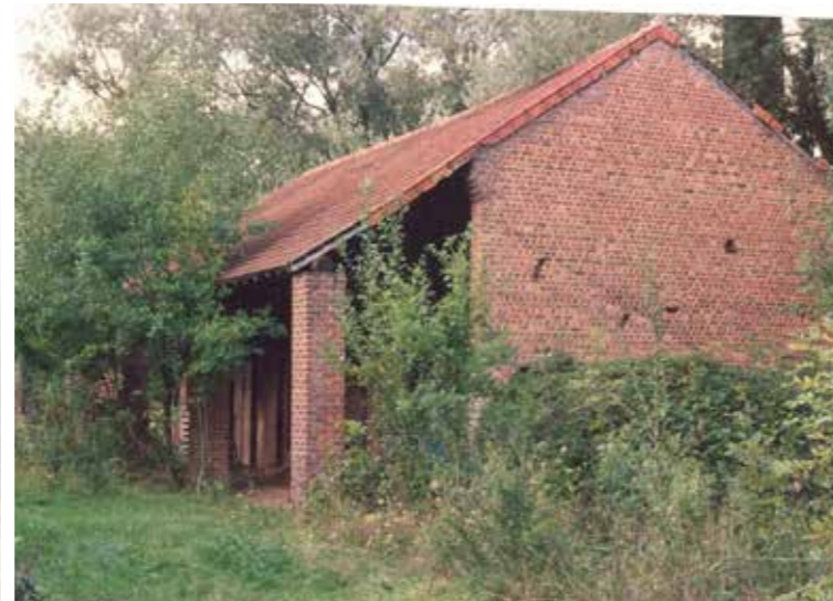
afb. 176: Ovengebouw, zicht noordoosten, datum onbekend (1992?) © Agentschap Onroerend Erfgoed.
