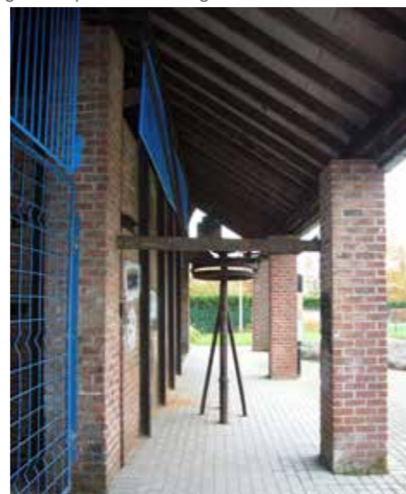
afb. 178: Huidige situatie, ovengebouw
