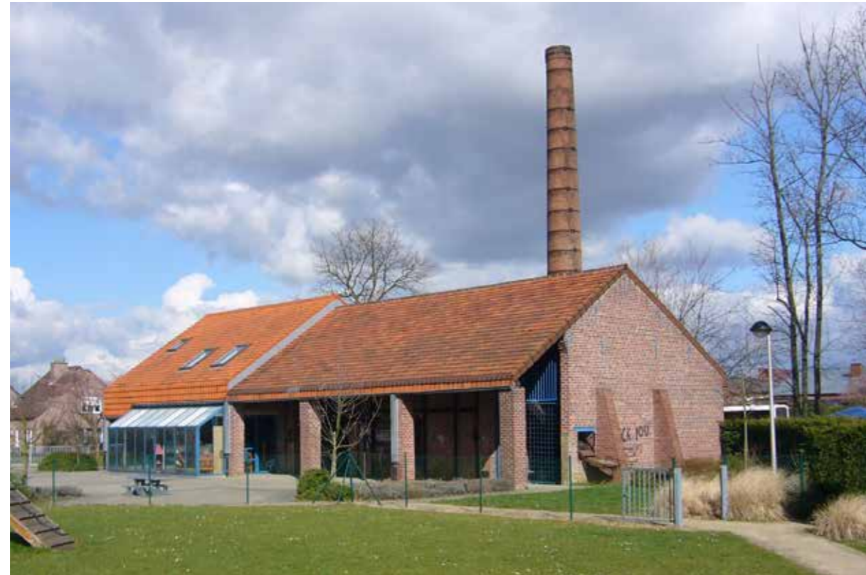
afb. 172: Huidige situatie (2017), ovengebouw met aanbouw.
