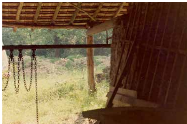
afb. 118: Voormalige droogloods, Loksbergen, De Panoven.
