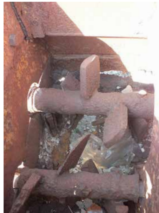
afb. 274: Voed-schoepen in bunker (trog) van klei extrudeermachine, gemeentelijke magazijnen, Halen.
