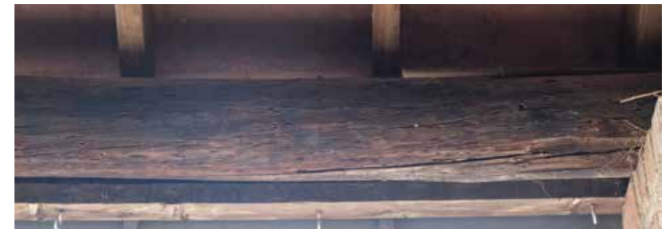
afb. 290: Detail hergebruikte electriciteitspaal dakconstructie ovengebouw © foto 22-08-2019.
