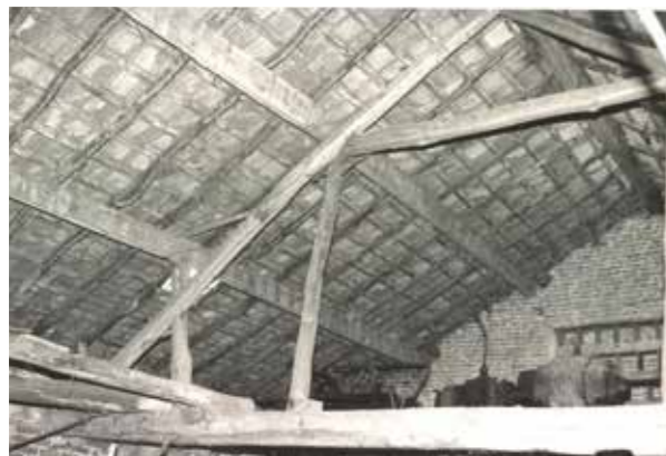
afb. 168: voorbereidingsgebouw, interieur, zicht op noord-west voorgevel (linkerkant), 1992 © Agentschap Onroerend Erfgoed.
