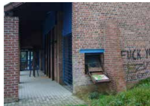
afb. 148: Voormalige transportband, Pannenfabriek Panoven, Loksbergen .
