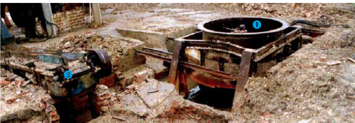
afb. 242: IJzeren mengkuip (nr. 1) en transportband aanvoer (nr. 2), transportband afvoer (nr. 3), strengpersmachine (nr. 4) © Martens, "Rehabilitatie van de site Panoven Loksbergen", FOTODOSSIER, 1997-1998, Provincie Limburg, Stad Halen, Beschermingsdossier De Panoven, Archief Onroerend Erfgoed, Provincie Limburg.
