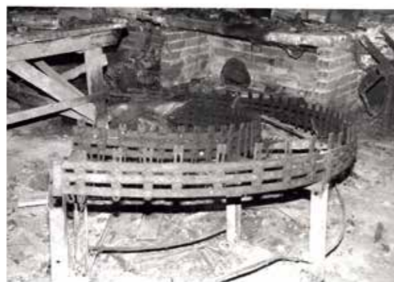
afb. 112: Gedemonteerde transportband, Pannenfabriek Jorissen in Loksbergen, voormalig voorbereidingsgebouw © Agentschap Onroerend Erfgoed.
