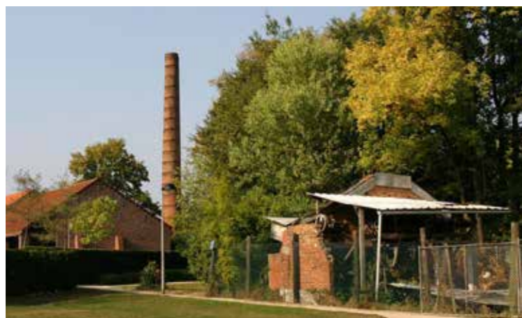
afb. 158: Huidige situatie, voorbereidingsgebouw (zijgevel zuid-west) © Archeonet Vlaanderen.
