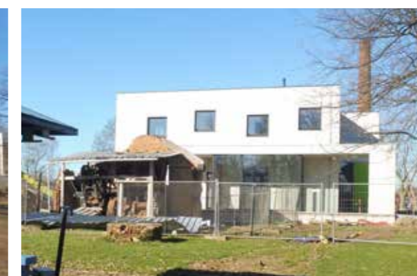
afb. 59: Inplanting centrumgebouw met vooraan restant van voorbereidingsgebouw.
