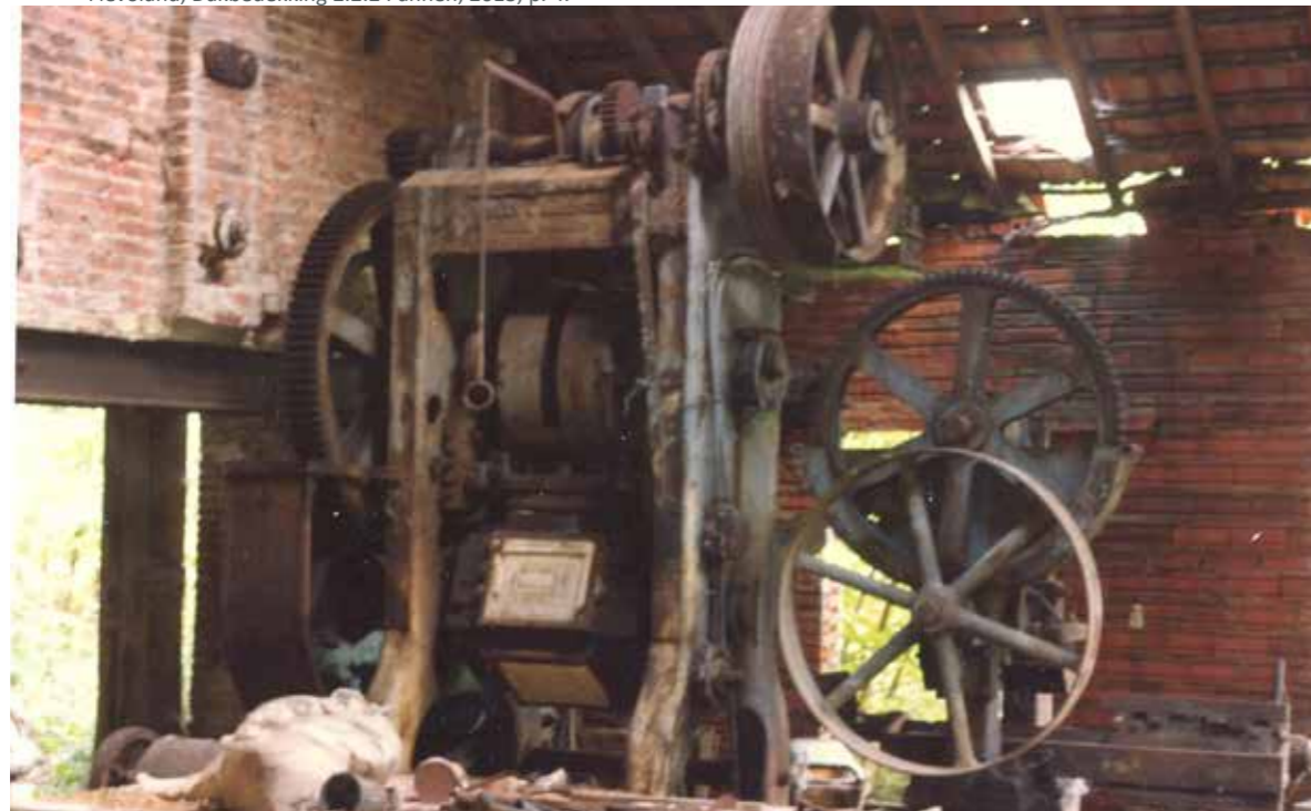
afb. 100: Pannenfabriek Jorissen in Loksbergen, twee vormpersen: vormmachine 'Winnen & Büschges - Boisheim Rheinland' © Agentschap Onroerend Erfgoed.
