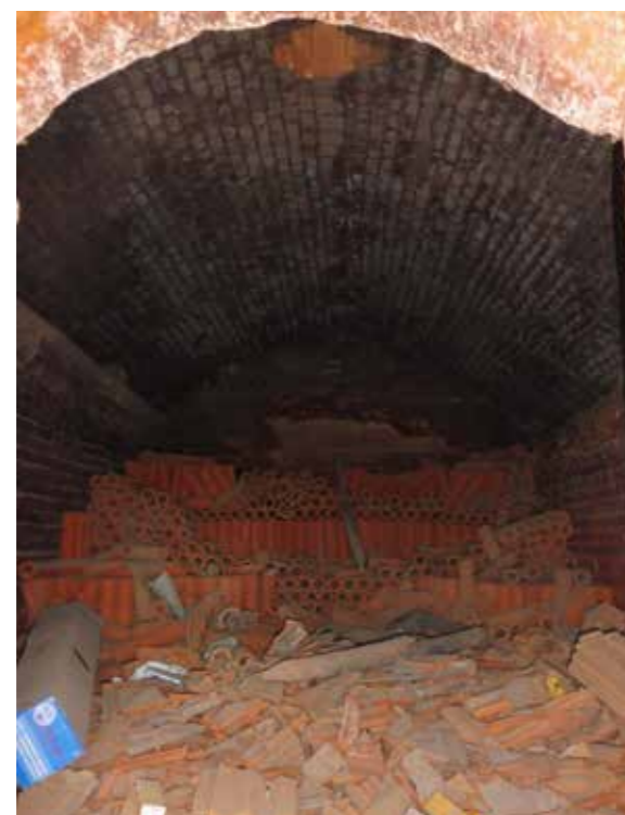
afb. 45: Oven, Panoven te Loksbergen.
