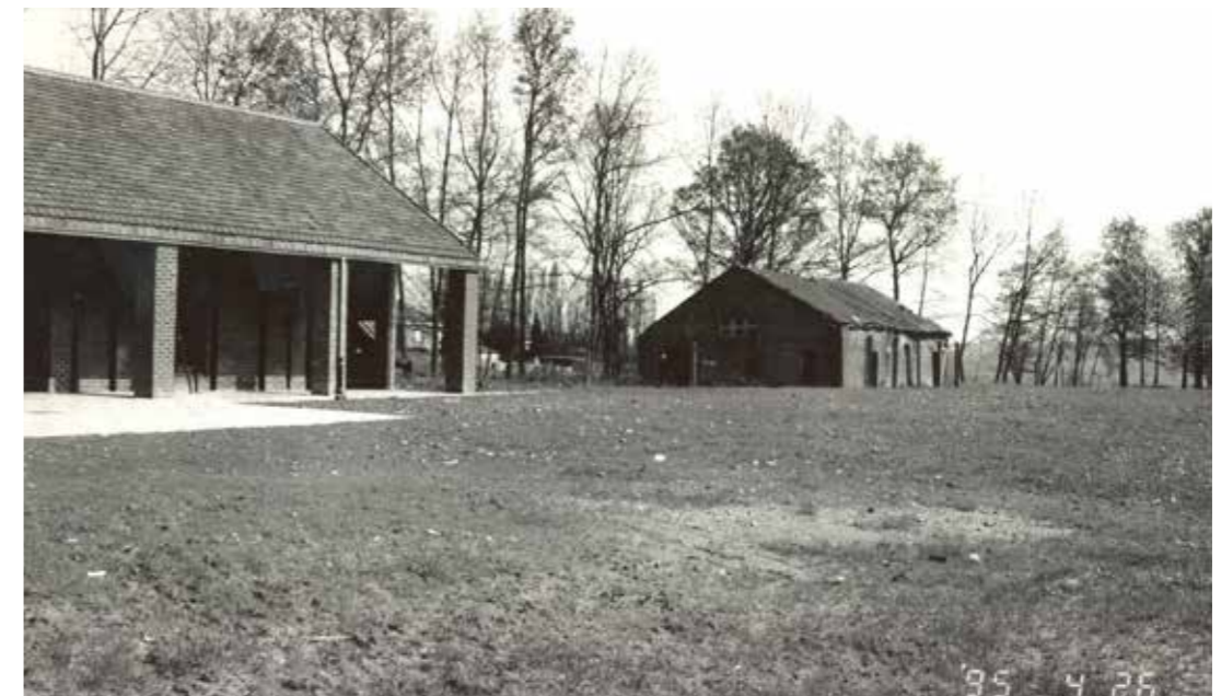
afb. 72: Ovengebouw en voorbereidingsgebouw © Agentschap Onroerend Erfgoed, 1995.
