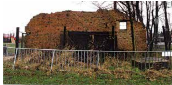
afb. 163: Achtergevel (zuid-oost) © J. Martens, "Rehabilitatie van de site Panoven Loksbergen", FOTODOSSIER, 1997, Provincie Limburg, Stad Halen, Beschermingsdossier De Panoven, Archief Onroerend Erfgoed, Provincie Limburg.
