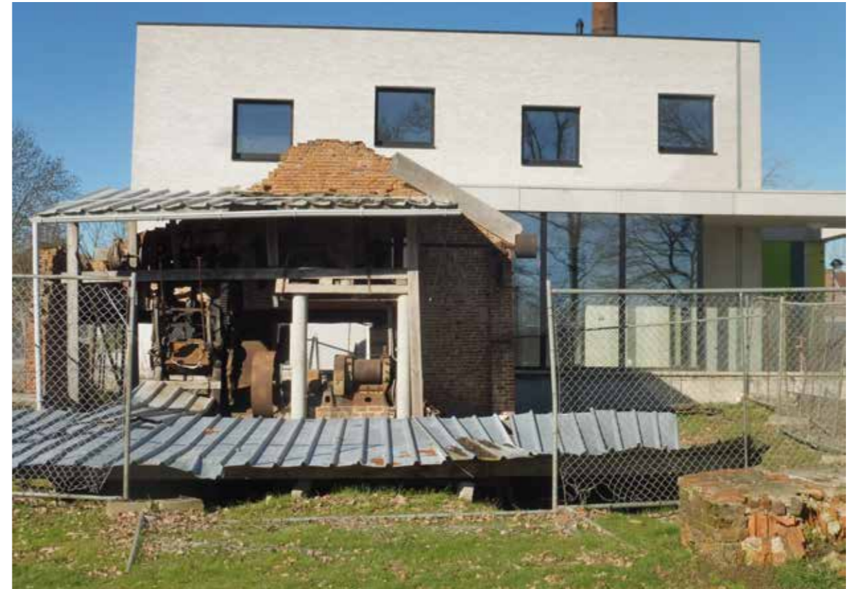
afb. 170: Huidige situatie (2018), kamer 2, zicht op de ruïne van achtergevel (zuid-oost), voorbereidingsgebouw.
