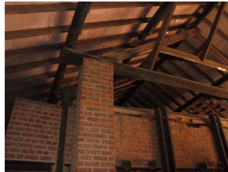
afb. 197: Dakconstructie boven paapoven.
