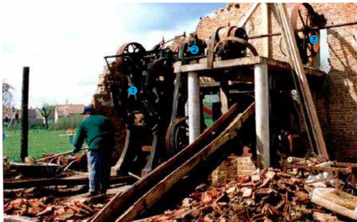
afb. 259: Links: vormpers (nr. 1) met bovenaan elektromotor (nr. 2) en aandrijfwielen (nr. 3) © J. Martens, "Rehabilitatie van de site Panoven Loksbergen", FOTODOSSIER, 1998, Provincie Limburg, Stad Halen, Beschermingsdossier De Panoven, Archief Onroerend Erfgoed, Provincie Limburg.
