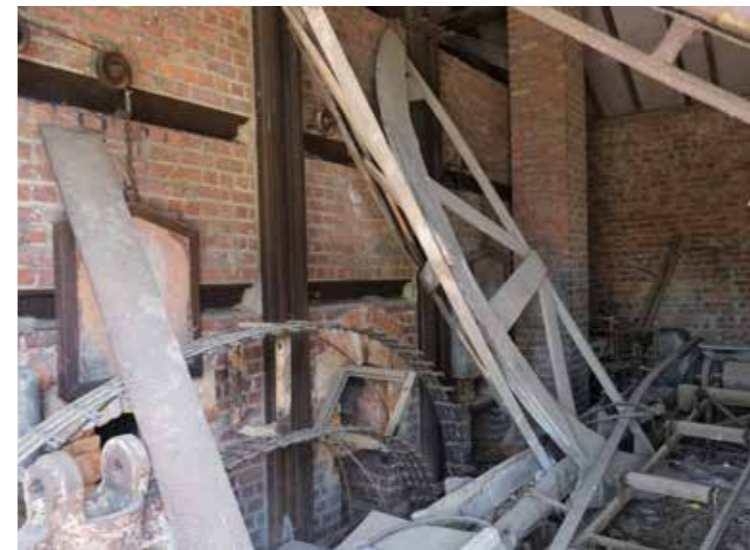
afb. 202: Interieur, laadruimte 2 met stookgaten en opslagplaats, ovengebouw © foto 22-08-2019.
