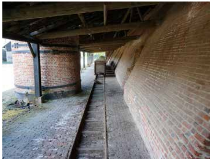
afb. 144: Bedrijfssporen rondom de oven van de Steenbakkerij Frateur, Noeveren © Erfgoed Rupel.
