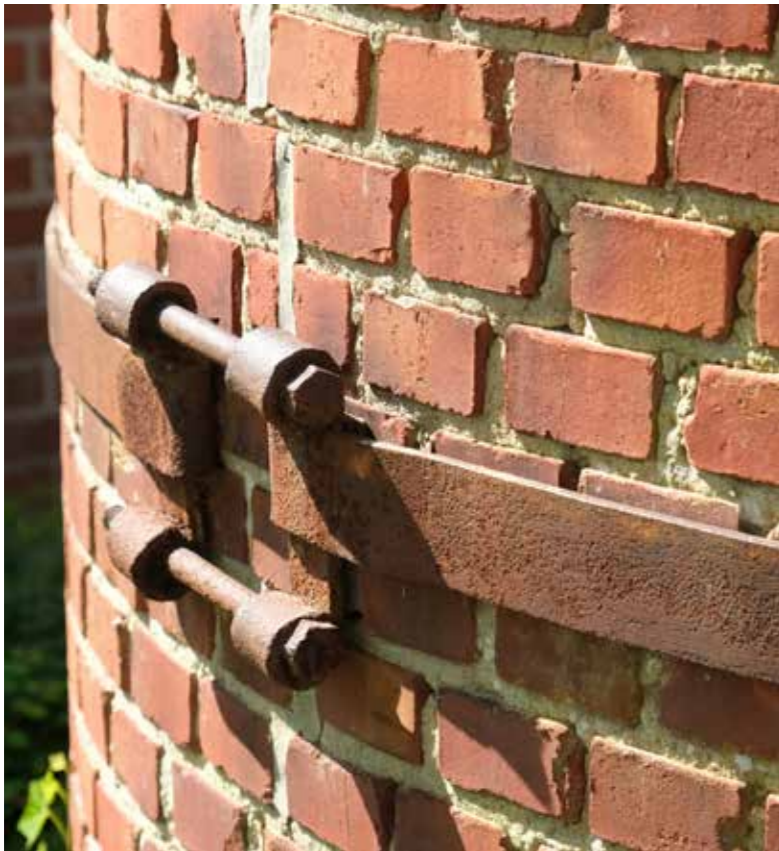
afb. 210: Detail, Schoorsteen van de Panoven.
