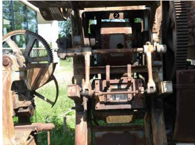
afb. 34: Machinerie in het voorberekingsgebouw, kamer, 1, huidige toestand © foto 22-08-2019.
