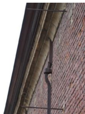
Ankerstaaf in zijgevel
