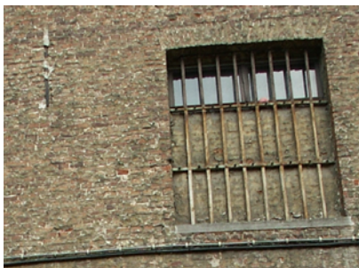
Gevel Klapstraat met smeedwerk en ingemetselde ankers
