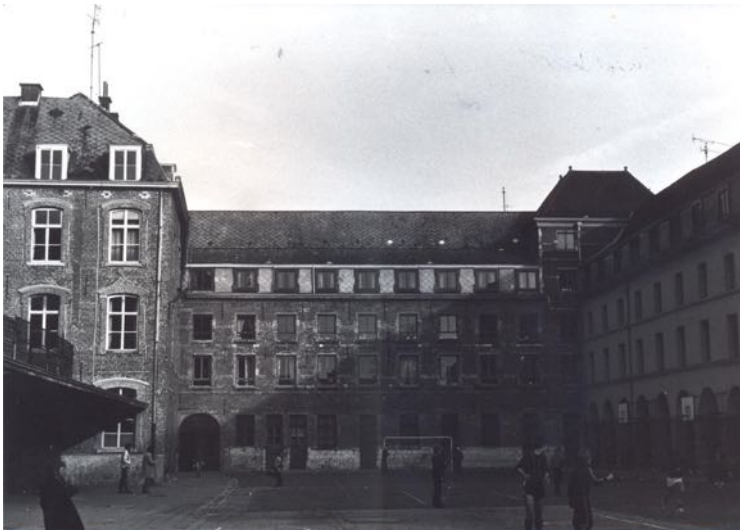
Achtergevel zonder afdak en bovenaan ziet men de extra verdieping op de hoek.
