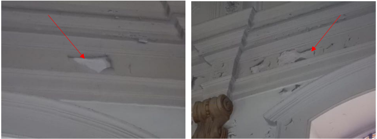
Afbladdering van verf bij de fries en kroonlijst
