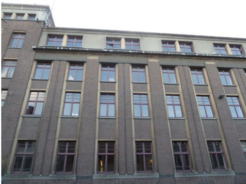
Buitenschrijnwerk in de voorgevel
