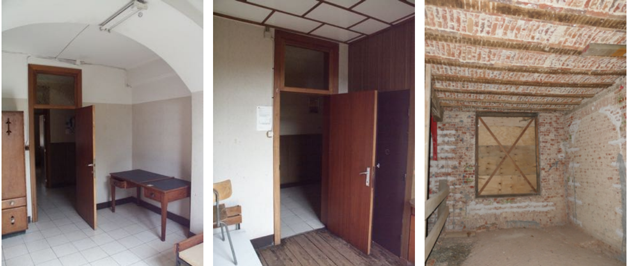
Kamers van de eerste verdieping voor en na het strippen van de afwerkklagen
