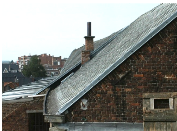
Dak van pand B
