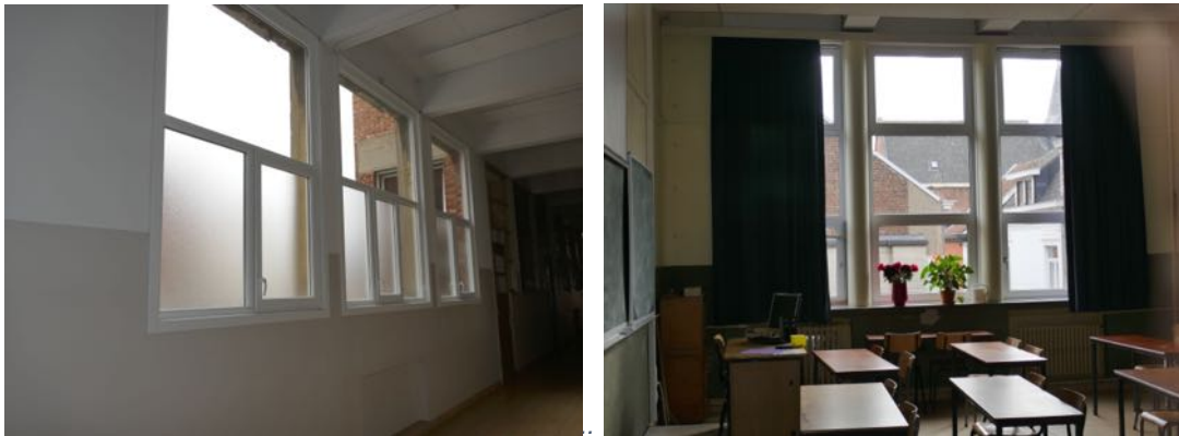
ramen zonder erfgoedwaarde op de eerste en tweede verdieping
