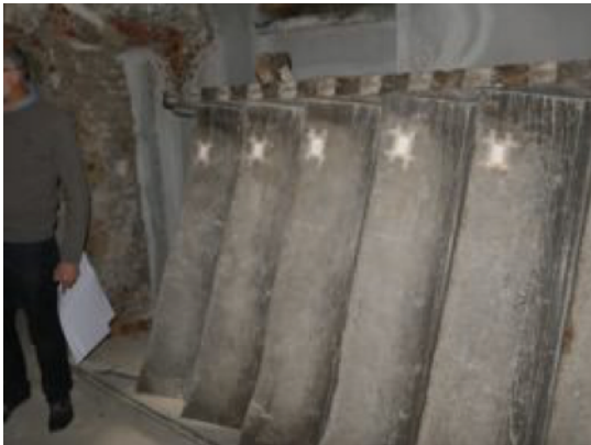
Ontmantelde trap die bewaard wordt tot na de werken en nog gerestaureerd wordt
