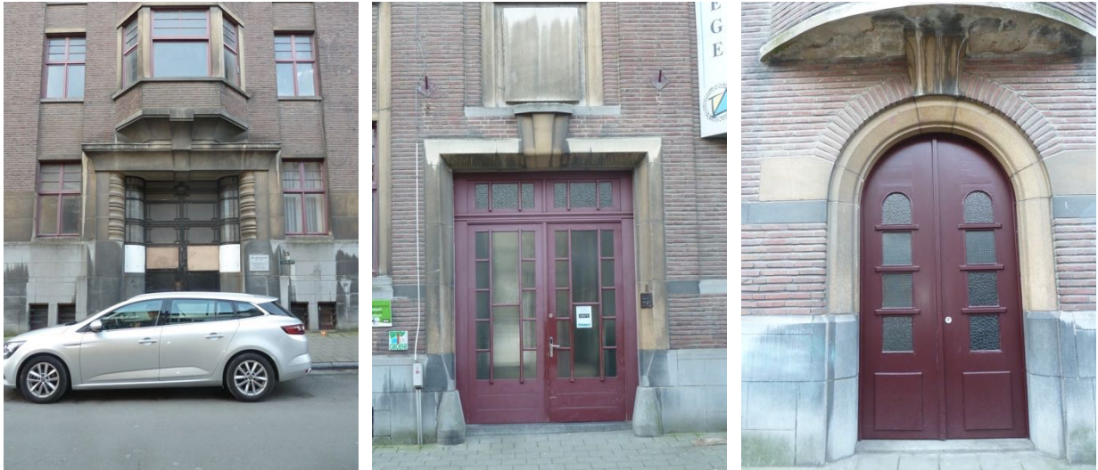
Buitendeur inkom links in staal, buitendeur midden en buitendeur rechts onder erker.
