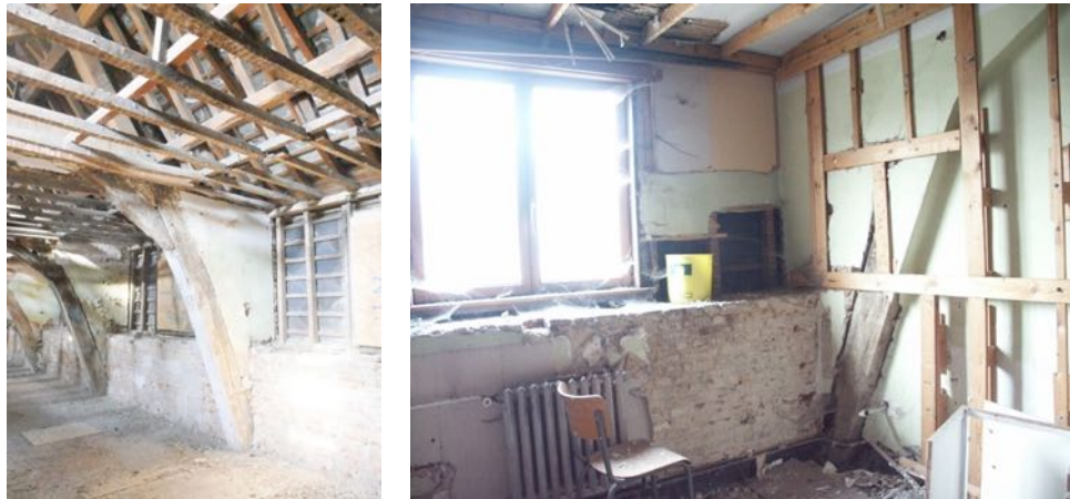
Europees eiken dakstructuur; Afb. 3: Eikenhouten balk in een van de internaatkamers
