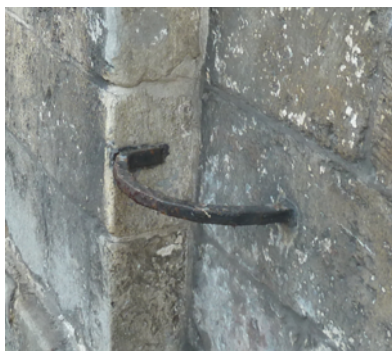
Voetschraper in voorgevel
