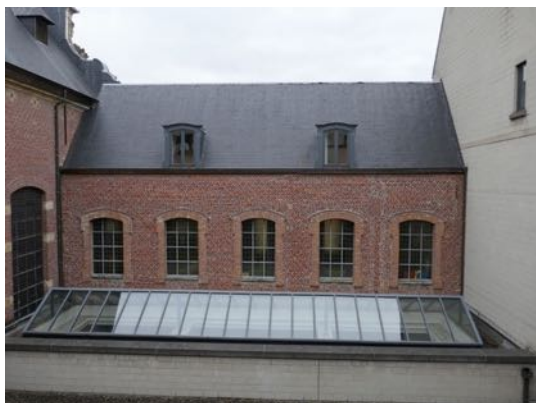
Achtergevel van pand G
