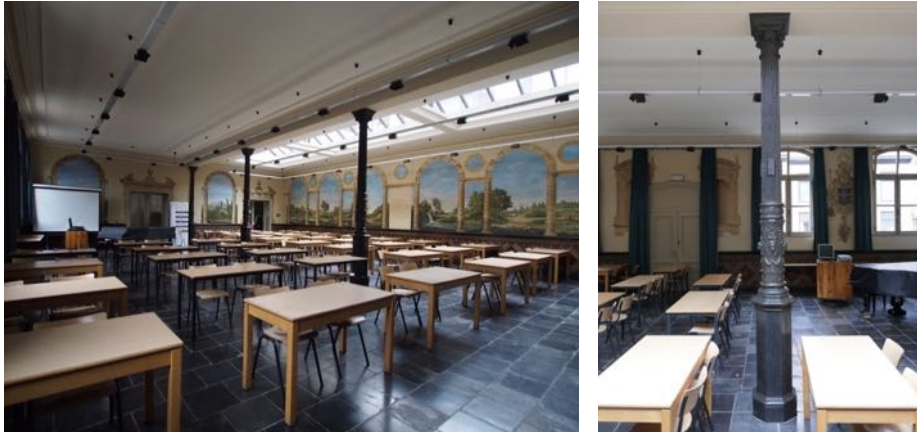
Refter op het gelijkvloers met gietijzeren kolommen.
