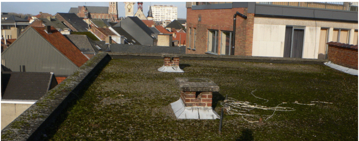
Dakdichting met grindbelasting
