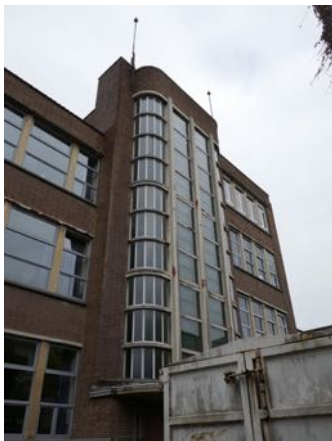
Reeds behandelde wapening bij de trappenhal
