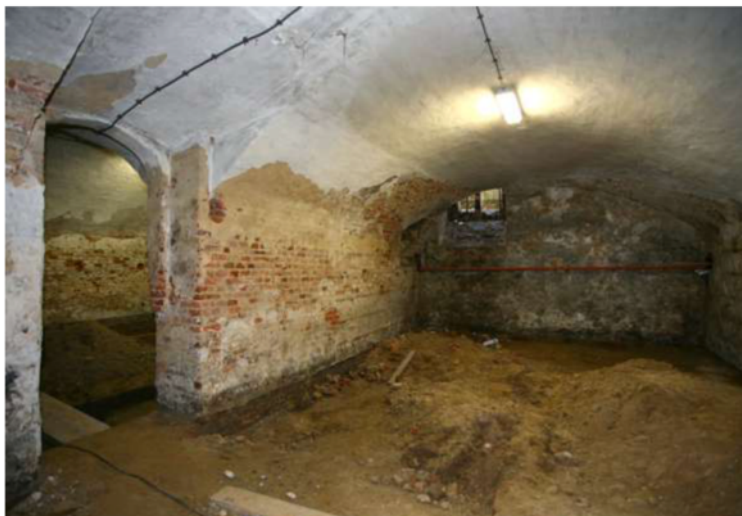
Derde noordelijke kelder, gezien naar het westen.
