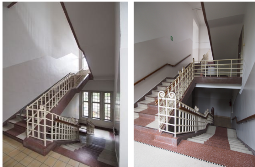
Toegevoegde trap en loopbrug, uitgevoerd in granitvloer
