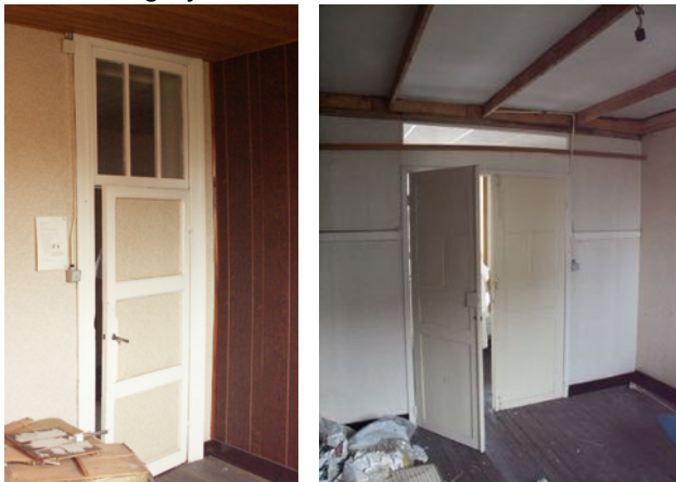
Deuren van de derde verdieping
