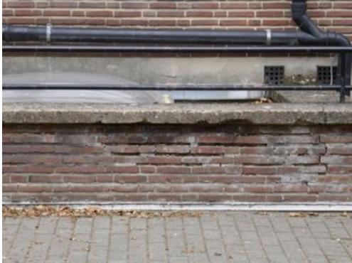
Baksteenmetselwerk van pand C
