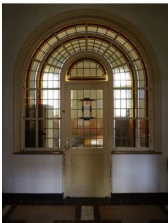
glas-in-lood binnenschrijnwerk
