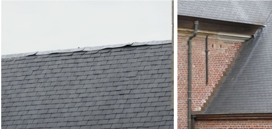
Dakbedekking van pand G
