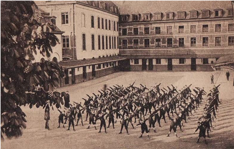
Achtergevel pand A met bepleistering van de begane grond en dakkapelen.
