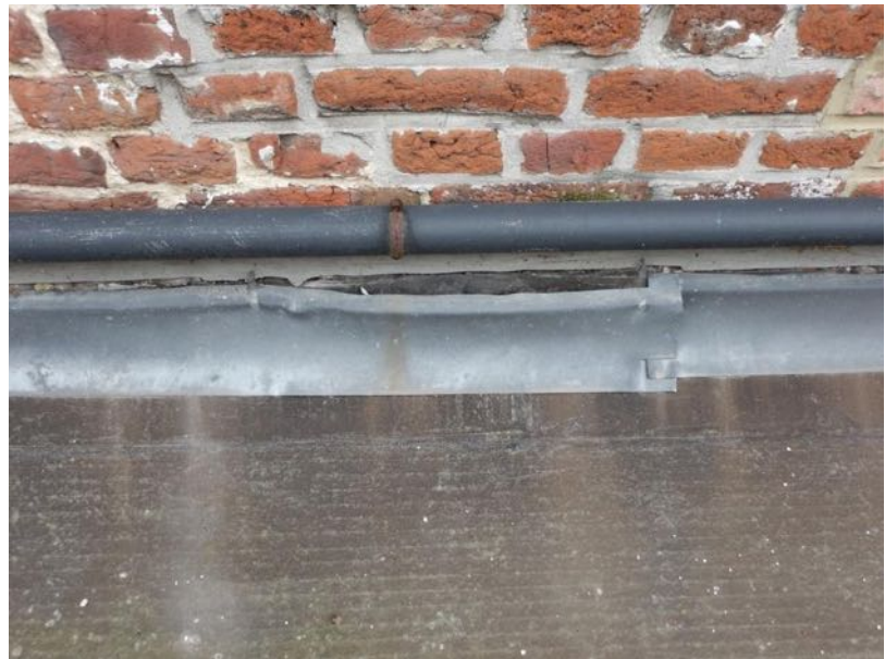
Aansluiten van het plat dak
