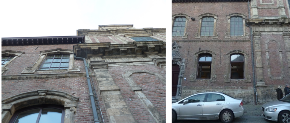
Voorgevel met kroonlijst op modillons en afvoergoot rechts.
