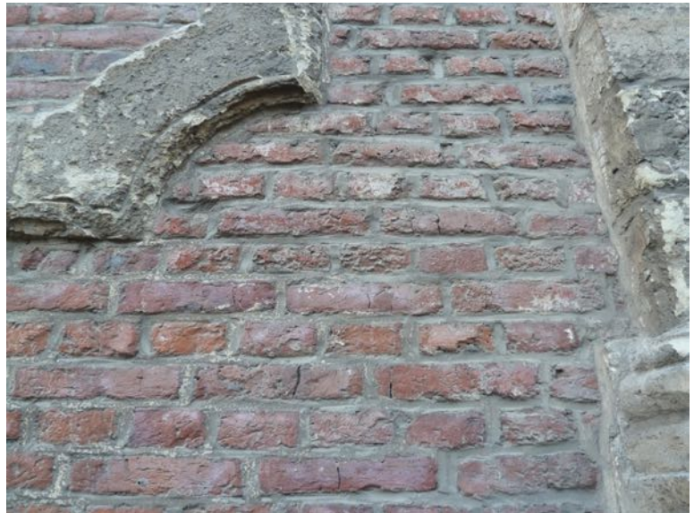
Baksteenmetselwerk van de voorgevel
