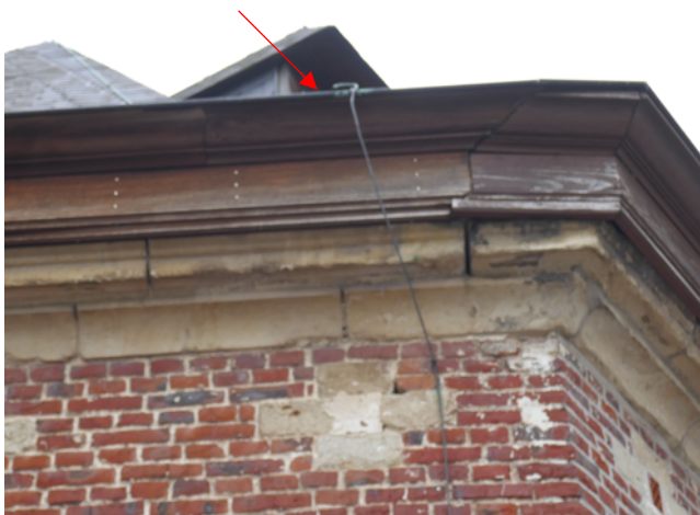
Gebroken bliksemafleiding
