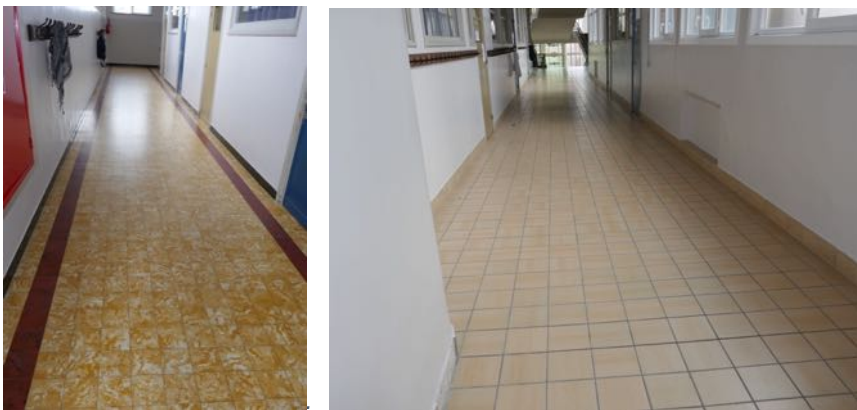
Vloer van de tweede verdieping
