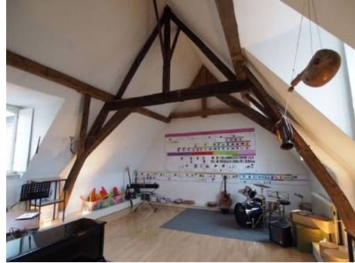
Vloer tweede verdieping
