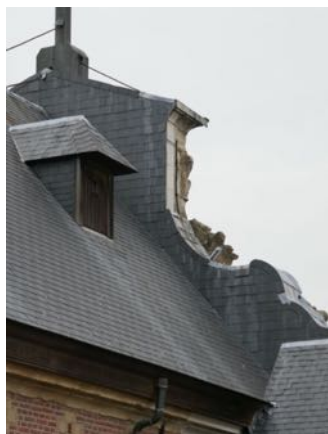
Achterzijde van de voorgevel van de kerk
