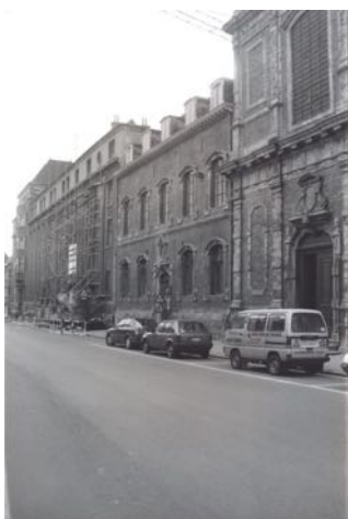
1995 De voorgevel (Bressers) wordt geschoord zodat erachter de verbouwing kan plaatsvinden.
