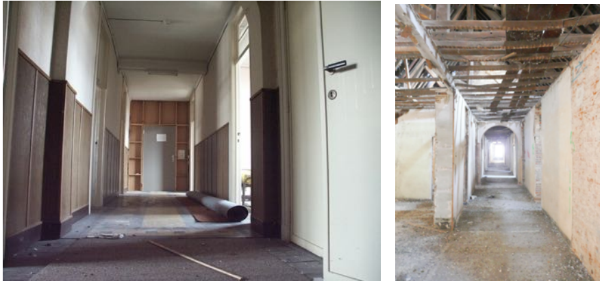
Hal van de derde verdieping voor en na het stippen van de afwerklaag
