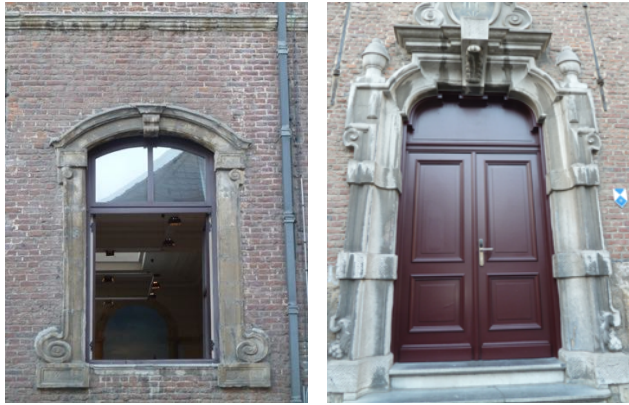
Raam en deur gelijkvloers
