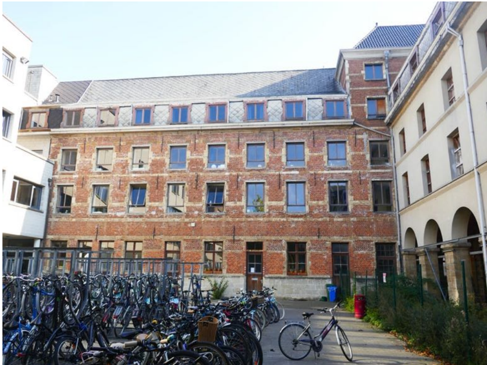
Huidige gevel pand A langs de speelplaats
