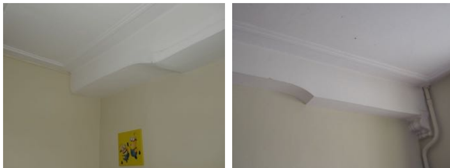
moerbalken 2 de verdieping
