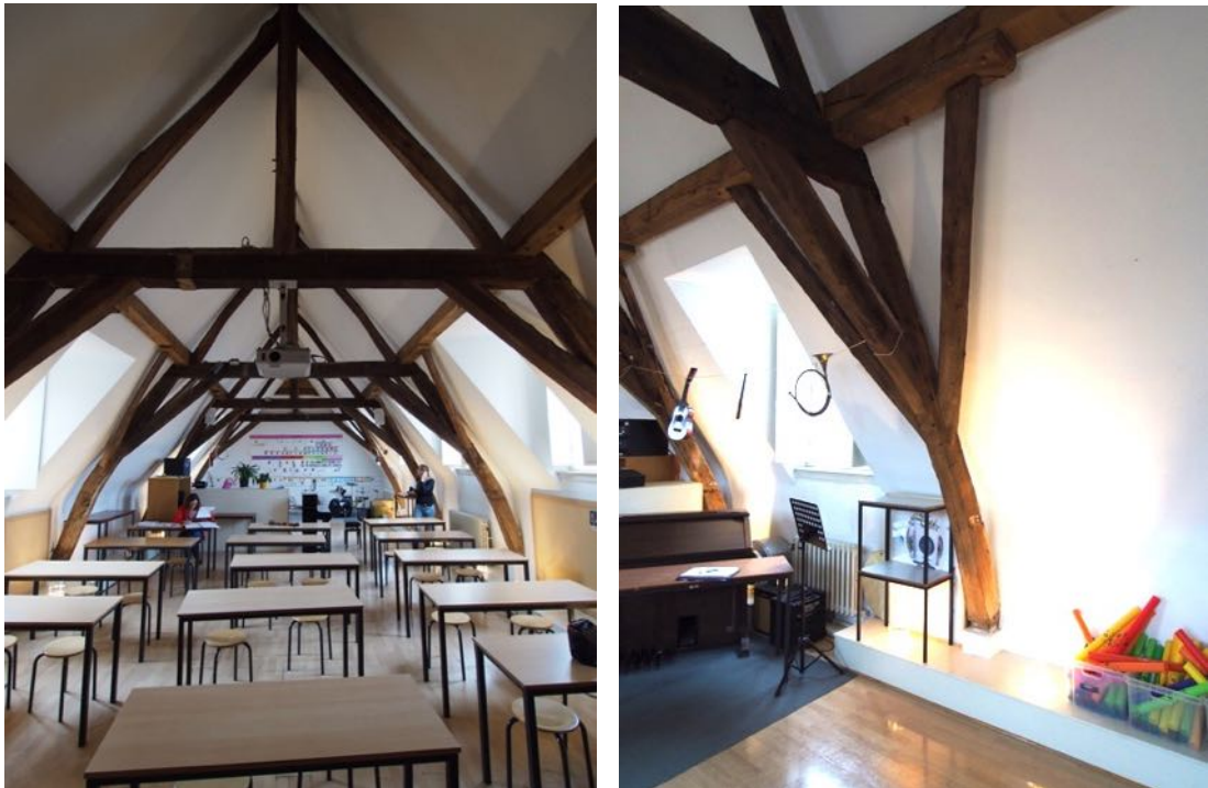
Houten kapstructuur op de tweede verdieping
