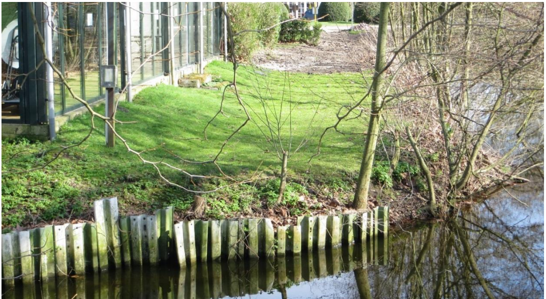
Figuur 3.2-64: Oeverbeschoeiing ter hoogte van de feestzaal
