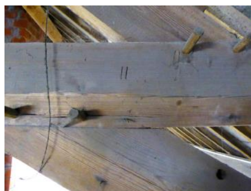
Hanenbalk met nummering, verbindingen zijn verzekerd door toognagels.
