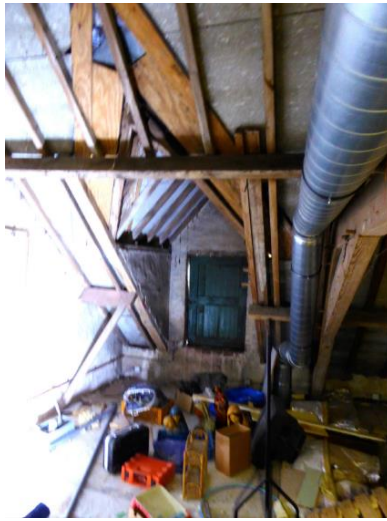
Recentere constructie van de dakkapel.
