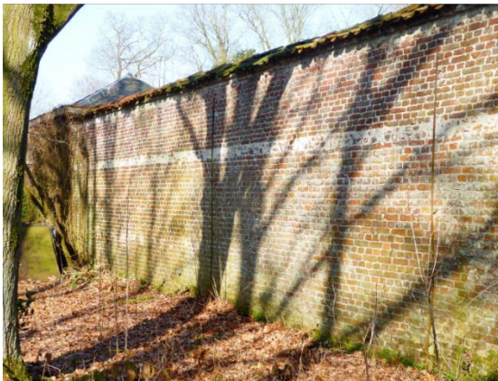
Twee speklagen versierden de muur. De bakstenen zijn op deze plaats opgeruwd om de pleister beter te kunnen vasthouden
