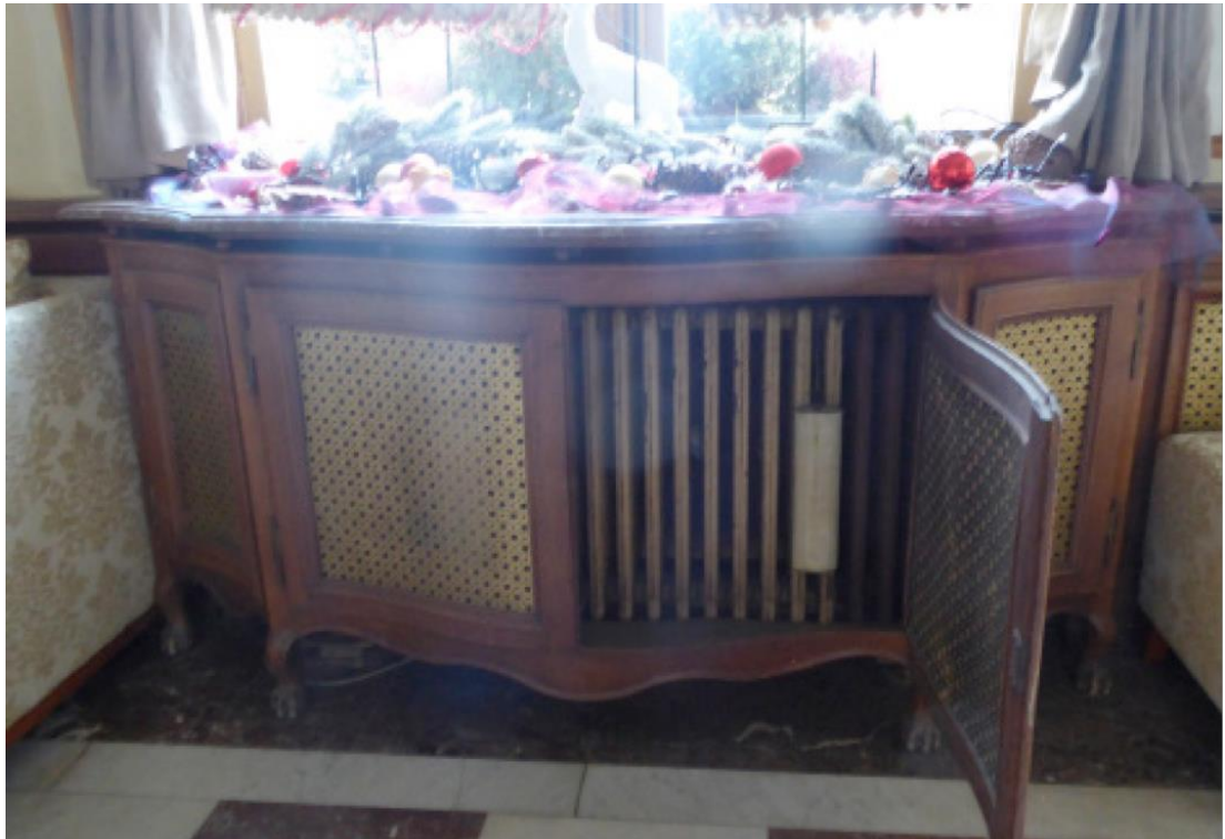
Aan de raamkant zijn enorme radiatorkasten ingebouwd. De panelen zijn hier vervangen door decoratieve roosters. De inbreng van de radiatorkasten is technisch zeer goed uitgevoerd maar mist duidelijk inzicht op niveau van stijl en de regels van de interieurdecoratie.
