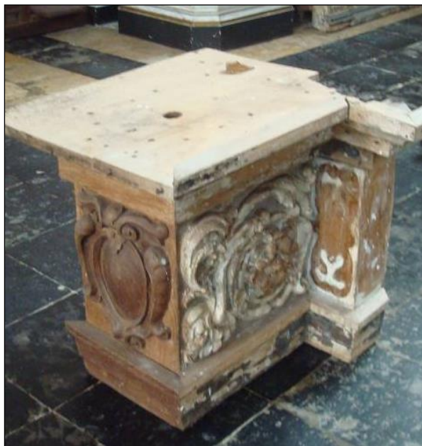
Architraaf huidige gedemonteerde toestand: Plaatselijke aantasting door houtborende insecten. Polychrome verflagen verdwenen.
