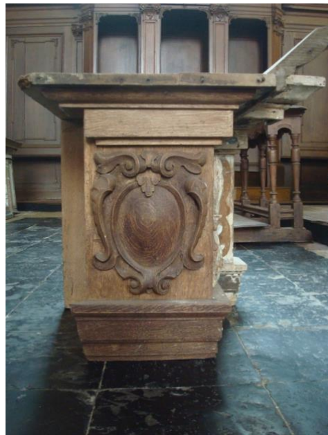
Architraaf huidige gedemonteerde toestand: Plaatselijke aantasting door houtborende insecten. Polychrome verflagen verdwenen.
