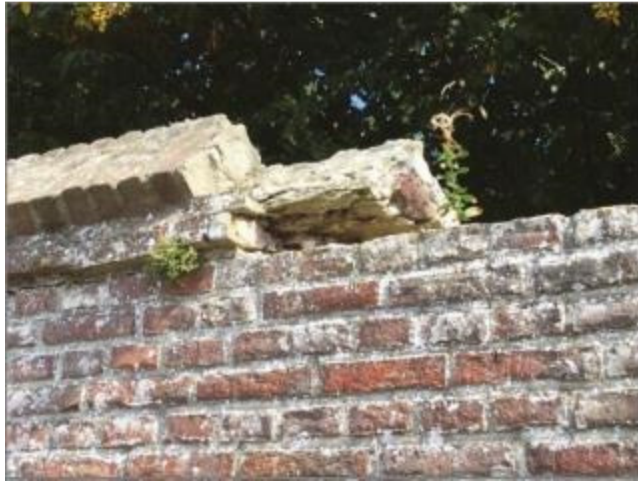
Detail van afdekking met ezelsrug
