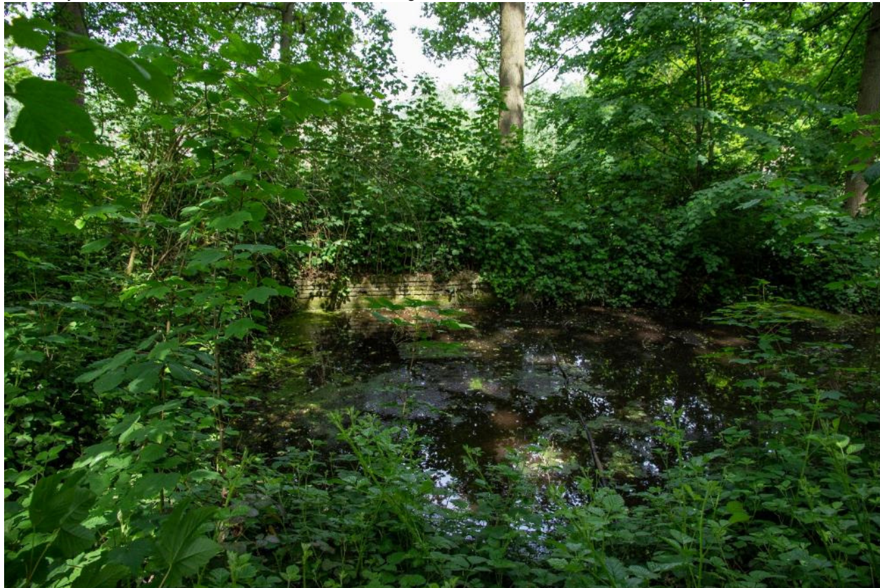
Spaarbekken met metselwerk muur
