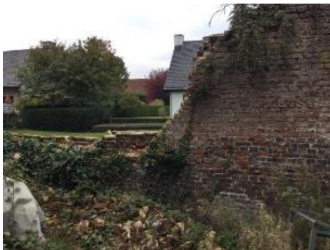
Ingestort deel van de ommuring langsheen de Gentstraat
