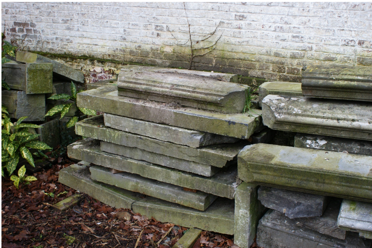
Restanten van natuursteen ornamenten gestockeerd aan de binnenzijde van de poort
