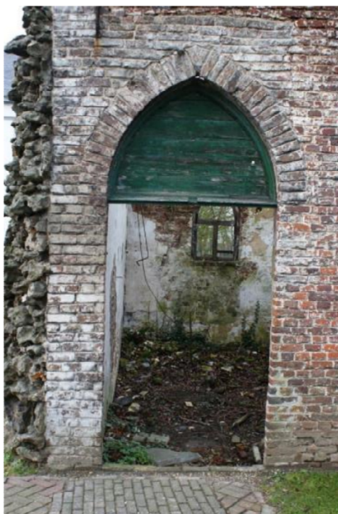
Ingang van de kluzenaarswoning kant van het kerkhof
