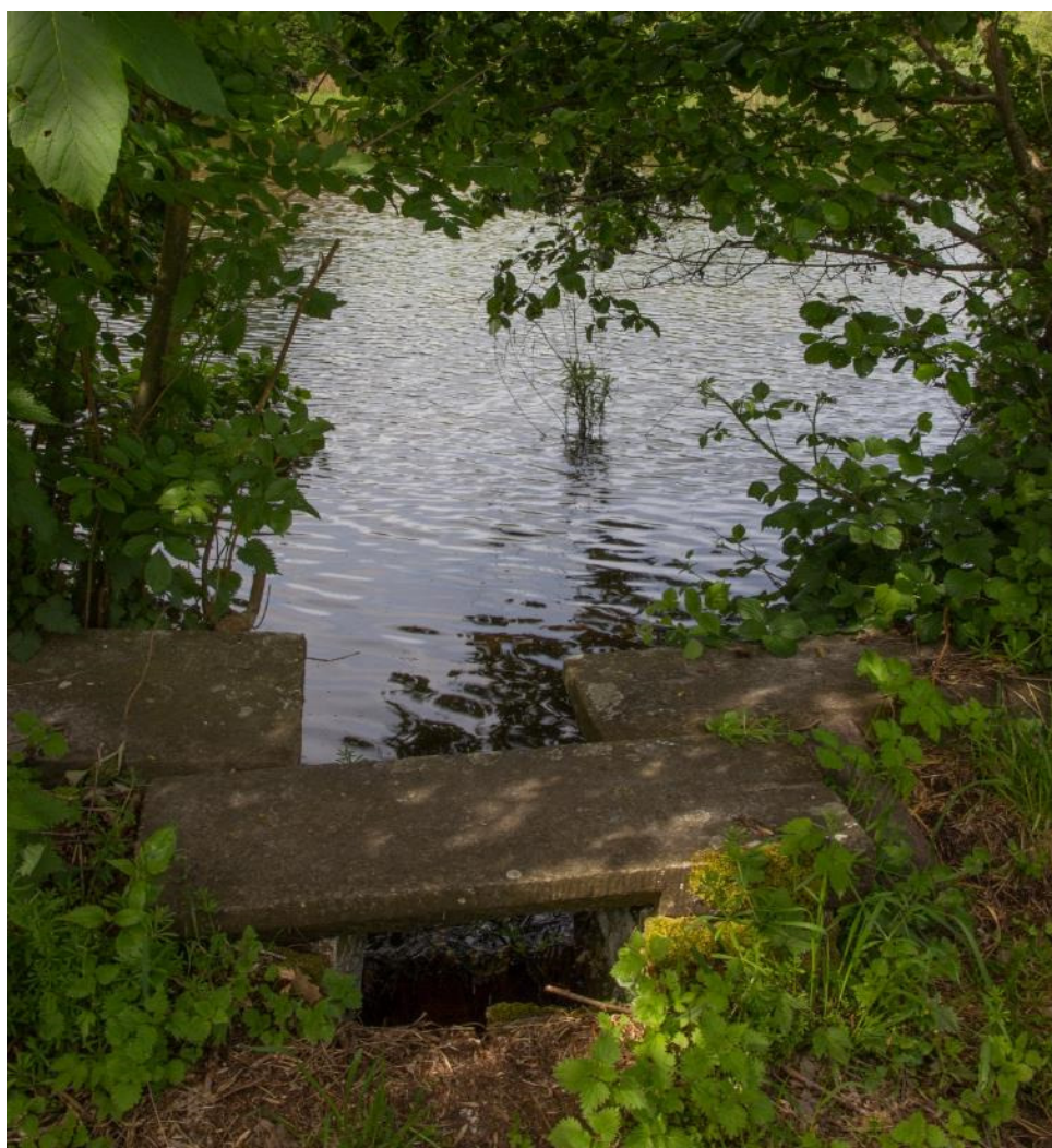
Arduinen constructie op westelijke serpentinegracht
