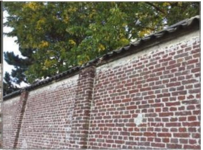
Deel van de omwalling in goede staat met afdekking met pannen
