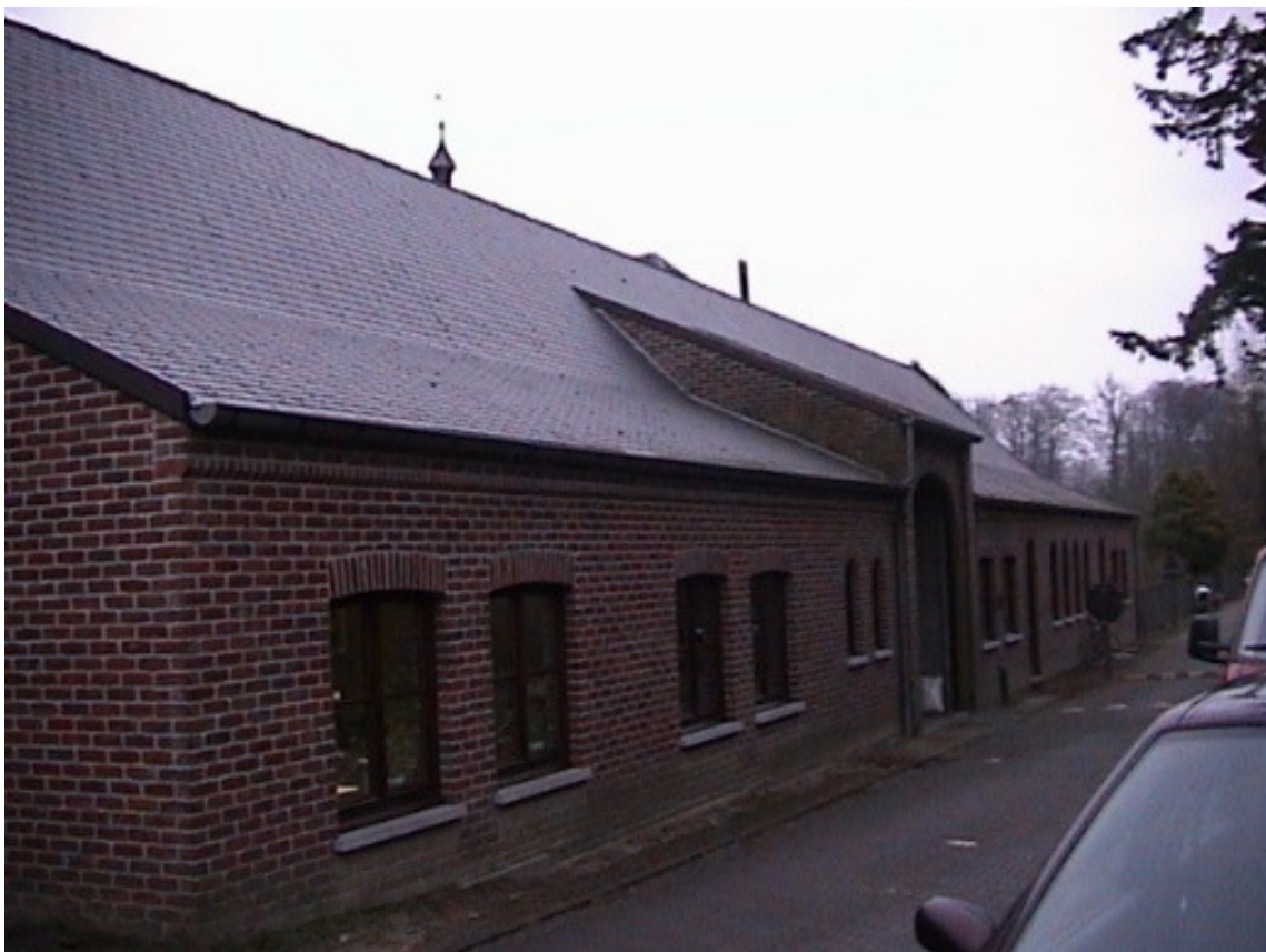
Zicht op het koetshuis in huidige toestand
