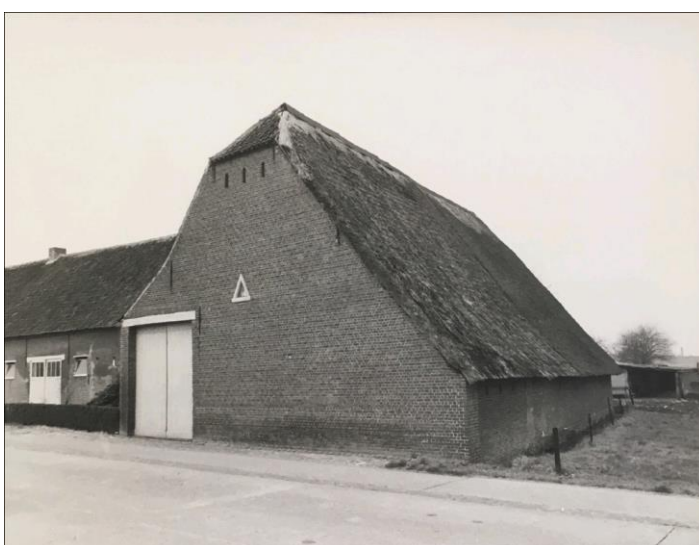
Figuur 1.1-7: Hagen langs de langsschuur (1975 - AOE)
